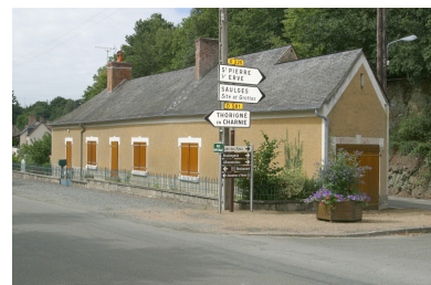
Elévation sur la rue nationale et sur le pignon nord. Phot. François Lasa IVR52_20035302360NUCA
