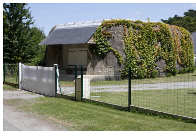
Le Clos-Bertin. Batterie secondaire 8/AR 275, dite Berta. Vue de la casemate n° 2, de type H 669. Phot. Denis Pillet IVR52_20084402121NUCA
