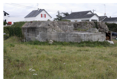
Clis. Vue du poste d'observation situé au bord de la route départementale 99. Phot. Denis Pillet IVR52_20074401671NUCA
