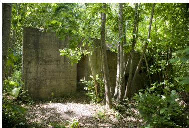
Cannevé. Vue de l'abri n° 1 (type H 668) depuis le nord. Phot. Denis Pillet IVR52_20094400223NUCA
