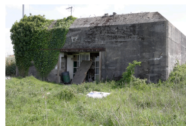
Villejames. Batterie secondaire 4/AR 275, dite Dora. Vue de la casemate n° 4, de type H 669.
