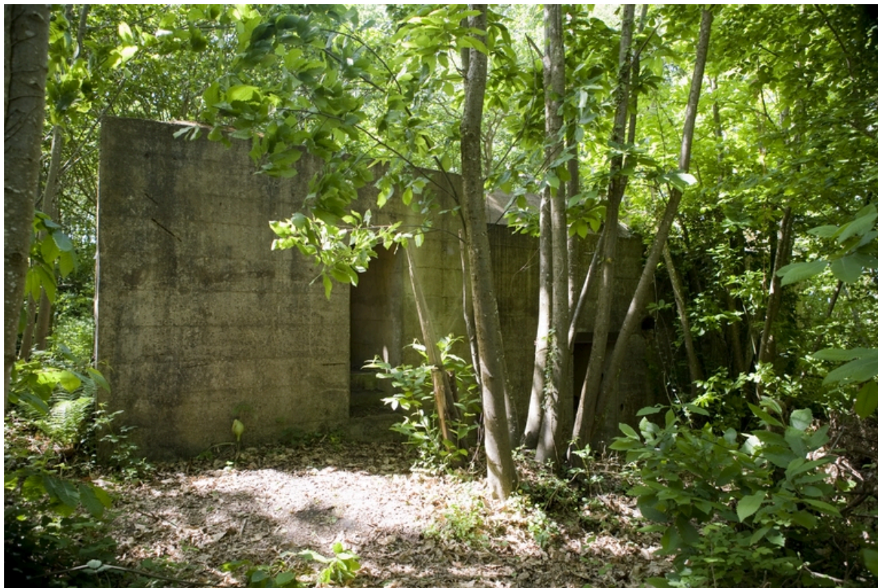
Cannevé. Vue de l'abri n° 1 (type H 668) depuis le nord.
