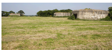
Cannevé. Vue d'ensemble de la batterie d'artillerie secondaire 5/AR 275, dite Emil. Phot. Denis Pillet IVR52_20084401757NUCA
