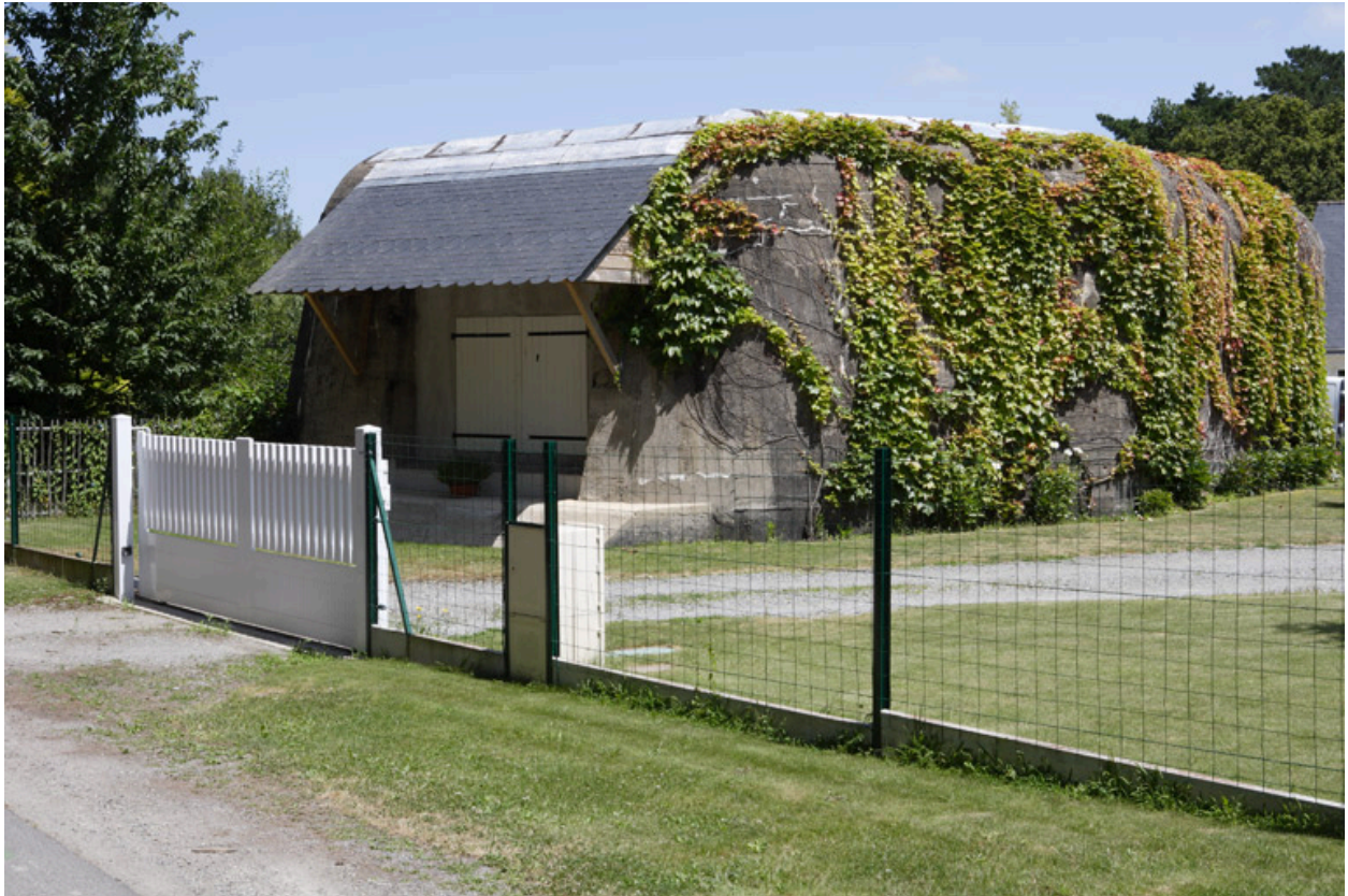
Le Clos-Bertin. Batterie secondaire 8/AR 275, dite Berta. Vue de la casemate n° 2, de type H 669.
