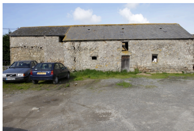
Vue de la façade est de l'ancien logis. Phot. Denis Pillet IVR52_20084400533NUCA
