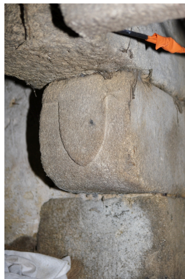
Détail du corbeau ouest, sculpté d'un blason, portant la hotte de la cheminée. Phot. Denis Pillet IVR52_20084400536NUCA
