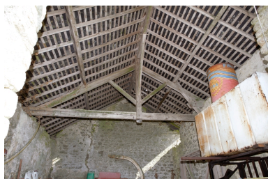
Vue de la charpente de la remise agricole. Phot. Denis Pillet IVR52_20084400532NUCA
