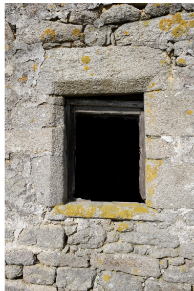
Détail de l'une des baies de la façade est. Phot. Denis Pillet IVR52_20084400530NUCA
