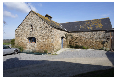
Détail du jour situé sur le pignon sud de l'étable. Phot. Denis Pillet IVR52_20084400522NUCA
