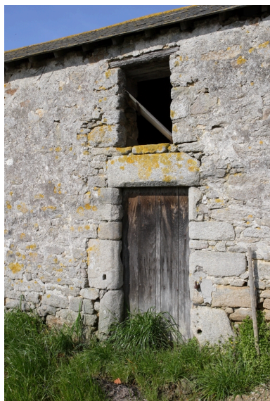
Détail de la porte d'entrée du logis. Phot. Denis Pillet IVR52_20084400531NUCA
