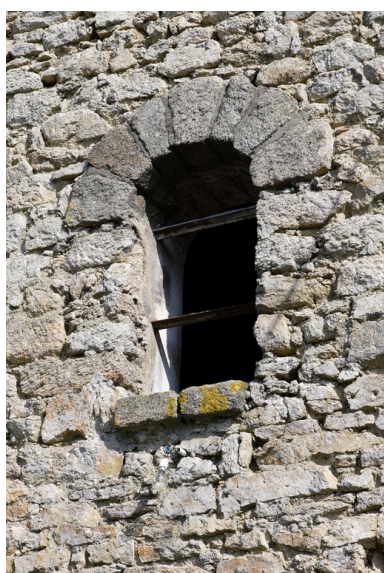
Détail du jour situé sur le pignon sud de l'étable. Phot. Denis Pillet IVR52_20084400523NUCA
