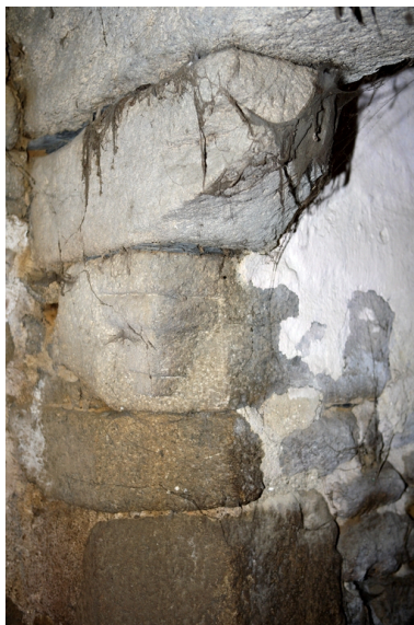
Détail du corbeau est portant la hotte de la cheminée. Phot. Denis Pillet IVR52_20084400535NUCA
