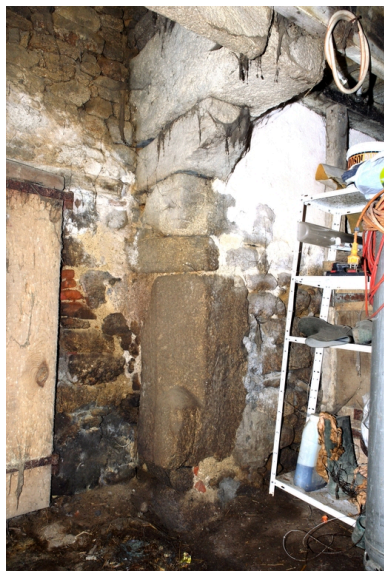
Détail du piédroit est de la cheminée du logis. Phot. Denis Pillet IVR52_20084400534NUCA
