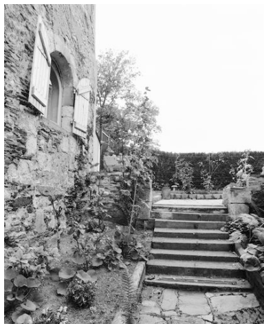
Vestiges de l'église : le seuil de la porte d'accès à la nef, vue depuis l'allée du cimetière. A gauche, ancienne porte d'accès à la cour d'entrée du presbytère (figurée sur le dessin de Ballain).
