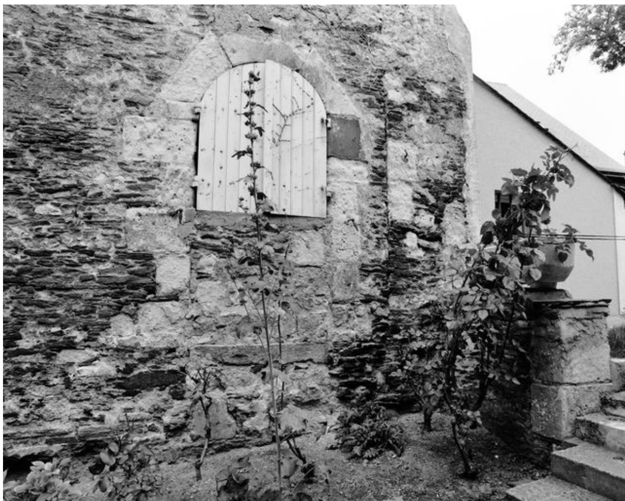
Angle du presbytère et de la nef de l'église : à gauche, porte murée de la cour d'entrée du presbytère. A droite, jambage gauche du seuil de la porte d'entrée de la nef.
