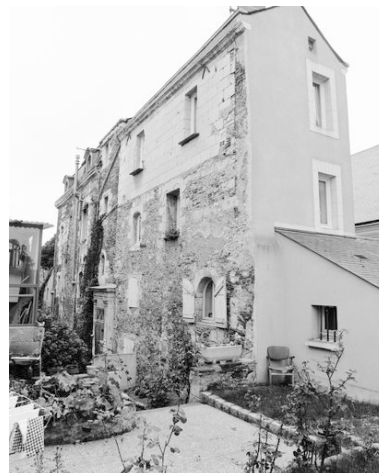
Vestiges de l'église : terre-plein correspondant au sol de la nef, avec au second plan, le seuil de la porte d'entrée donnant sur l'allée du cimetière. Au-delà, élévations du presbytère. Phot. François Lasa IVR52_19964901767X
