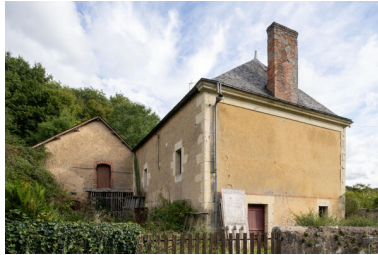
Logis (façade arrière) et parties agricoles. Phot. Jeanne Minier IVR52_20257200520NUCA
