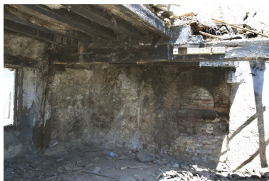
La cheminée. Phot. François Lasa IVR52_20045301949NUCA
