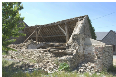
La façade arrière et le pignon nord avec la masse du four à pain. Phot. François Lasa IVR52_20045301947NUCA
