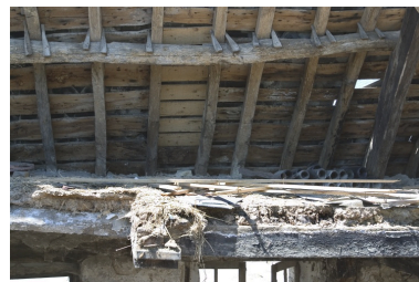
Coupe du plancher surmontant la pièce à cheminée et vue partielle du pan ouest de la charpente. Phot. François Lasa IVR52_20045301948NUCA
