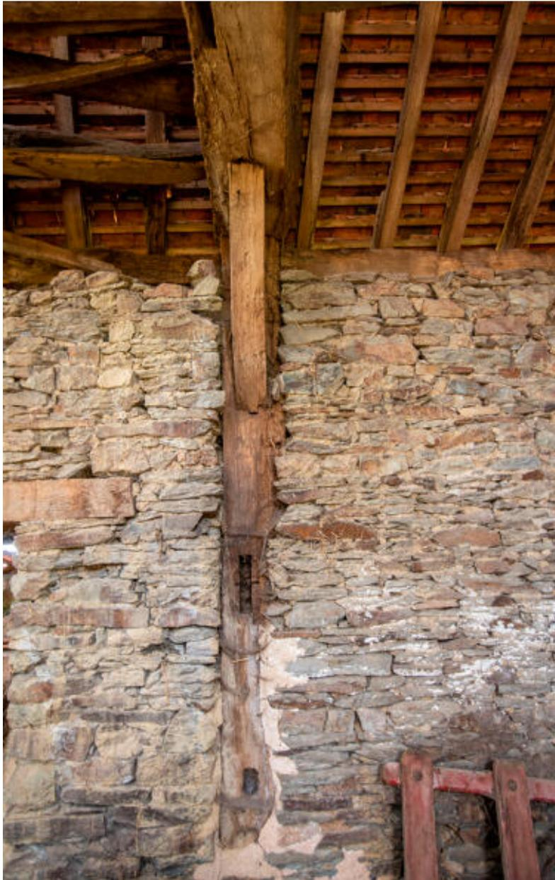
Ferme est, corps de bâtiment ouest, structure à poteaux porteurs.
