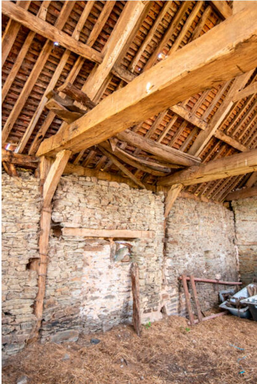
Ferme est, corps de bâtiment ouest, structure à poteaux porteurs.
