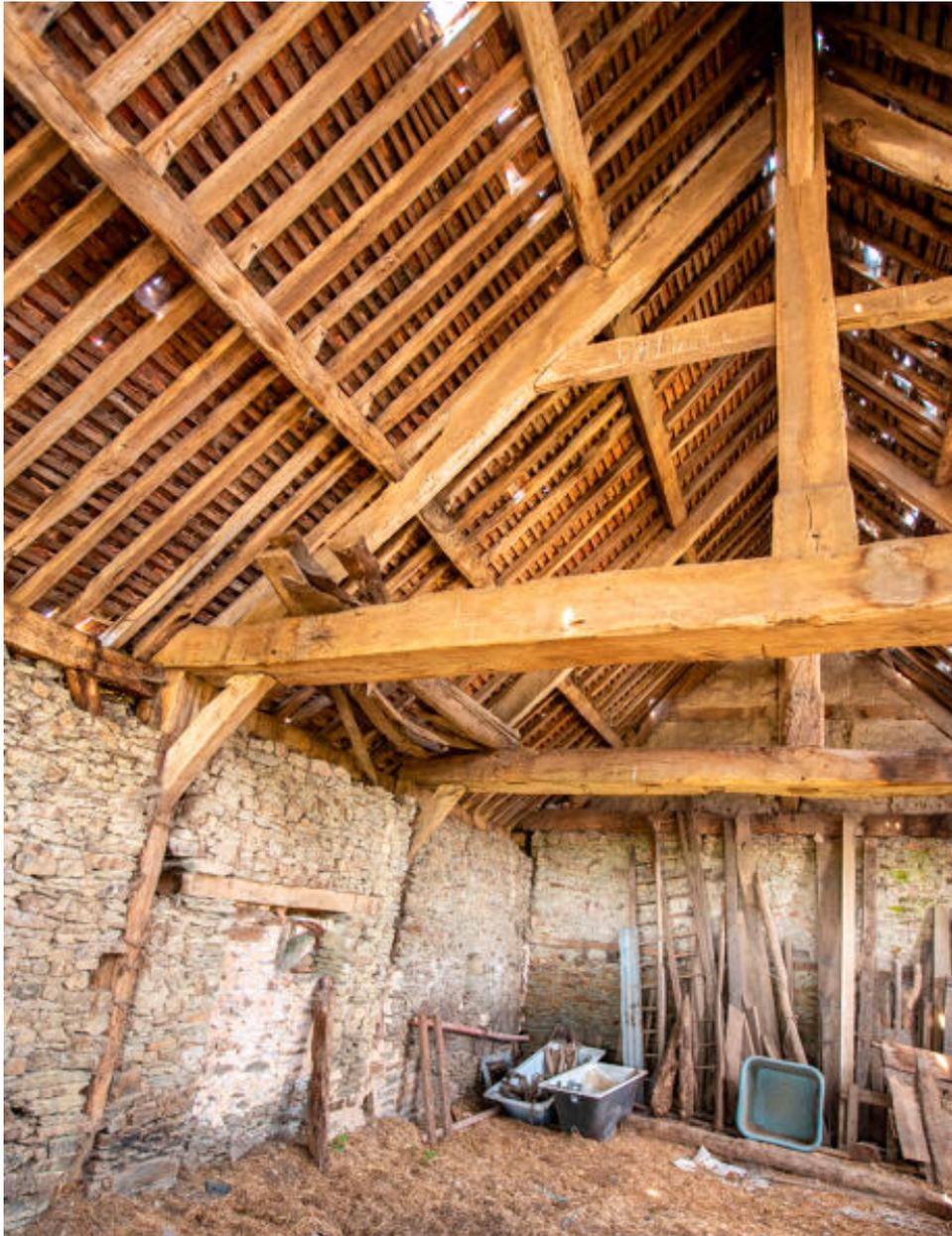
Ferme est, corps de bâtiment ouest, structure à poteaux porteurs.
