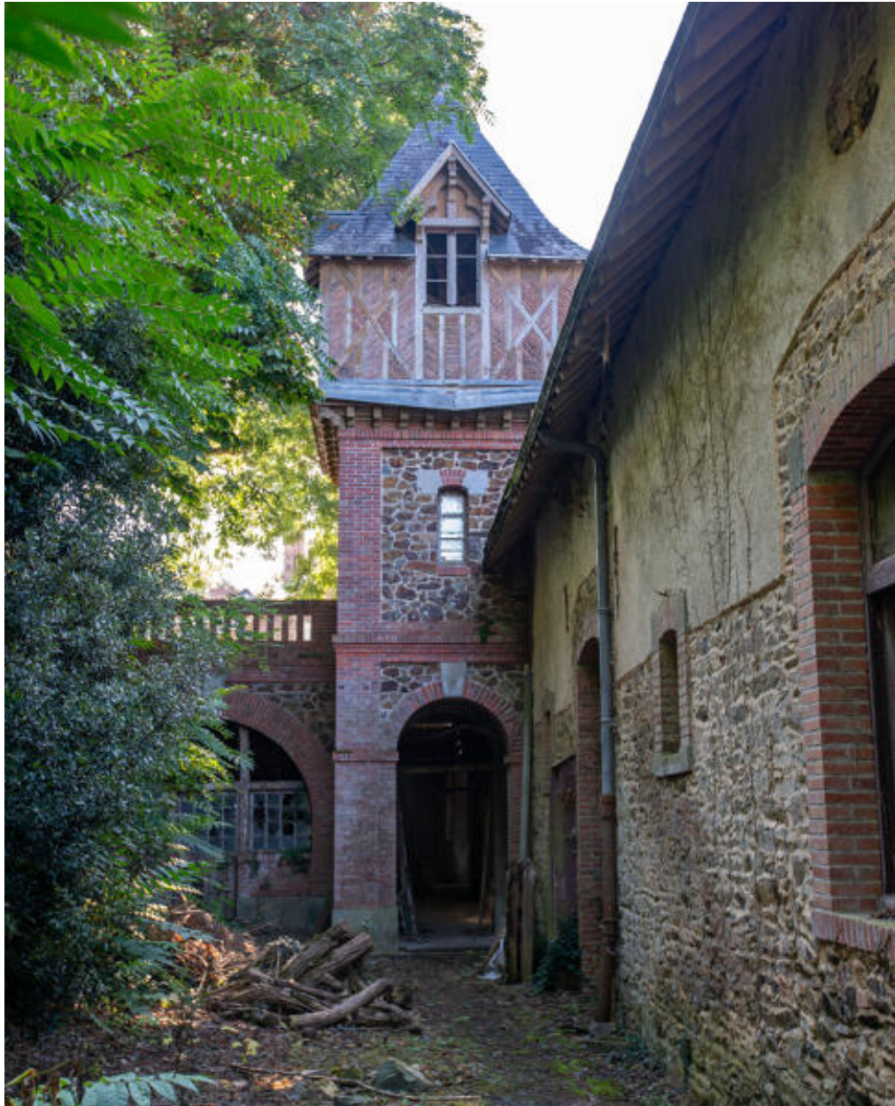
La tour château d'eau et l'escalier des cochers.
