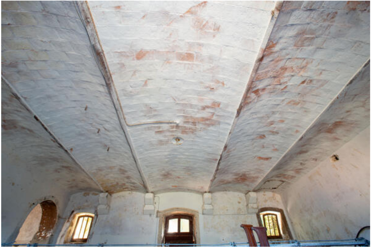
L'écurie, détail d'un plafond.
