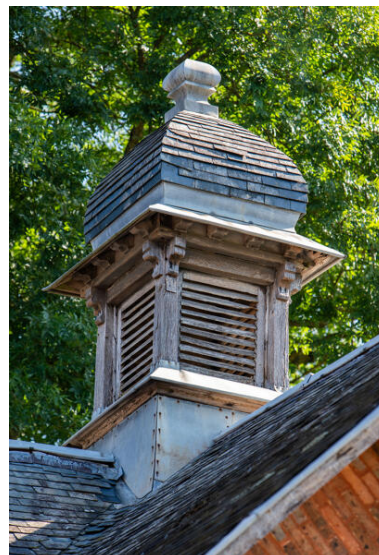
Le lanternon du séchoir. Phot. Pierre-Bernard Fourny IVR52_20235301449NUCA
