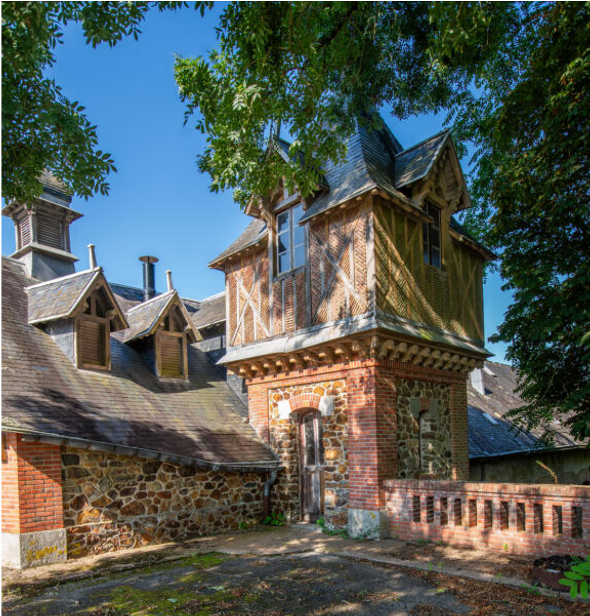
La tour château d'eau.
