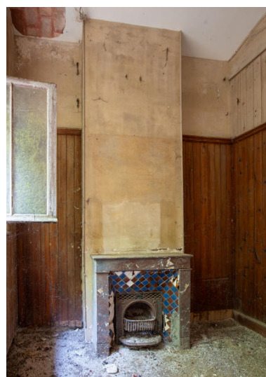
Une cheminée dans l'écurie. Phot. Pierre-Bernard Fourny IVR52_20235301416NUCA
