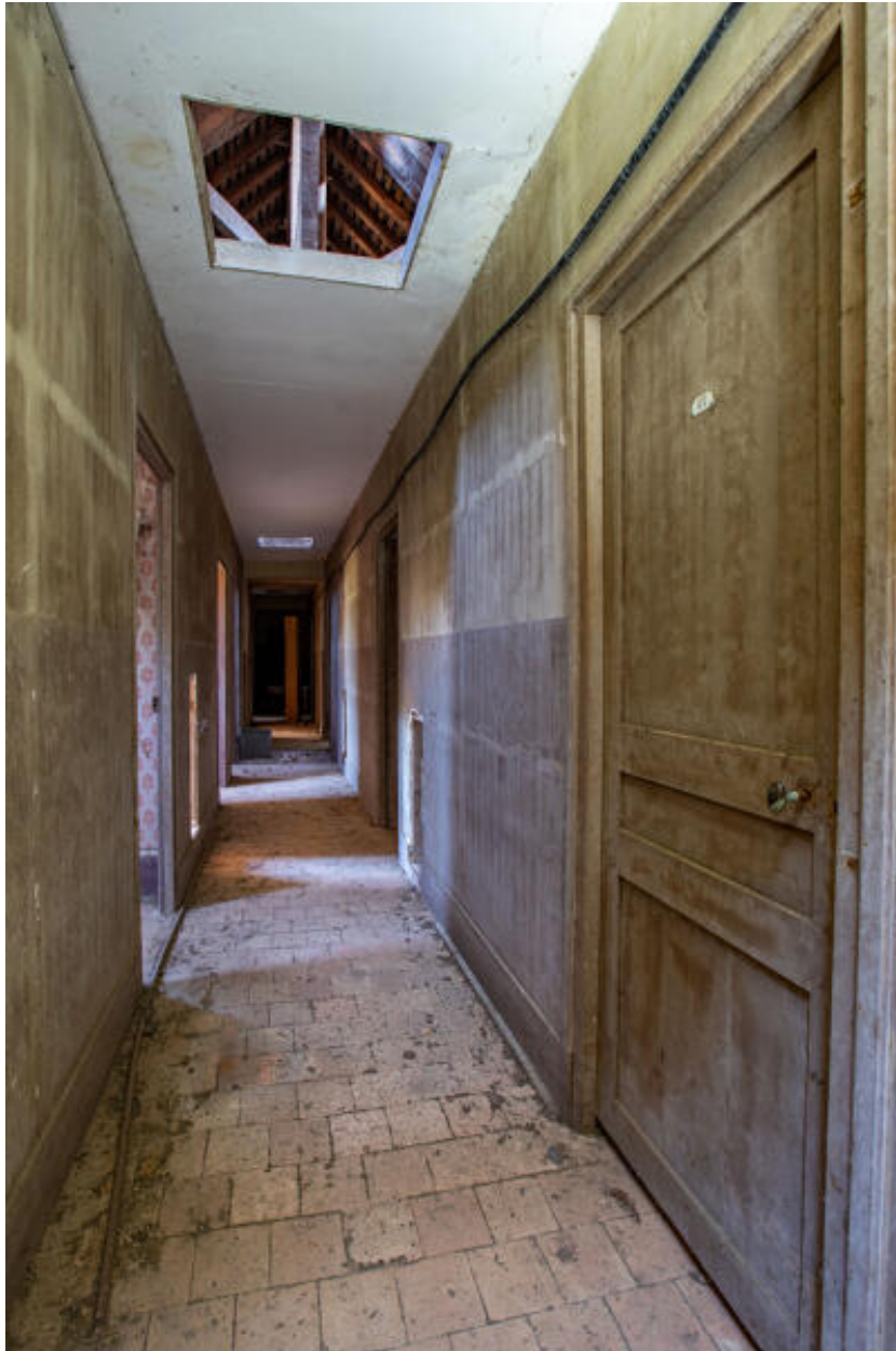
Le couloir des chambres des garçons d'écurie.
