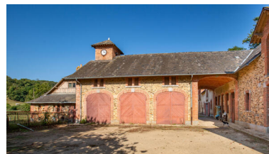
Les remises et le passage couvert. Phot. Pierre-Bernard Fourny IVR52_20235301442NUCA
