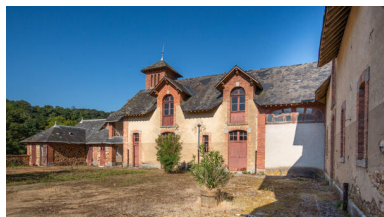
Les bâtiments depuis la cour. Phot. Pierre-Bernard Fourny IVR52_20235301441NUCA
