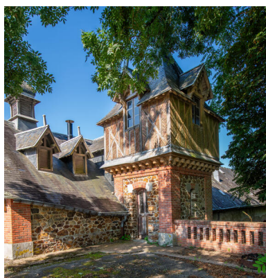
La tour château d'eau. Phot. Pierre-Bernard Fourny IVR52_20235301474NUCA
