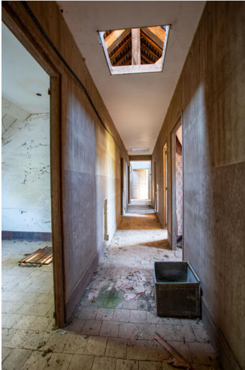
Le couloir des chambres des garçons d'écurie.
