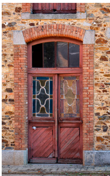
La porte de la sellerie. Phot. Pierre-Bernard Fourny IVR52_20235301451NUCA
