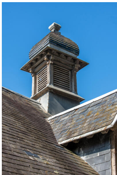
Le lanternon du séchoir. Phot. Pierre-Bernard Fourny IVR52_20235301478NUCA
