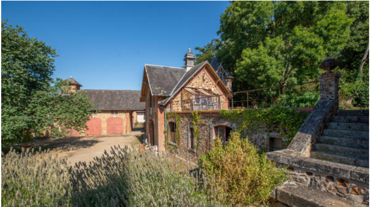
Les remises, le séchoir et la buanderie.
