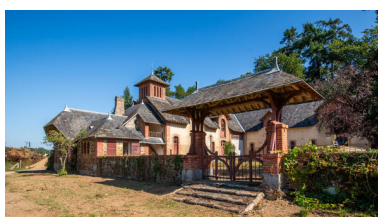
Le portail couvert de la cour. Phot. Pierre-Bernard Fourny IVR52_20235301460NUCA
