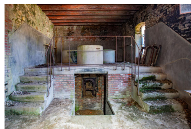
La buanderie, le four et les cuves. Phot. Pierre-Bernard Fourny IVR52_20235301430NUCA
