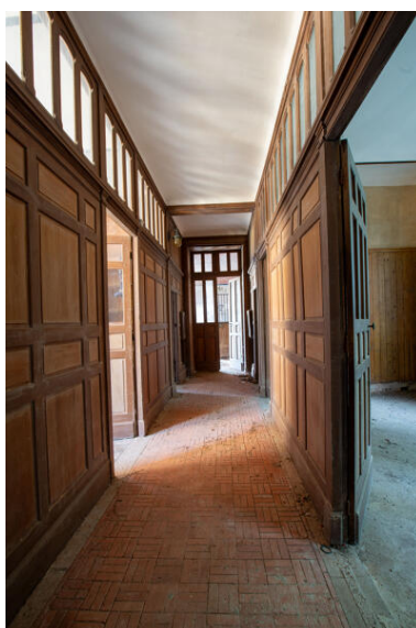
Le couloir de l'écurie. Phot. Pierre-Bernard Fourny IVR52_20235301415NUCA
