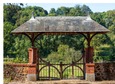
Le portail couvert de la cour. Phot. Pierre-Bernard Fourny IVR52_20235301457NUCA
