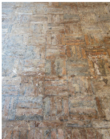
L'écurie, détail du sol. Phot. Pierre-Bernard Fourny IVR52_20235301423NUCA
