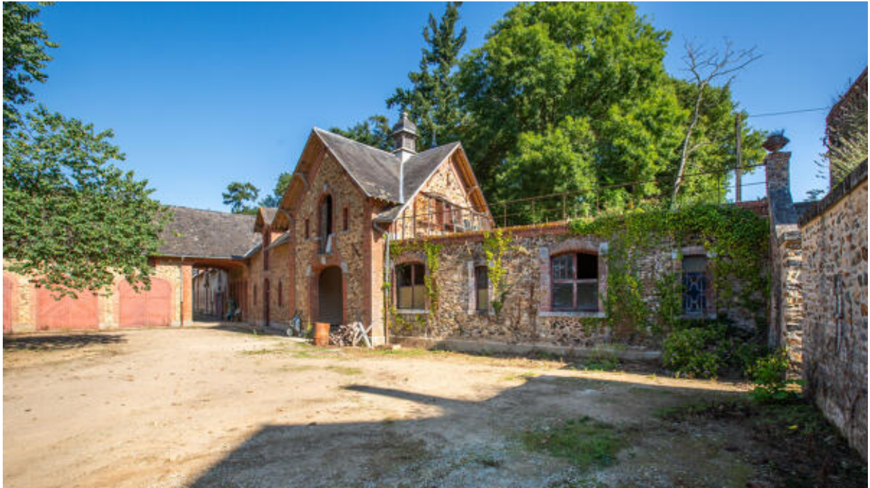
Les remises, le séchoir et la buanderie.
