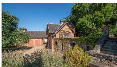
Les remises, le séchoir et la buanderie. Phot. Pierre-Bernard Fourny IVR52_20235301471NUCA
