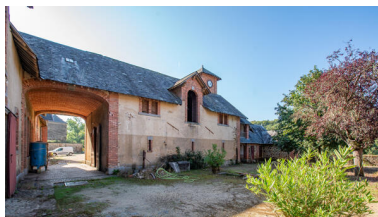
Les remises et le passage couvert. Phot. Pierre-Bernard Fourny IVR52_20235301440NUCA
