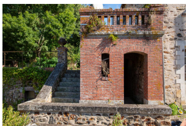
L'entrée de l'escalier menant à la buanderie depuis la terrasse du château. Phot. Pierre-Bernard Fourny IVR52_20235301472NUCA
