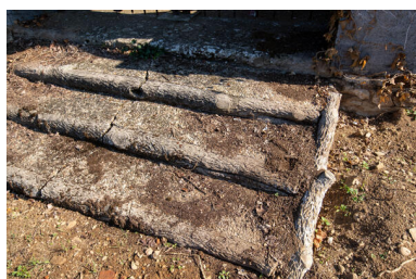
Le portail couvert de la cour, détail des marches en ciment. Phot. Pierre-Bernard Fourny IVR52_20235301461NUCA
