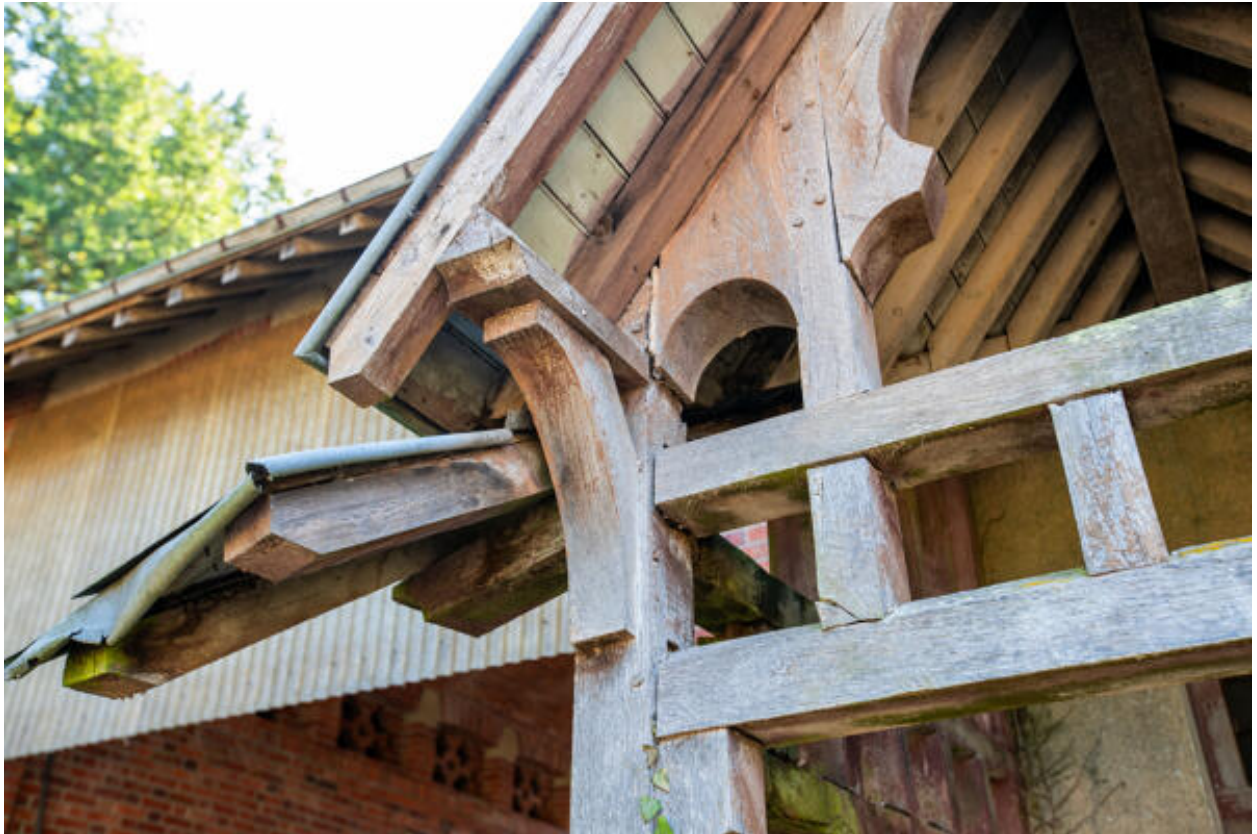
Le porche de la laiterie, détail.
