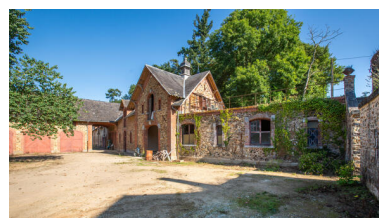
Les remises, le séchoir et la buanderie. Phot. Pierre-Bernard Fourny IVR52_20235301443NUCA
