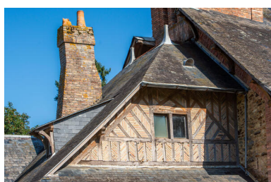
Le chenil, détail du pan-de-bois. Phot. Pierre-Bernard Fourny IVR52_20235301447NUCA
