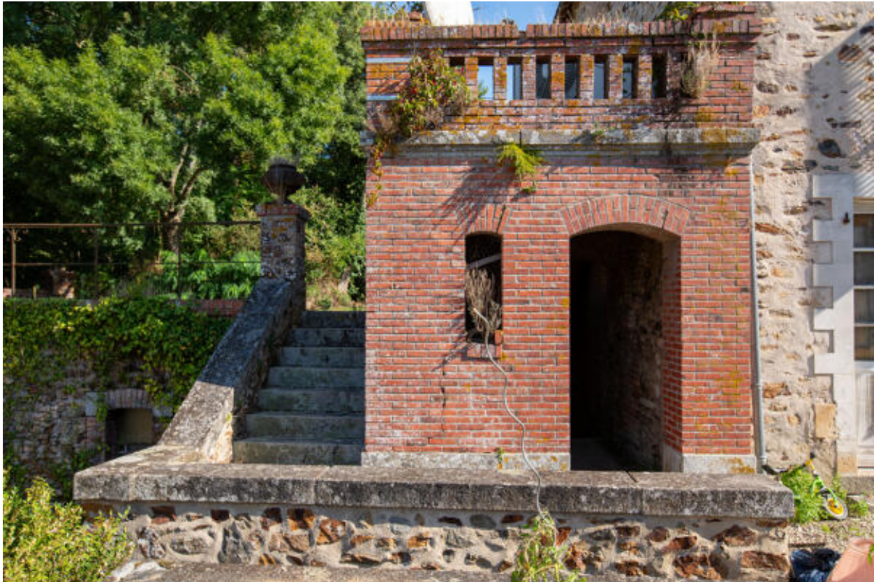
L'entrée de l'escalier menant à la buanderie depuis la terrasse du château.
