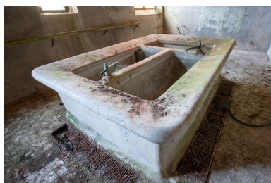
La buanderie, le lavoir. Phot. Pierre-Bernard Fourny IVR52_20235301426NUCA
