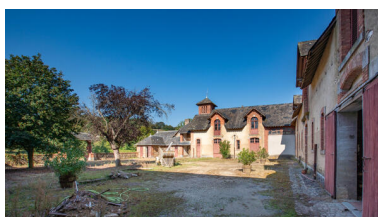
Les bâtiments depuis la cour. Phot. Pierre-Bernard Fourny IVR52_20235301438NUCA
