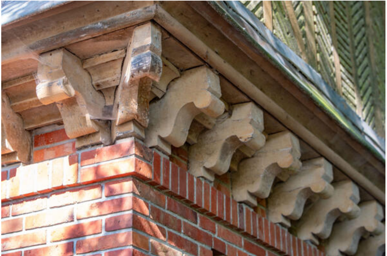
La tour château d'eau, détail de l'encorbellement.
