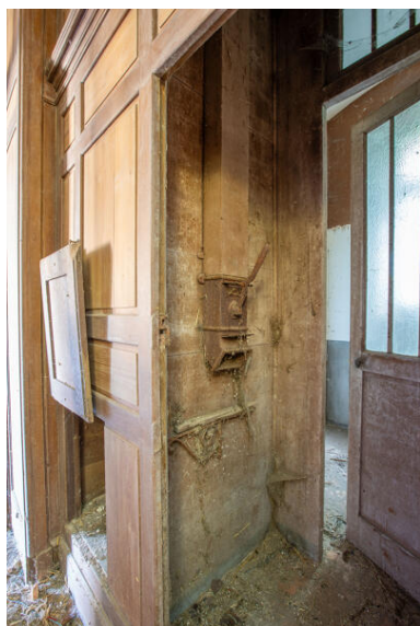
L'écurie, trémie pour le grain. Phot. Pierre-Bernard Fourny IVR52_20235301420NUCA
