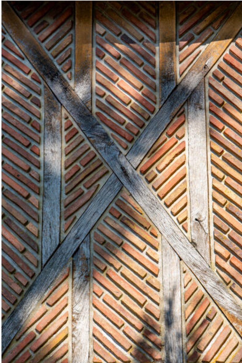
La tour château d'eau, détail du pan-de-bois.
