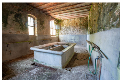
La buanderie. Phot. Pierre-Bernard Fourny IVR52_20235301425NUCA
