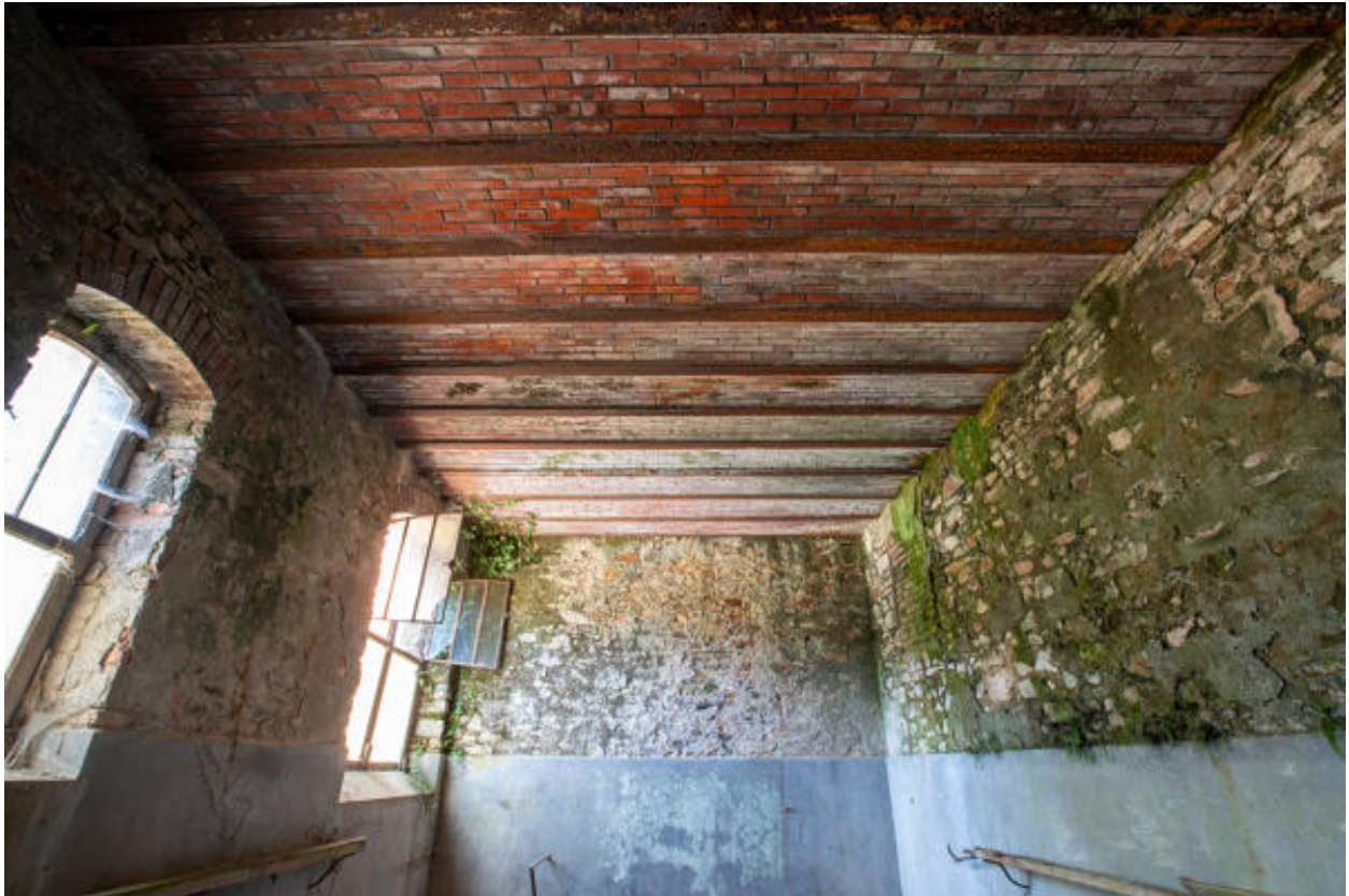
La buanderie, détail du plafond.
