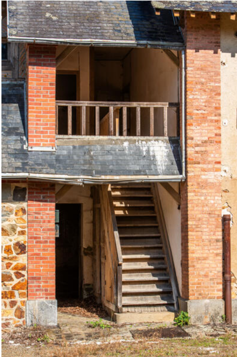
L'escalier attenant au poulailler.
