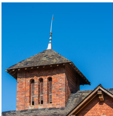
Le clocheton de l'aile nord des communs. Phot. Pierre-Bernard Fourny IVR52_20235301453NUCA
