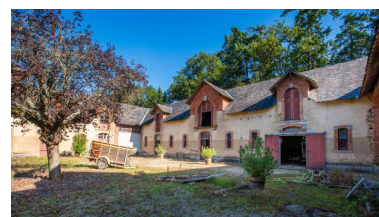
Les bâtiments depuis la cour. Phot. Pierre-Bernard Fourny IVR52_20235301439NUCA
