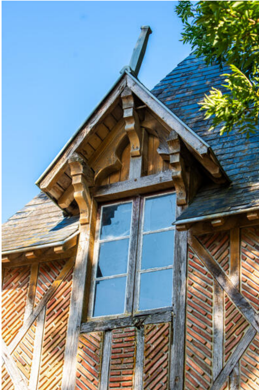
La tour château d'eau, détail d'une lucarne.
