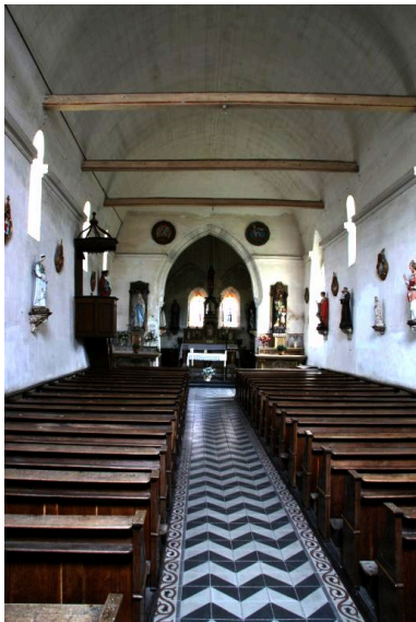
La nef, vue prise de l'entrée. Phot. Jean-Baptiste Darrasse IVR52_20077201220NUCA
