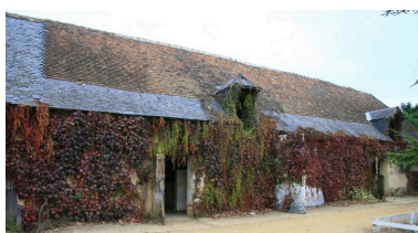
La grange-étable. Phot. Jean-Baptiste Darrasse IVR52_20077202543NUCA
