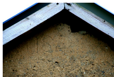
Les écuries : pignon portant la date 1848. Phot. Jean-Baptiste Darrasse IVR52_20077202545NUCA
