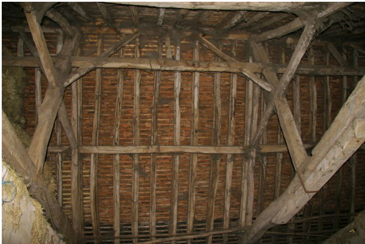
La grange-étable : charpente à pannes et sous-faîtage.
