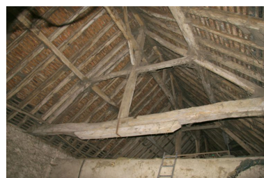
La grange-étable : charpente à pannes. Phot. Jean-Baptiste Darrasse IVR52_20077202546NUCA
