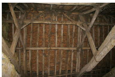
La grange-étable : charpente à pannes et sous-faîtage. Phot. Jean-Baptiste Darrasse IVR52_20077202547NUCA
