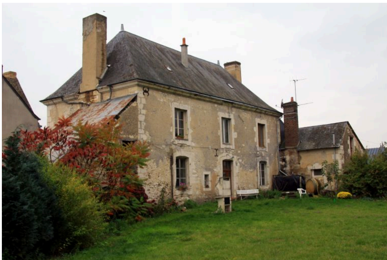
Façade sur cour.
