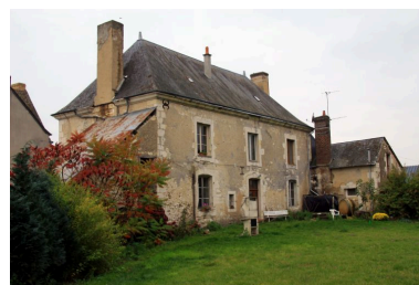
Façade sur cour. Phot. Jean-Baptiste Darrasse IVR52_20077202541NUCA
