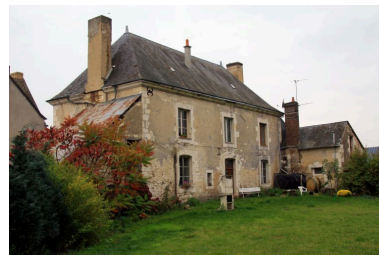
Façade sur cour. Phot. Jean-Baptiste Darrasse IVR52_20077202541NUCA
