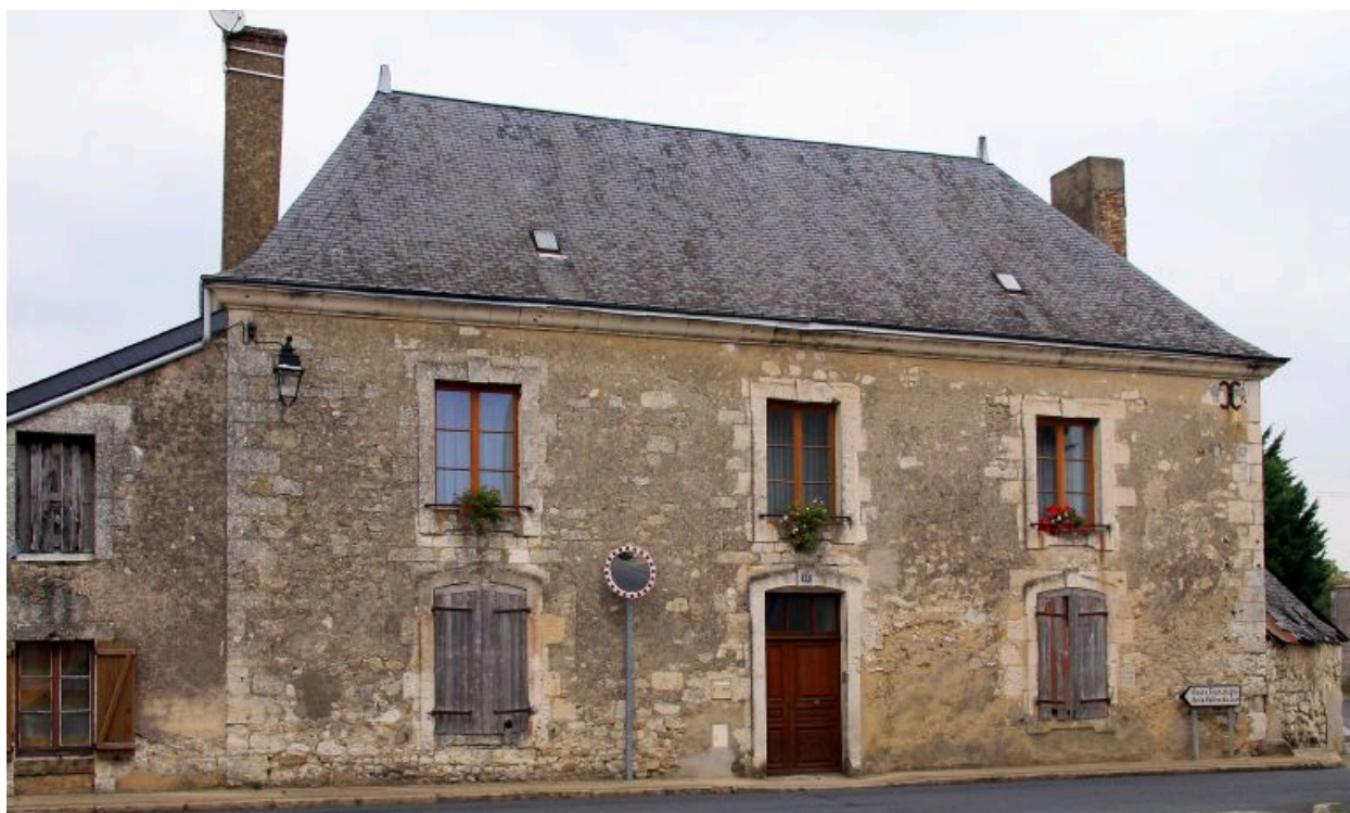
Façade antérieure sur rue.
