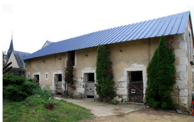
Les écuries du milieu du XIXe siècle. Phot. Jean-Baptiste Darrasse IVR52_20077202544NUCA
