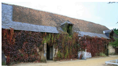
La grange-étable. Phot. Jean-Baptiste Darrasse IVR52_20077202543NUCA
