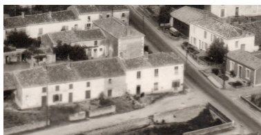
Le café Thevin sur une vue aérienne vers 1950. Phot. Yannis (reproduction) Suire IVR52_20198502483NUCA
