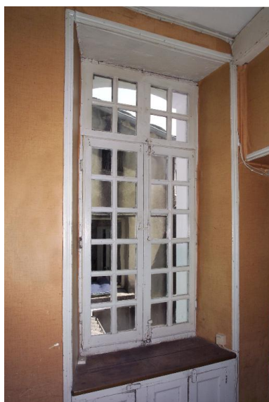
La baie de l'escalier au premier étage, en arrière-plan, la façade du corps secondaire de la maison n° 29.
