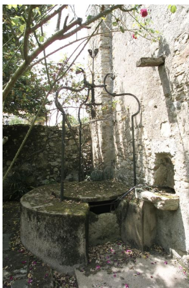
Le puits situé au sud de l'ensemble. Phot. Denis Pillet IVR52_20034400482NUCA
