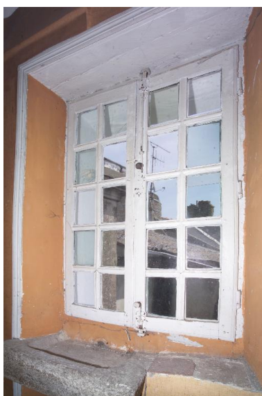
L'escalier, la baie située au niveau de l'étage de comble.
