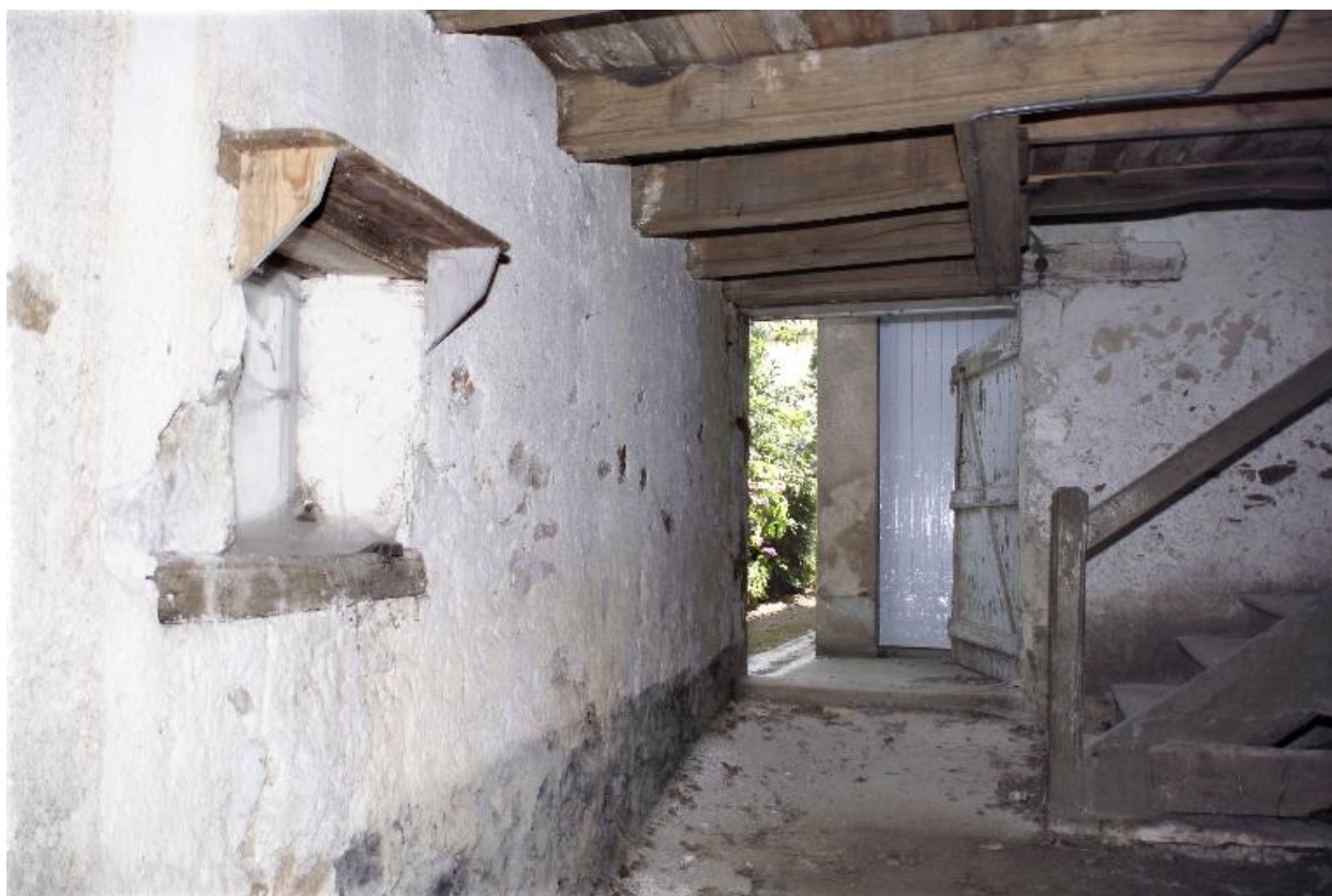
Le corps en appentis situé au sud du corps secondaire, vue prise vers le jardin.
