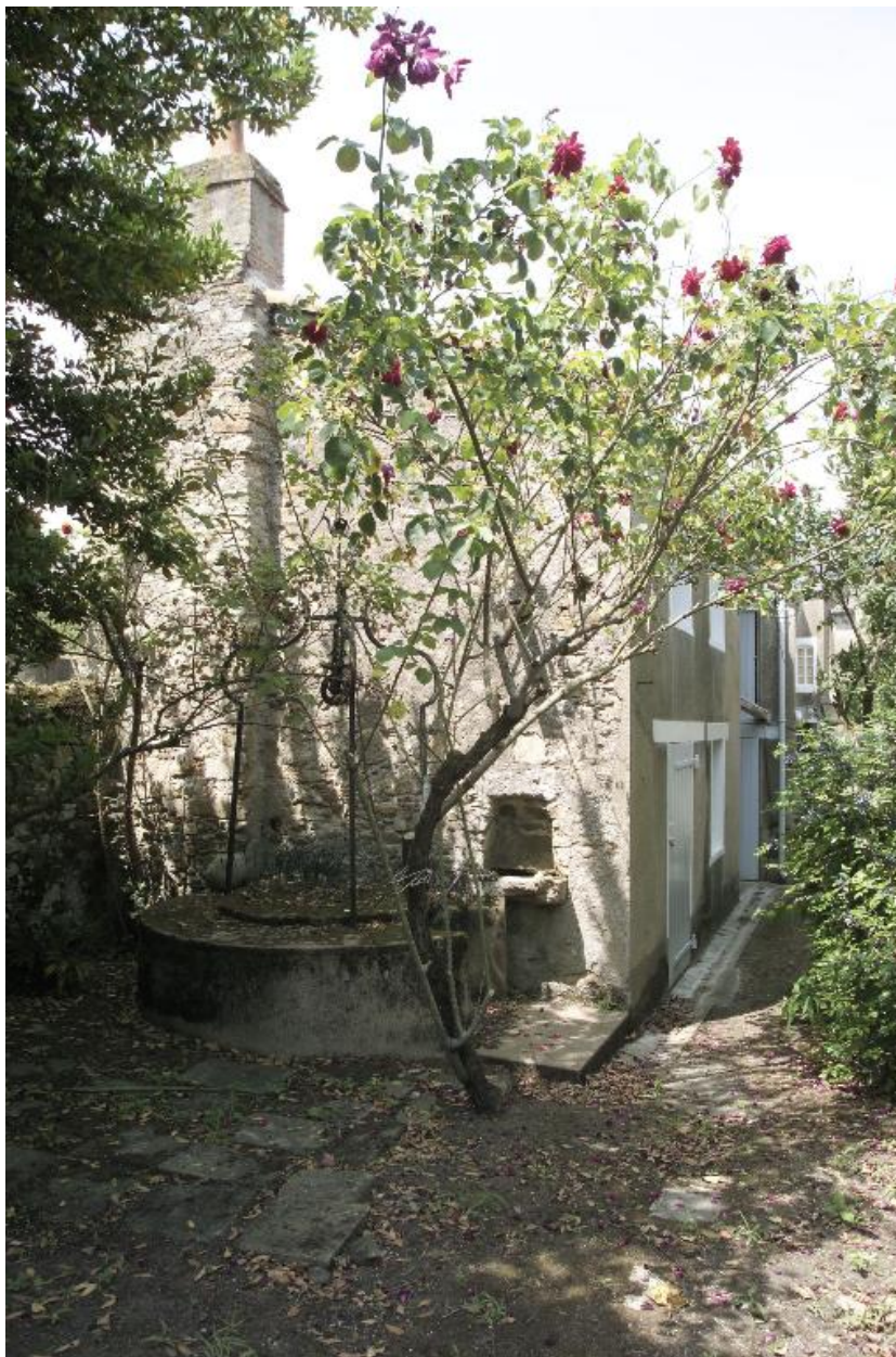
Le deuxième corps en appentis situé au sud du corps secondaire vu depuis le jardin.
