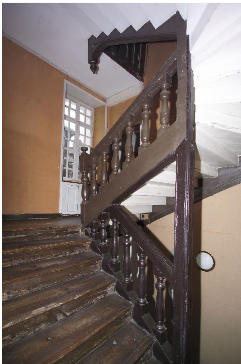
L'escalier, vue prise vers le palier du premier étage.
