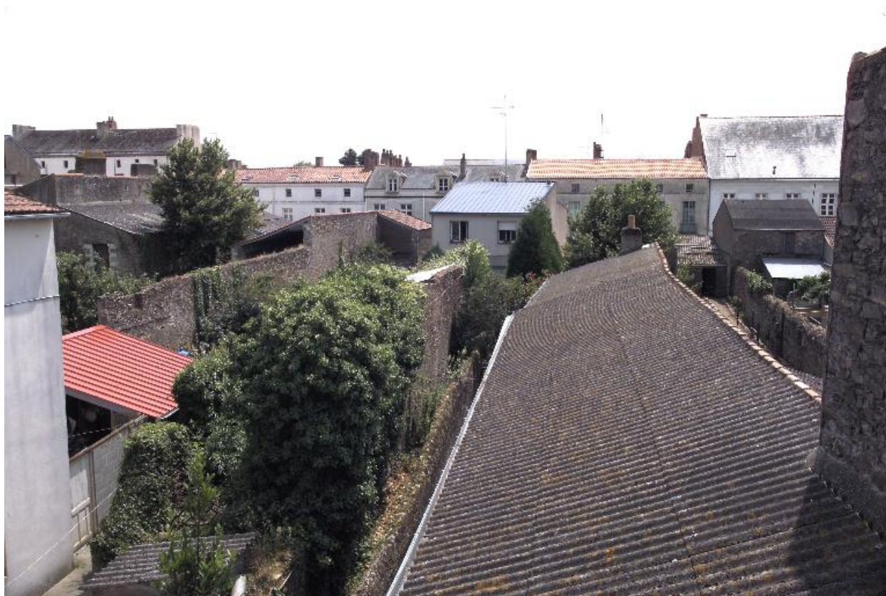
La couverture du corps secondaire, vue depuis le corps principal.
