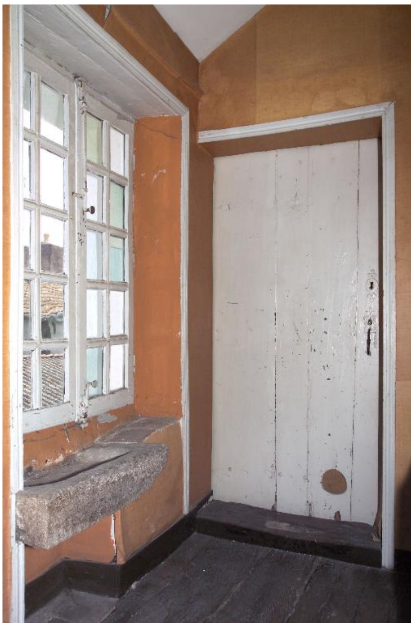
Le corps secondaire, la porte d'accès à l'étage de comble depuis l'escalier.
