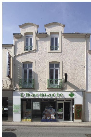
La façade antérieure. Phot. Denis Pillet IVR52_20034400369NUCA
