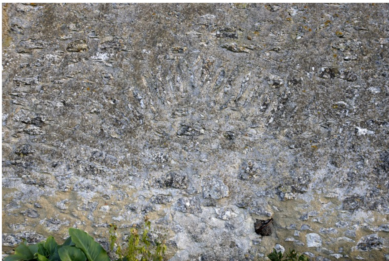
La première étable, partie ouest, façade nord : arc de décharge cintré.
