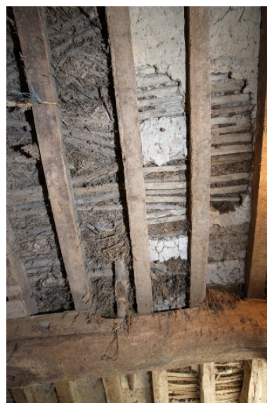
La première étable, pièce ouest : détail du plancher. Phot. François Lasa IVR52_20065302671NUCA
