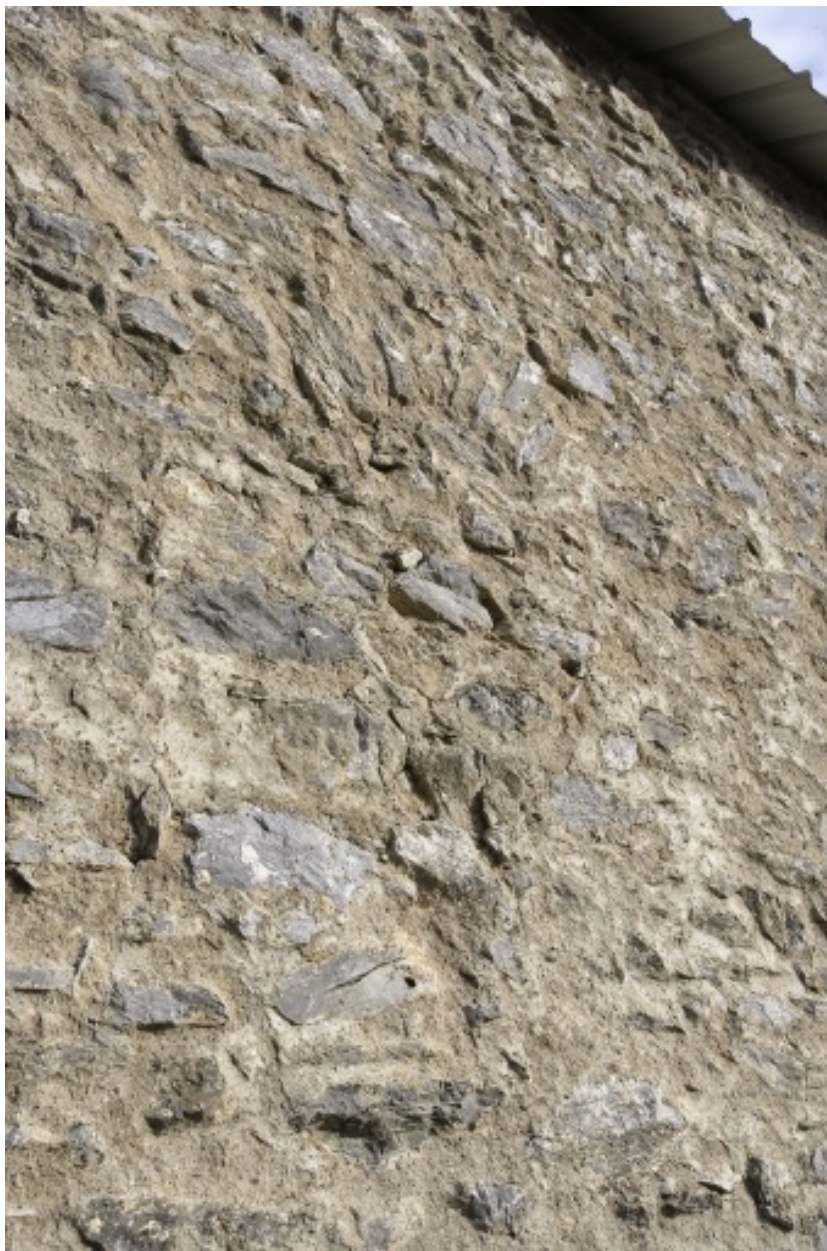
Bâtiment sud, mur sud : arc (d'une ouverture bouchée ?).
