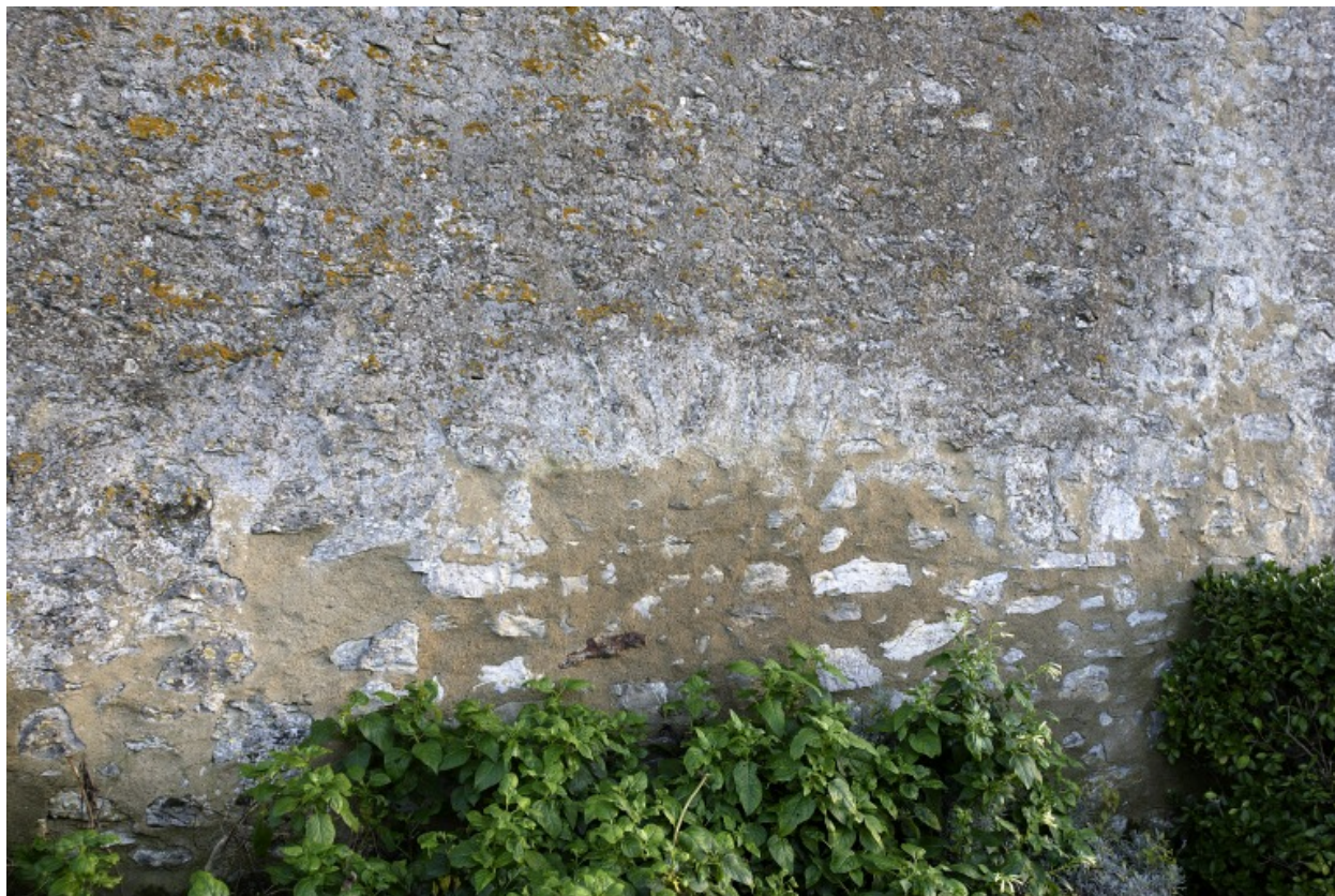
La première étable, partie ouest, façade nord : porte bouchée encadrée de deux niches.
