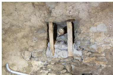
Le colombier : jour situé en partie basse vu depuis l'intérieur. Phot. François Lasa IVR52_20065302782NUCA
