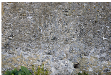
La première étable, partie ouest, façade nord : arc de décharge cintré. Phot. François Lasa IVR52_20065302718NUCA
