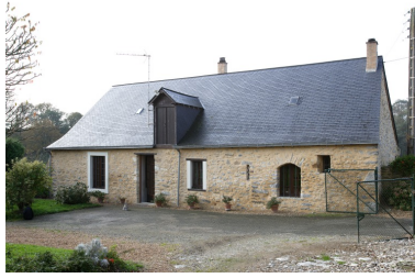
Le logis vu depuis la cour, au nord-est : façade antérieure. Phot. François Lasa IVR52_20065302669NUCA
