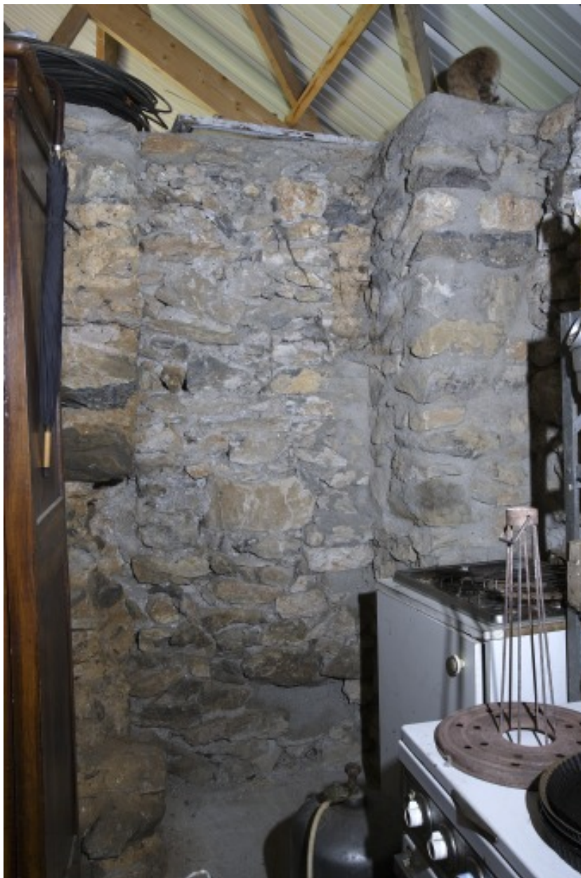
Bâtiment sud, pièce ouest : partie sud du mur est.
