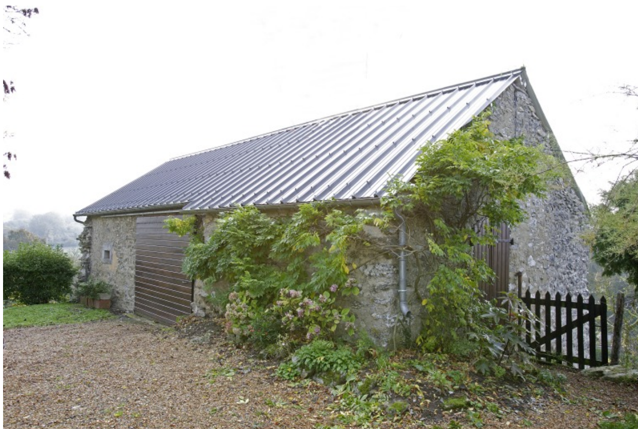
Le bâtiment sud vu depuis la cour au nord-ouest.
