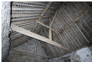
La première étable partie ouest : la charpente. Phot. François Lasa IVR52_20065302668NUCA
