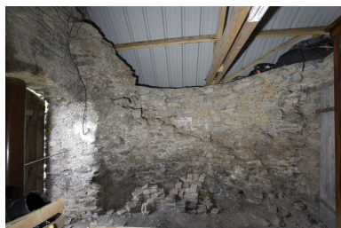
Bâtiment sud, pièce ouest : mur nord. Phot. François Lasa IVR52_20065302657NUCA
