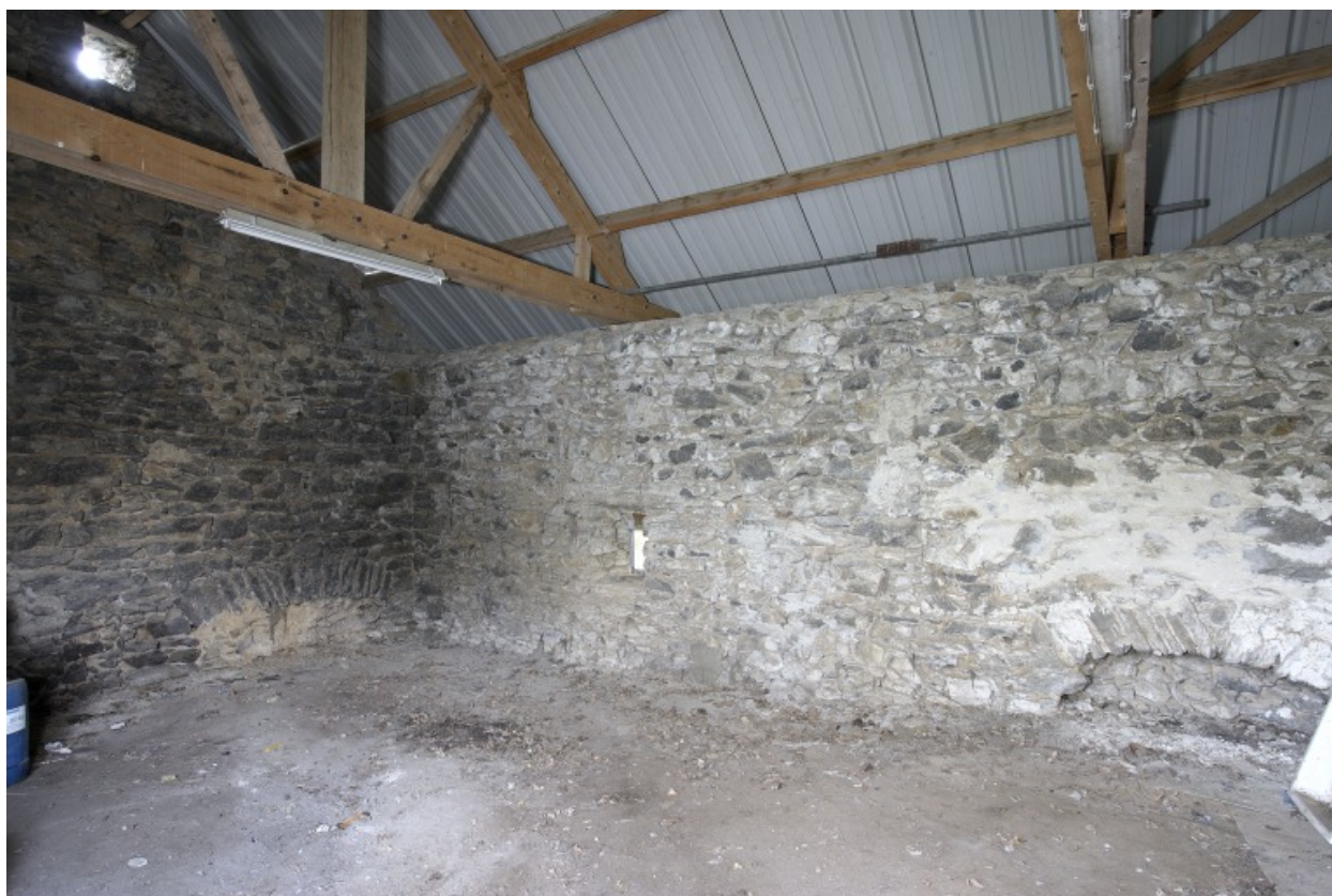
Bâtiment sud, pièce est : murs est et sud.
