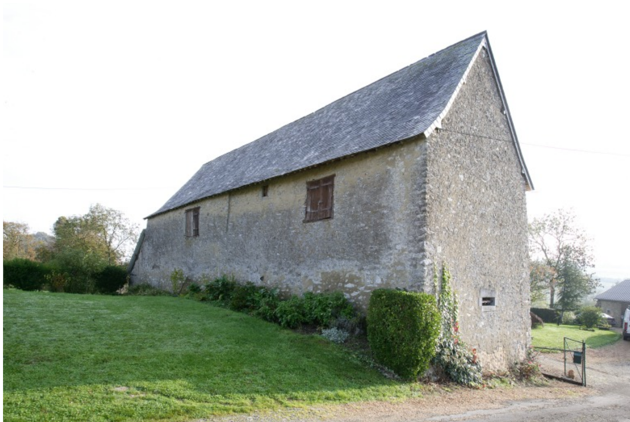
La première étable vue depuis l'ouest : façade nord et pignon ouest.
