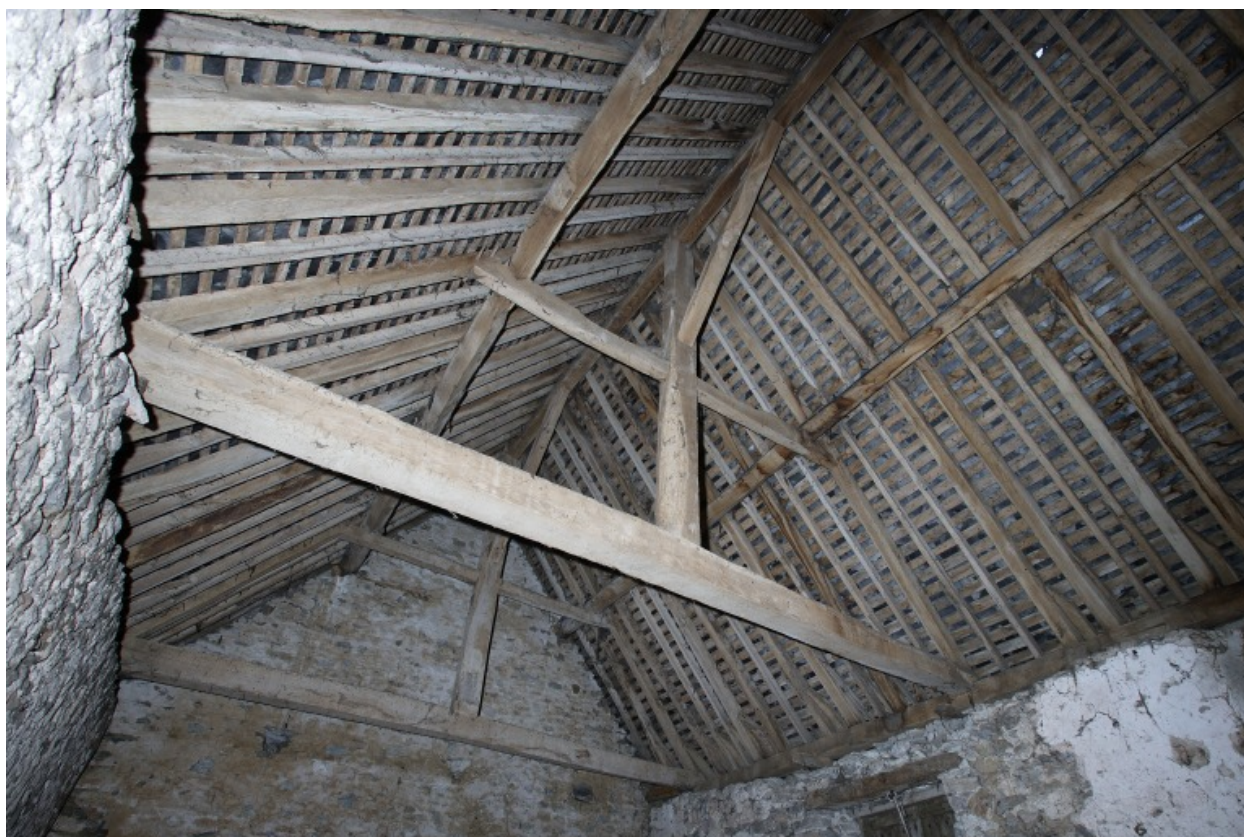
La première étable partie ouest : la charpente.
