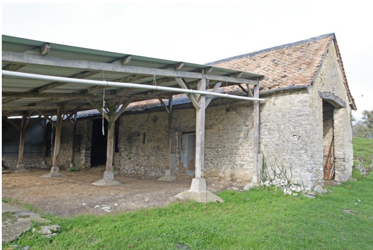
La remise vue depuis le sud-est.
