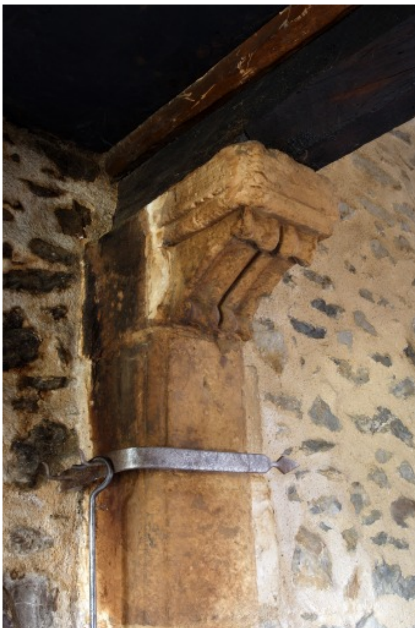
Détail de la cheminée du logis : le corbeau droit.
