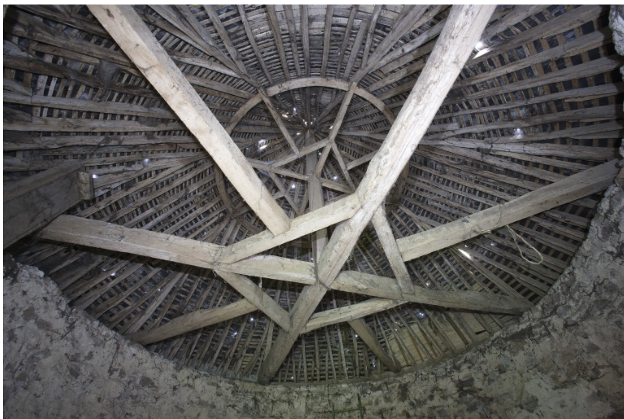
Le colombier : la charpente
