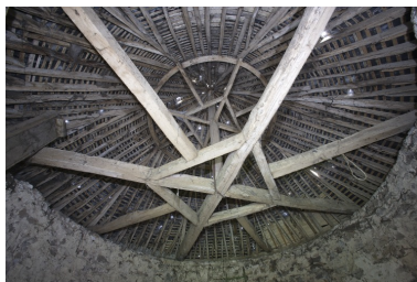
Le colombier : la charpente Phot. François Lasa IVR52_20065302784NUCA
