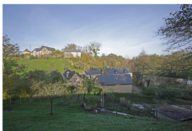
Vue d'ensemble du site depuis le sud : au premier plan le moulin, au deuxième le site seigneurial. Phot. François Lasa IVR52_20065302681NUCA
