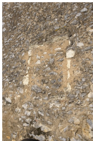
La première étable, partie ouest, façade sud : baie bouchée. Phot. François Lasa IVR52_20065302665NUCA
