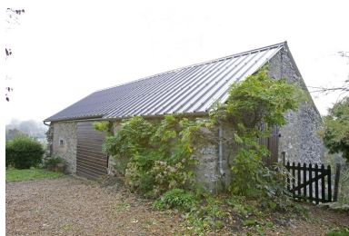
Le bâtiment sud vu depuis la cour au nord-ouest. Phot. François Lasa IVR52_20065302661NUCA
