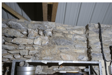
Bâtiment sud, pièce ouest : détail de la partie ouest du mur sud. Phot. François Lasa IVR52_20065302660NUCA
