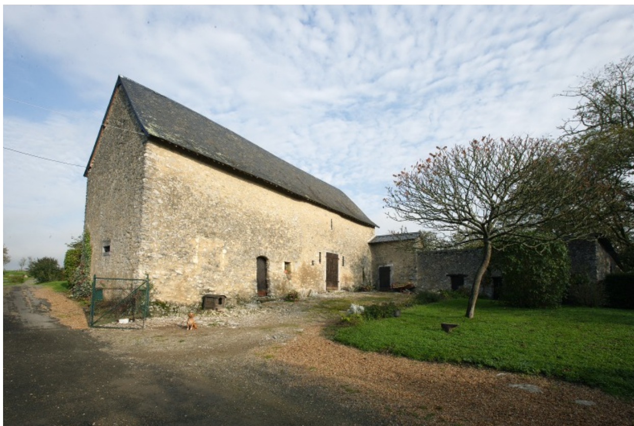
La première étable vue depuis le sud : pignon ouest et façade sud.
