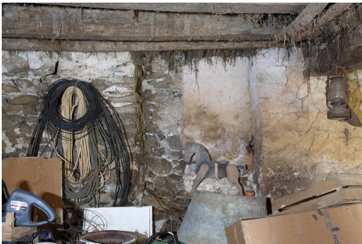
La première étable, pièce ouest : détail du mur nord.
