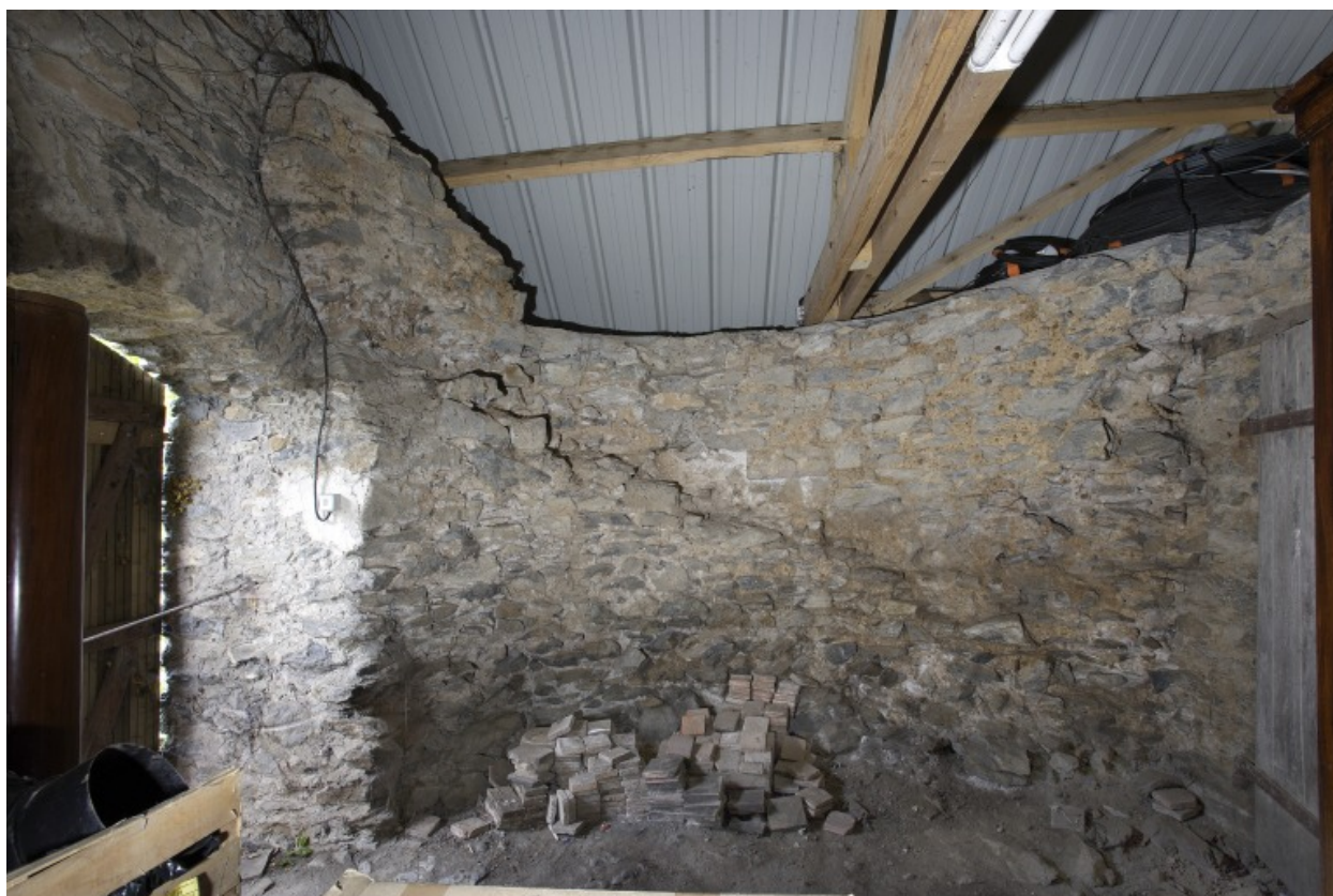
Bâtiment sud, pièce ouest : mur nord.
