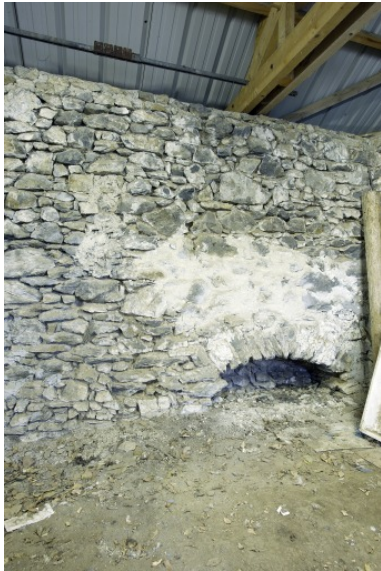
Bâtiment sud, pièce est, mur sud : arc. Phot. François Lasa IVR52_20065302721NUCA
