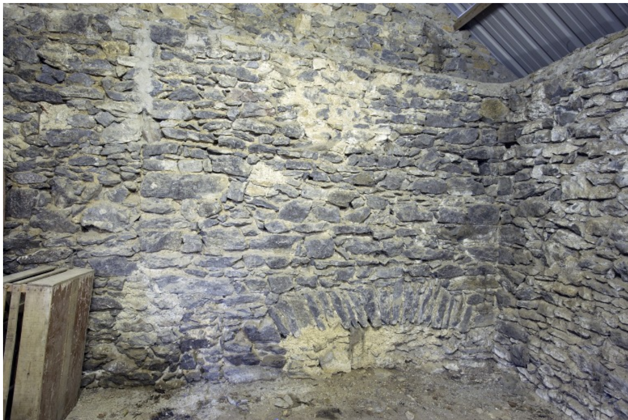
Bâtiment sud, pièce est, mur est : arc.
