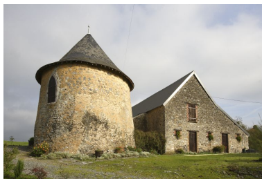
Le colombier et la deuxième étable vus depuis le sud-ouest. Phot. François Lasa IVR52_20065302781NUCA
