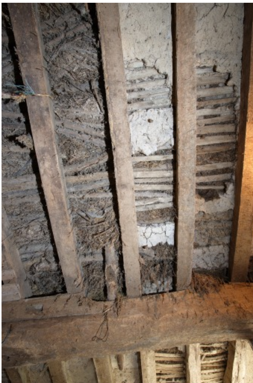
La première étable, pièce ouest : détail du plancher.
