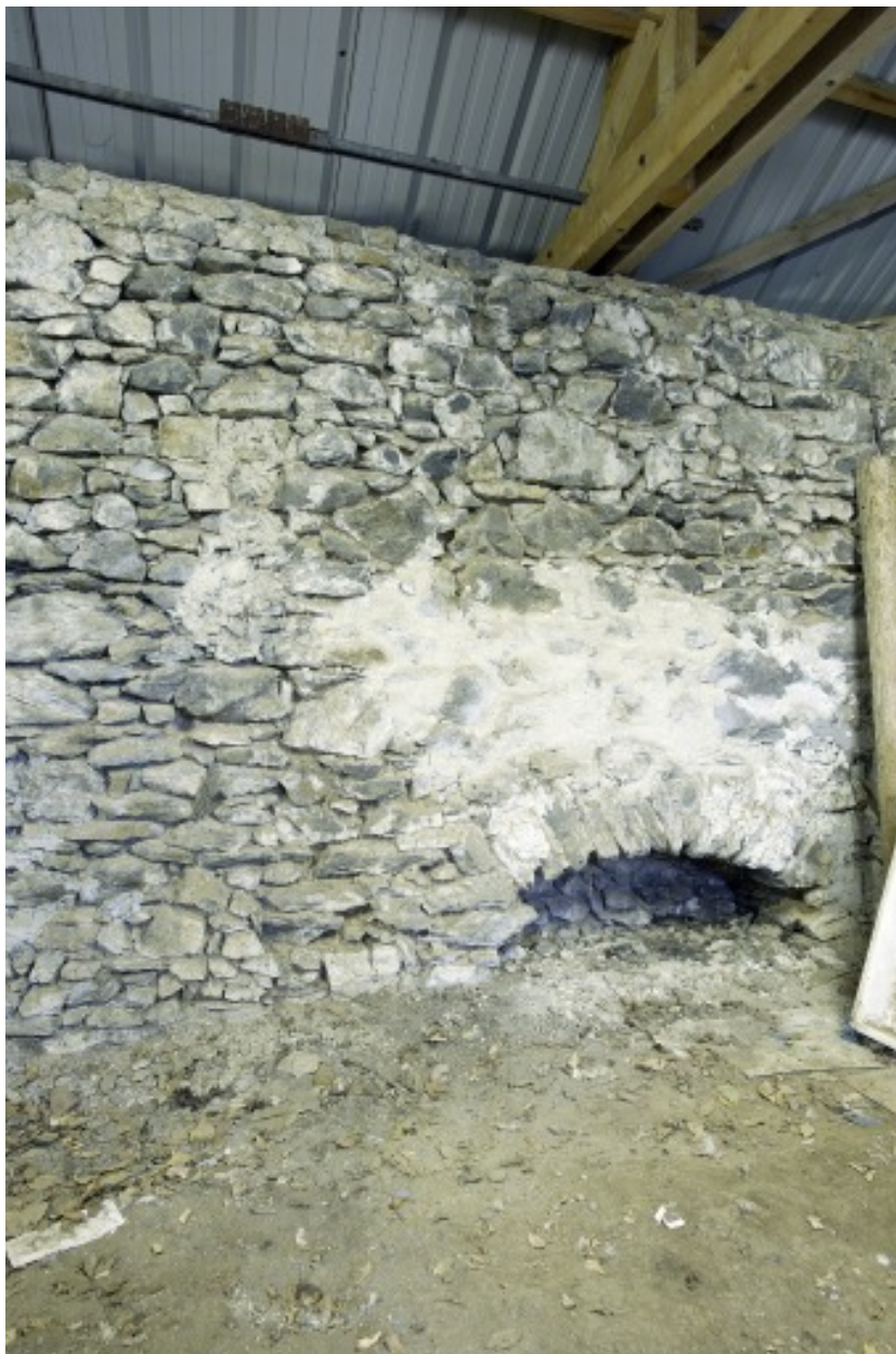
Bâtiment sud, pièce est, mur sud : arc.
