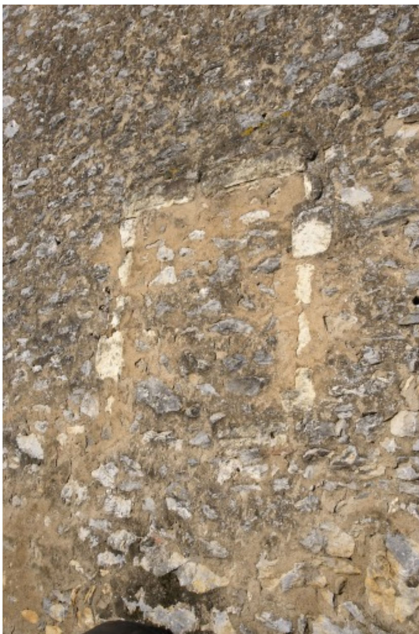
La première étable, partie ouest, façade sud : baie bouchée.
