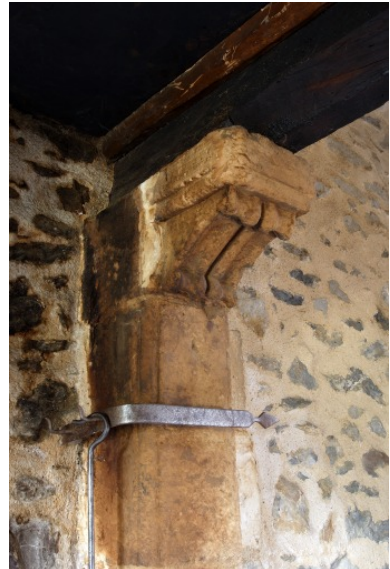
Détail de la cheminée du logis : le corbeau droit. Phot. François Lasa IVR52_20065302787NUCA
