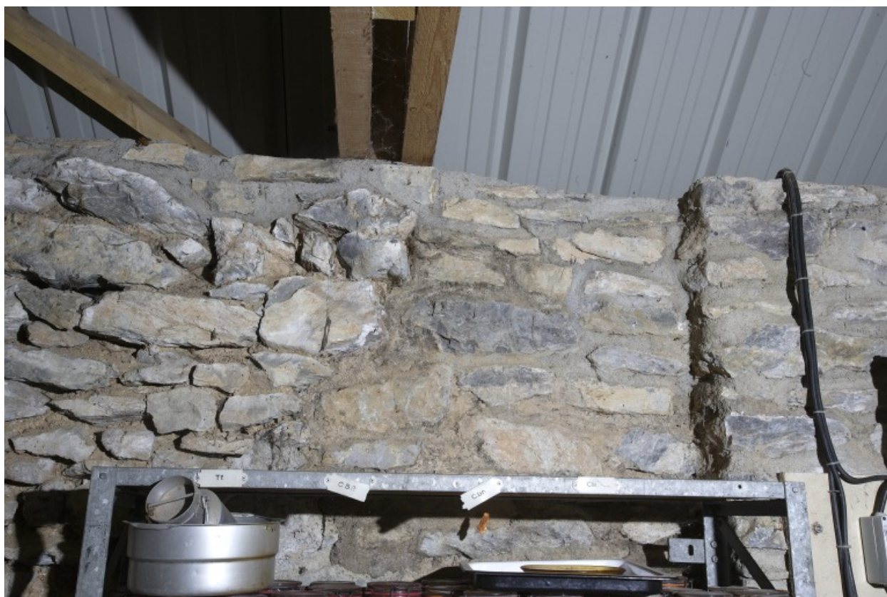
Bâtiment sud, pièce ouest : détail de la partie ouest du mur sud.
