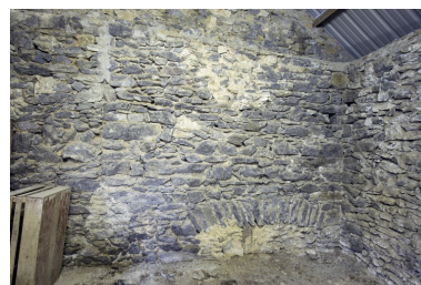
Bâtiment sud, pièce est, mur est : arc. Phot. François Lasa IVR52_20065302720NUCA
