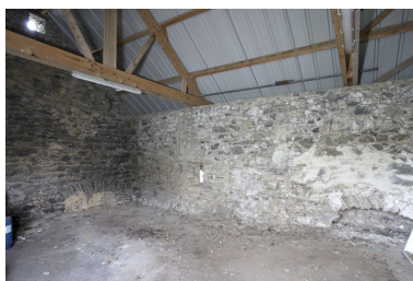
Bâtiment sud, pièce est : murs est et sud. Phot. François Lasa IVR52_20065302719NUCA
