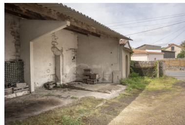
Zone de stockage dans la cour. Phot. Pierre-Bernard Fourny IVR52_20214400350NUCA
