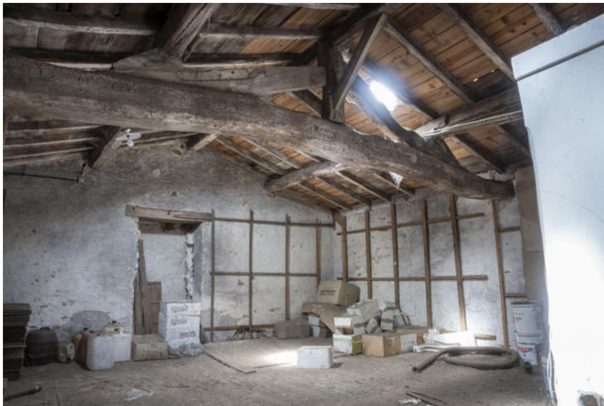
Espace désaffecté jouxtant la cuverie du premier étage, aile nord.
