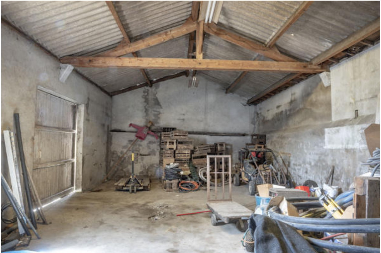
Aile nord du bâtiment, extrémité ouest.
