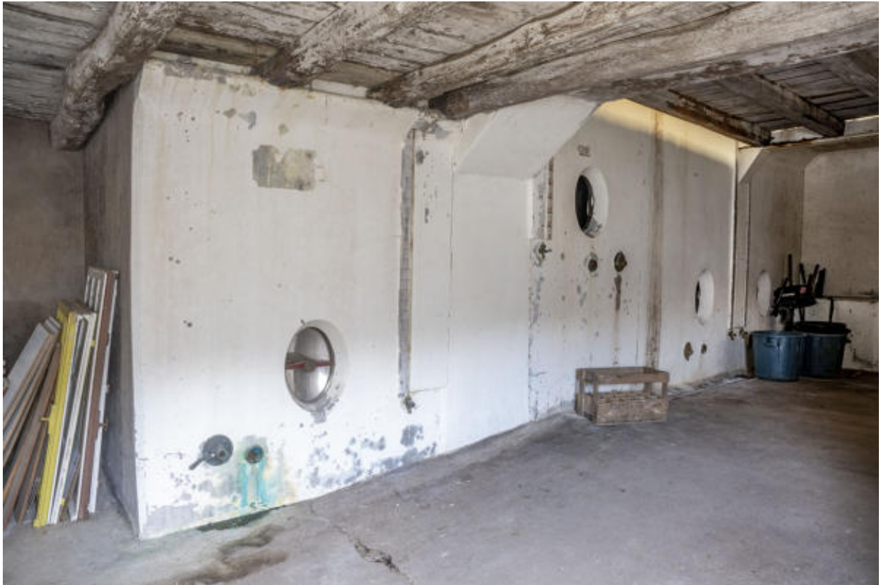
Cuverie en rez-de-chaussée de l'aile nord du bâtiment.
