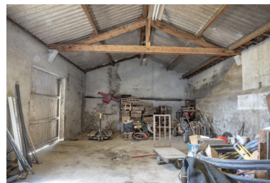
Aile nord du bâtiment, extrémité ouest. Phot. Pierre-Bernard Fourny IVR52_20214400275NUCA
