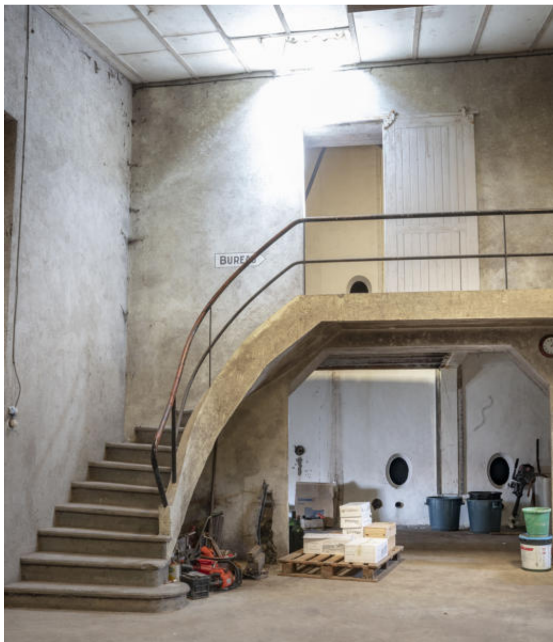
Escalier desservant les bureaux et l'étage de cuverie, depuis l'entrée principale.
