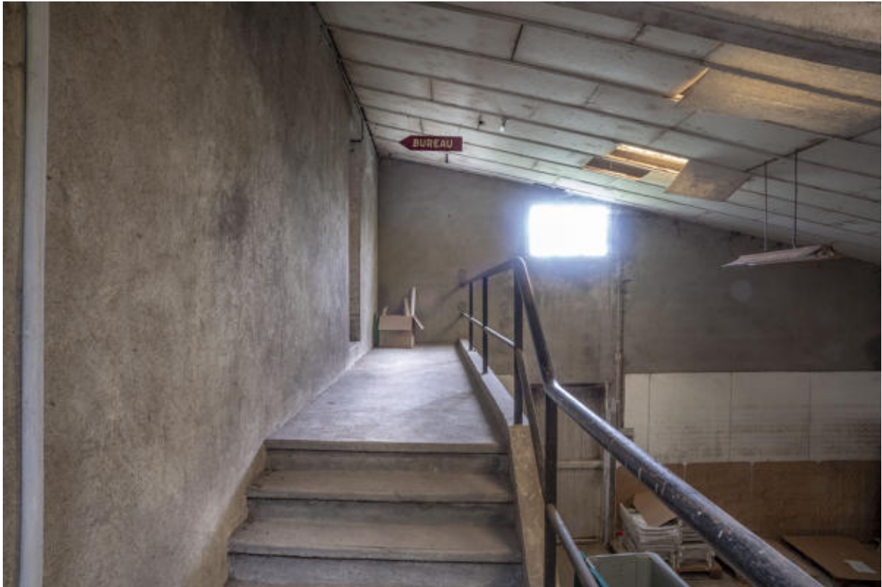
Escalier et coursière desservant la cuverie du premier étage et les espaces de bureau.
