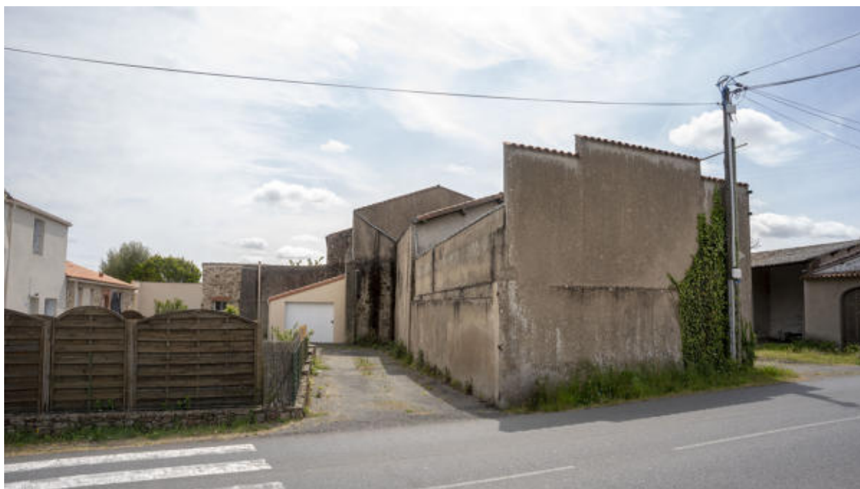
Vue générale de l'aile nord.
