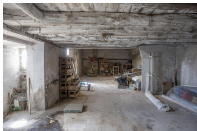
Aile nord du bâtiment. Phot. Pierre-Bernard Fourny IVR52_20214400273NUCA
