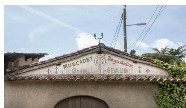
Fronton du caveau de dégustation. Phot. Pierre-Bernard Fourny IVR52_20214400341NUCA
