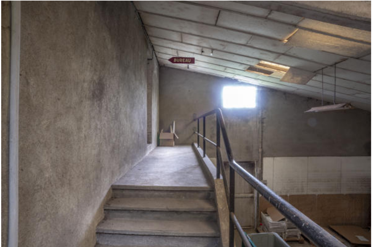
Escalier et coursière desservant la cuverie du premier étage et les espaces de bureau.
