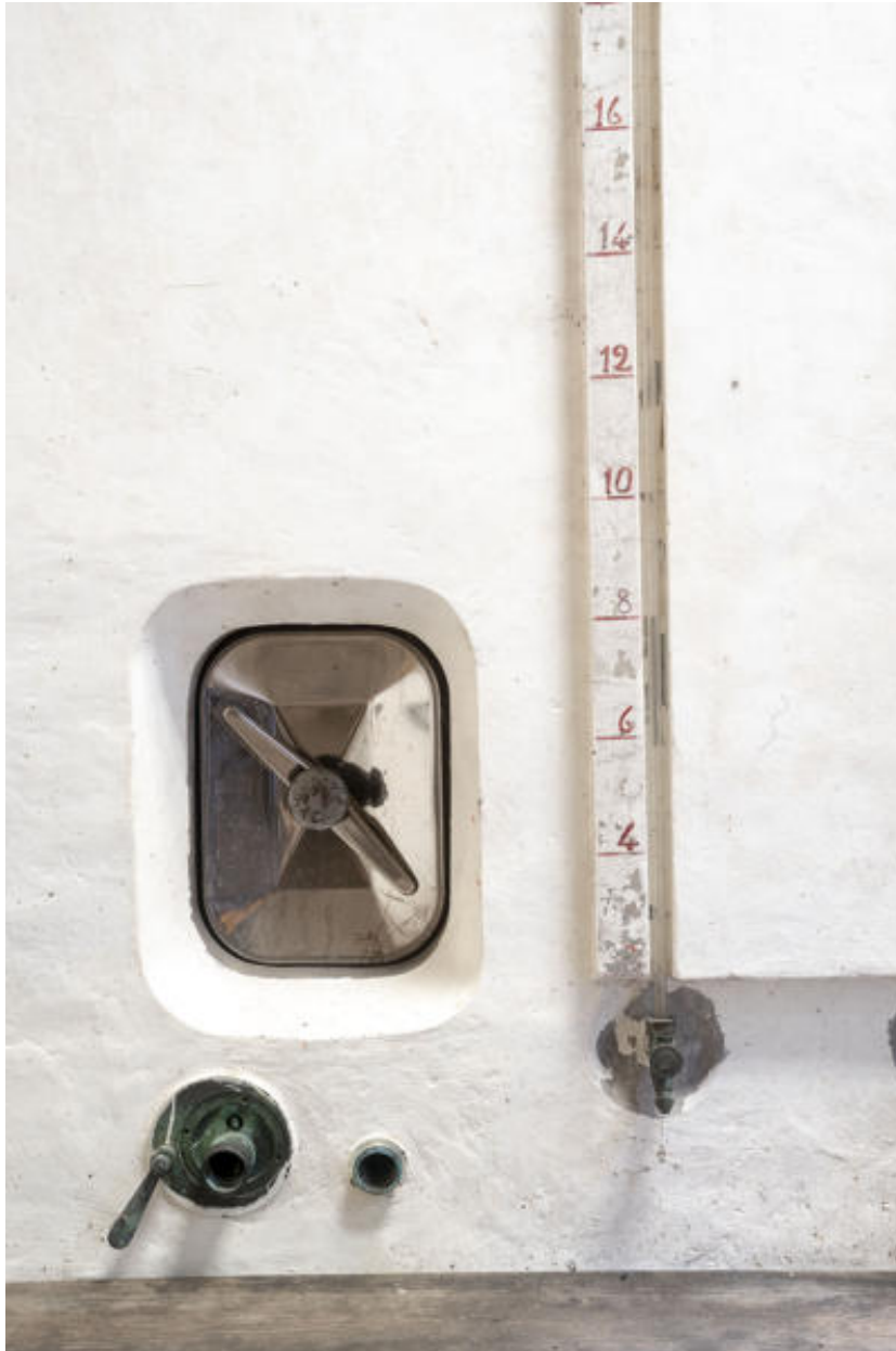
Détail de la cuverie, au premier étage.
