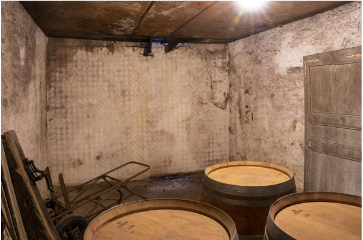
Détail d'une cellule de stockage des bouteilles.
