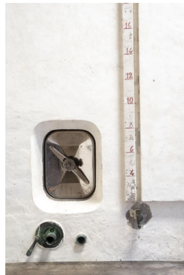
Détail de la cuverie, au premier étage. Phot. Pierre-Bernard Fourny IVR52_20214400284NUCA
