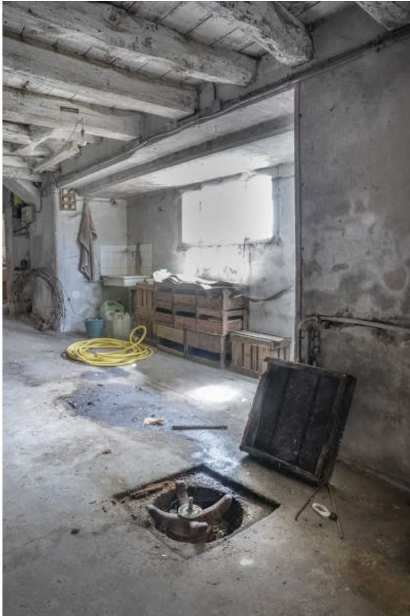
Zone de rinçage des fûts, dans l'aile nord du bâtiment.
