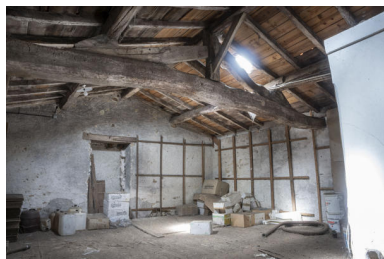
Espace désaffecté jouxtant la cuverie du premier étage, aile nord. Phot. Pierre-Bernard Fourny IVR52_20214400286NUCA
