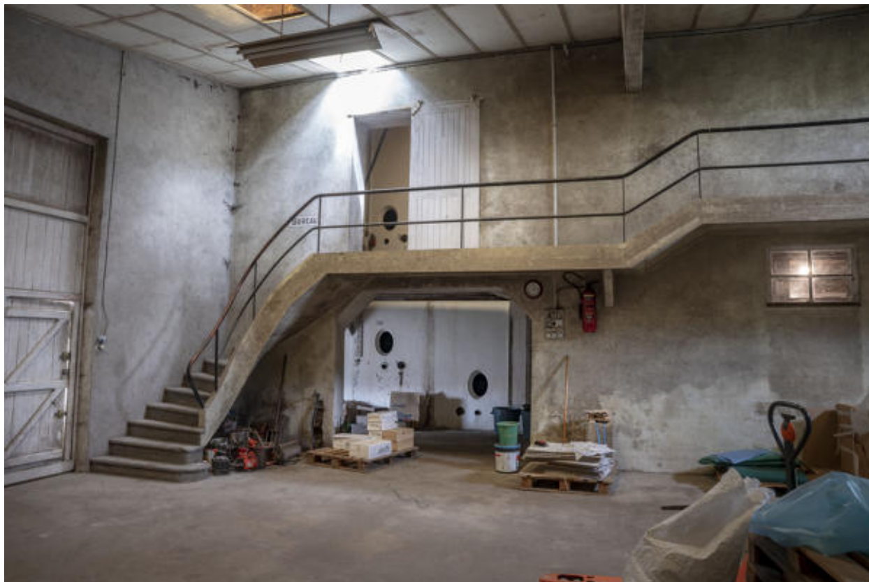
Escalier desservant les bureaux et l'étage de cuverie, depuis l'entrée du bâtiment central.
