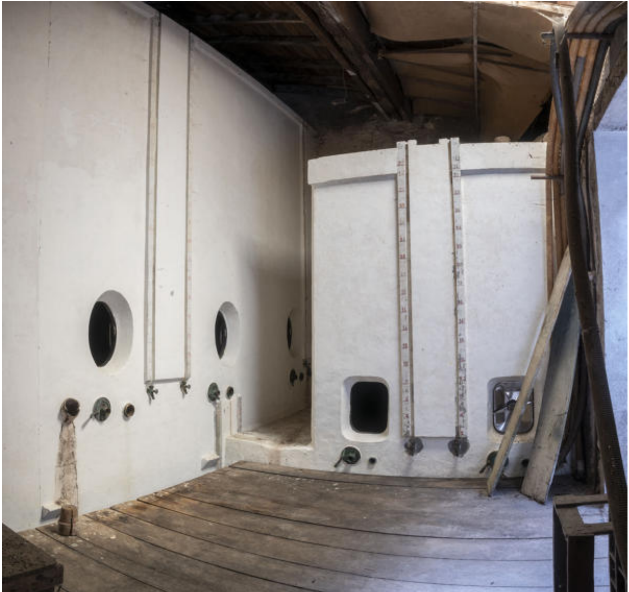
Vue générale de la cuverie, au premier étage de l'aile nord.
