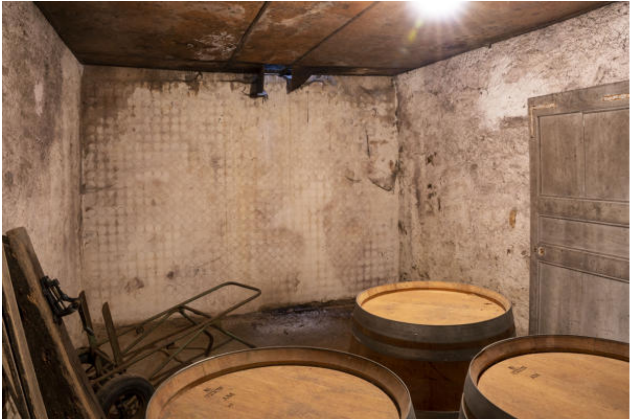
Détail d'une cellule de stockage des bouteilles.
