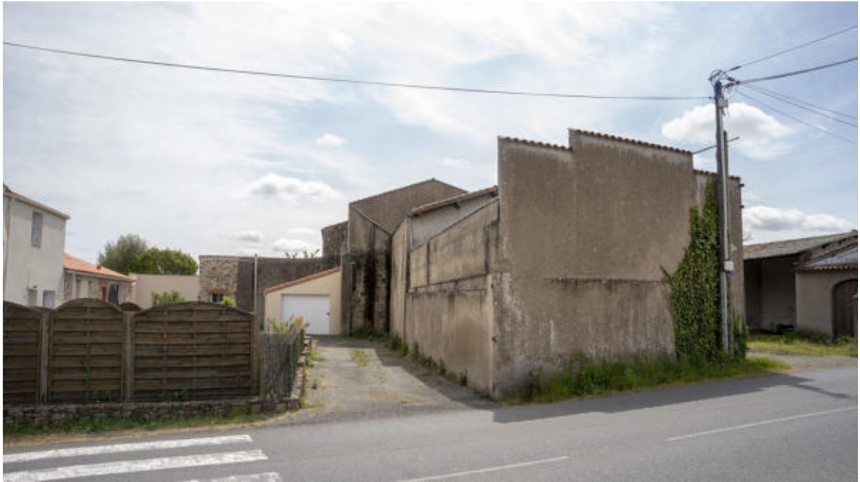
Vue générale de l'aile nord.
