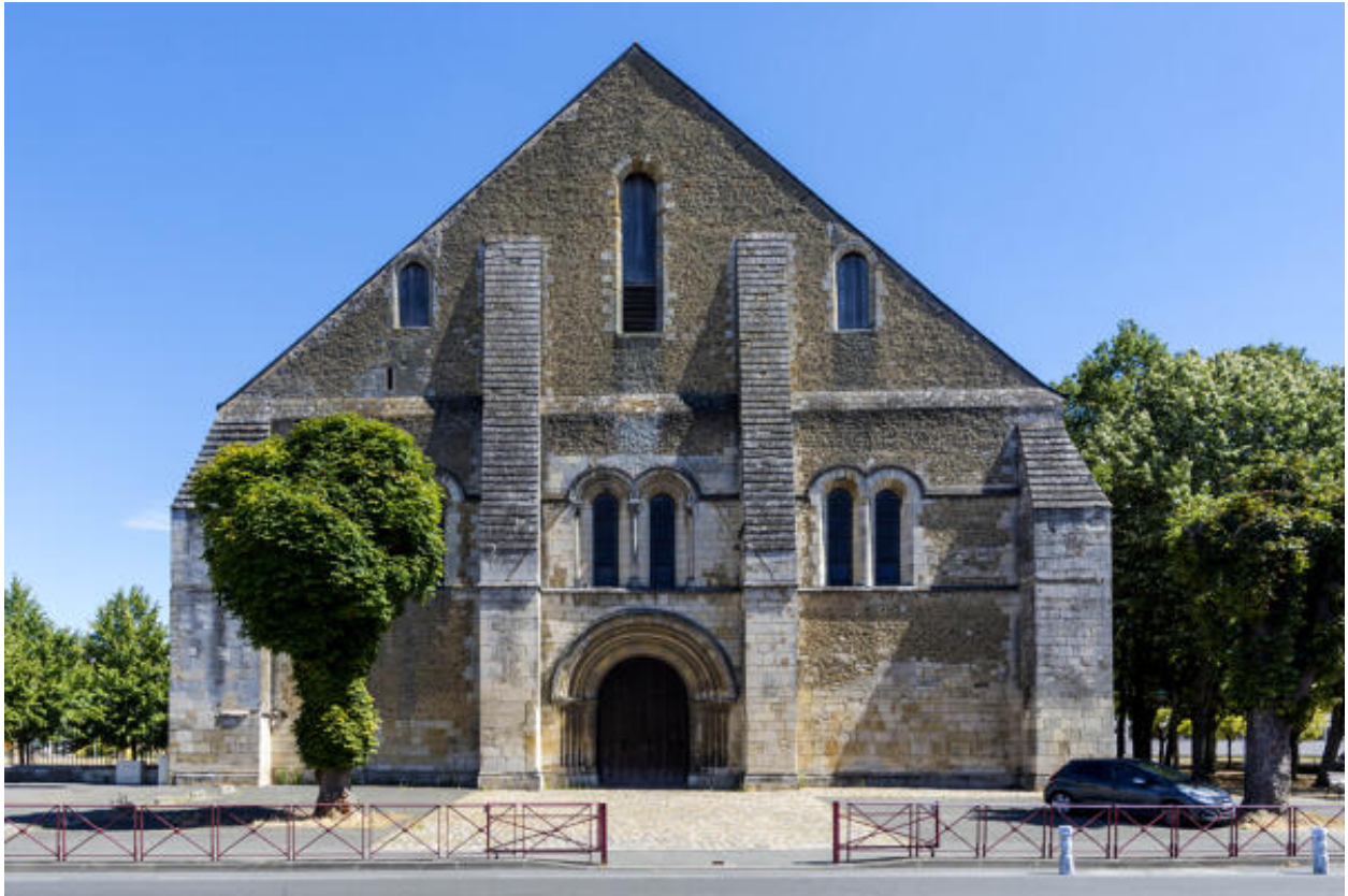
Vue de la salle des malades de l'Hôtel-Dieu de Coëffort.
