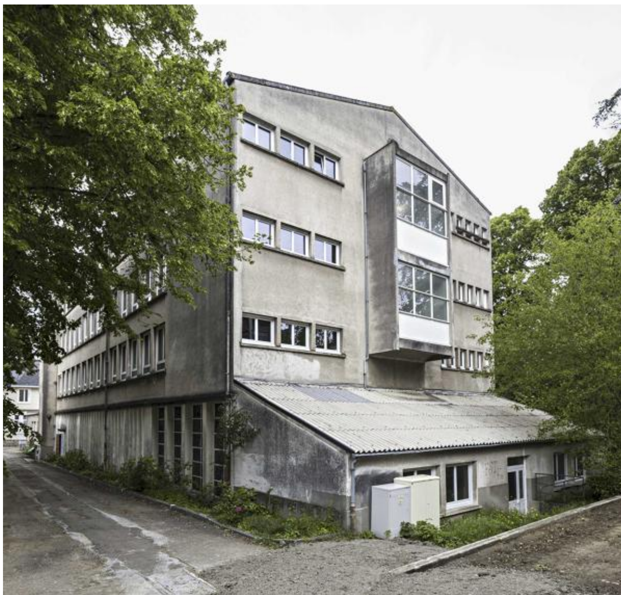
Vue du bâtiment arrière du lycée Sainte-Croix.
