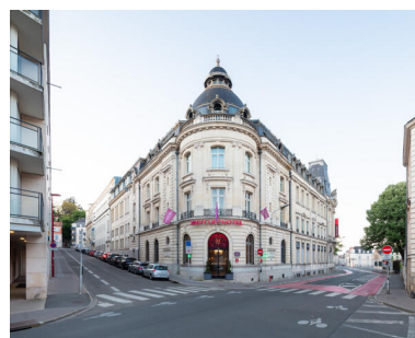
Vue du bâtiment des mutuelles rue Chanzy. Phot. Paul Hamelin IVR52_20227200226NUCA
