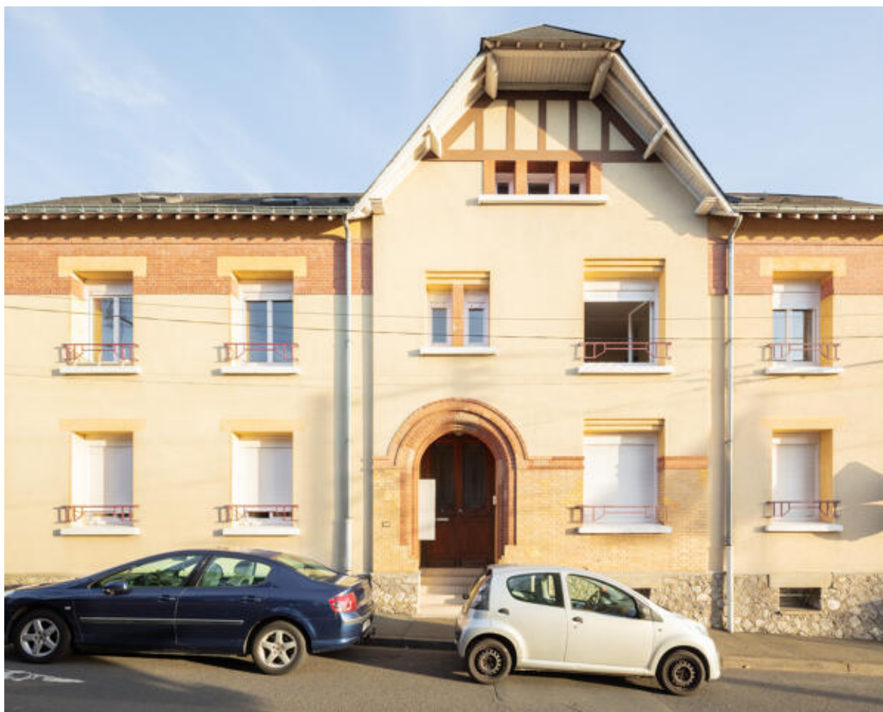
Vue de la façade principale du logement des instituteurs de l'école Yzeuille.
