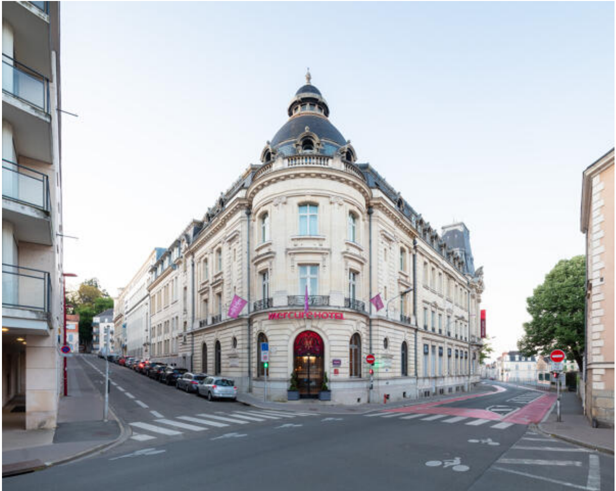
Vue du bâtiment des mutuelles rue Chanzy.
