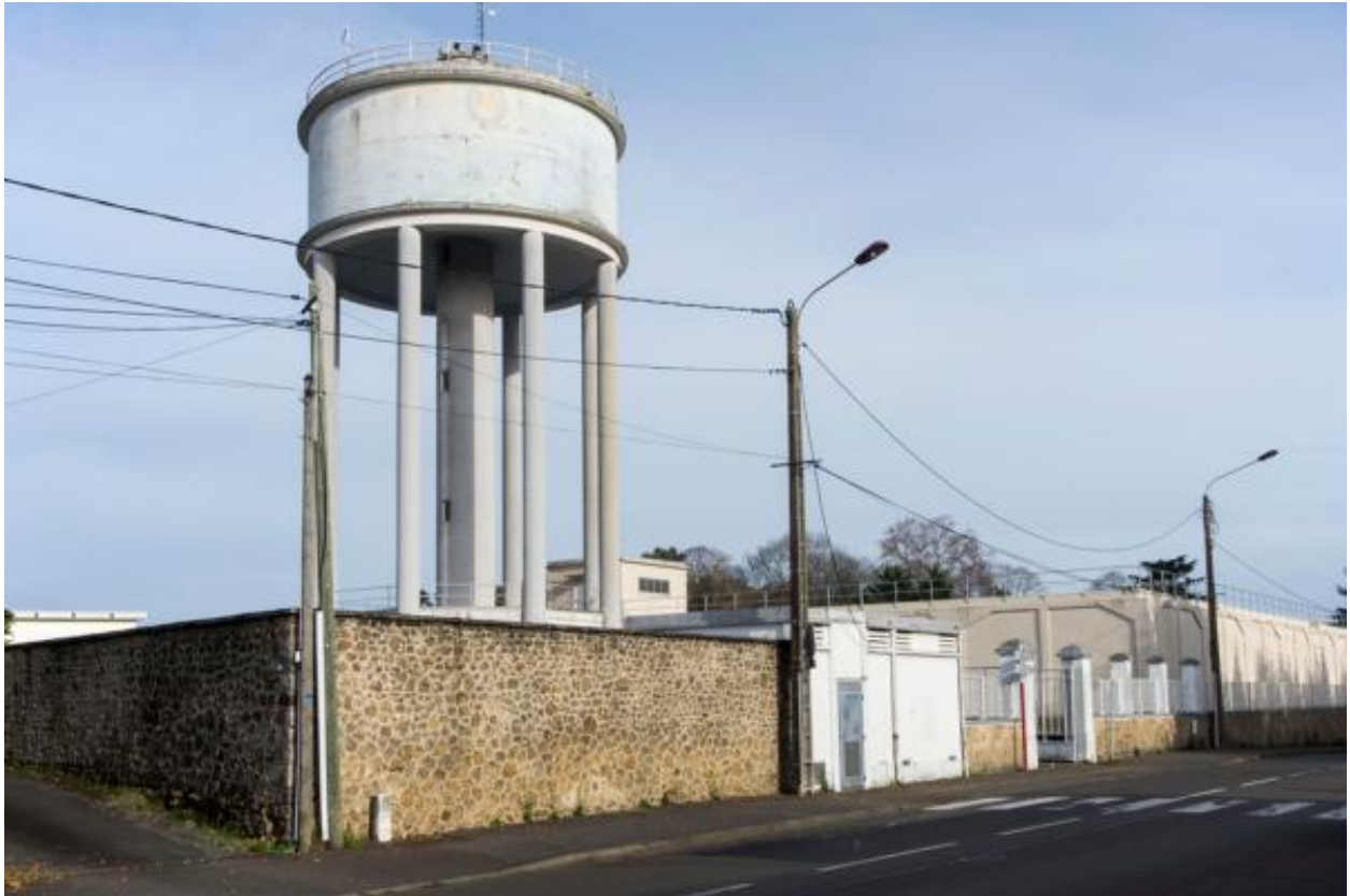
Vue du réservoir d'eau dit de Gazonfier.
