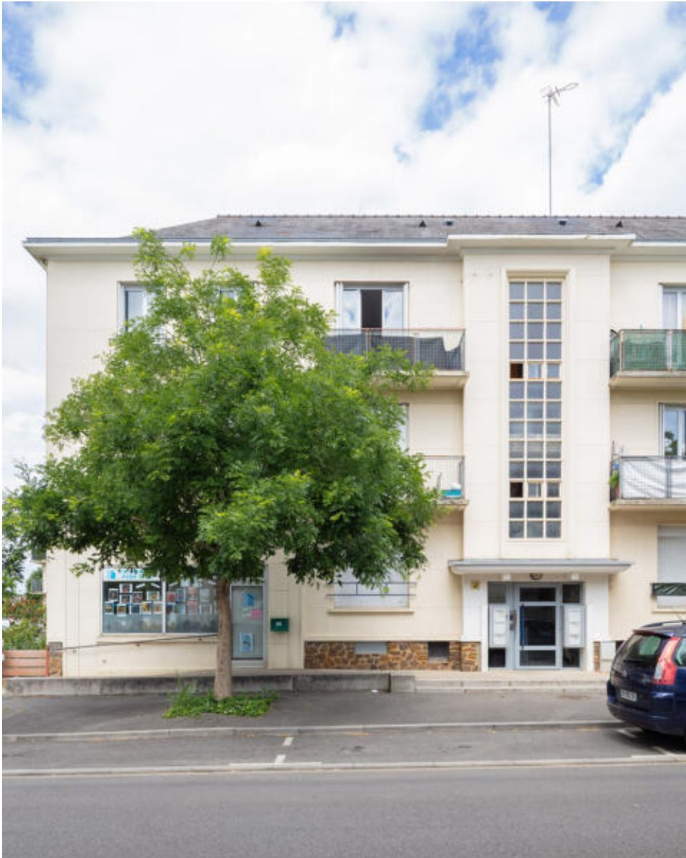
Vue de la façade principale du bâtiment G rue Raymond-Persignan.
