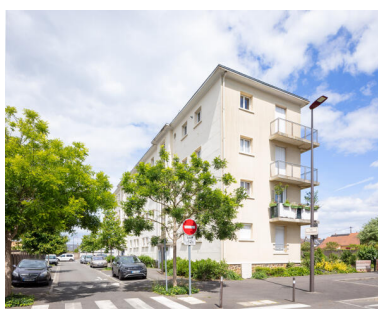
Vue du bâtiment D rue Régine-Deforges. Phot. Paul Hamelin IVR52_20227200593NUCA
