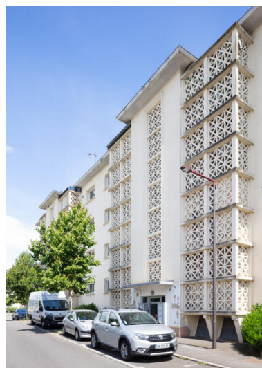
Vue de la travée centrale du bâtiment D rue Régine-Deforges. Phot. Paul Hamelin IVR52_20227200589NUCA
