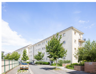
Vue des immeubles B et C depuis la rue Régine-Deforges. Phot. Paul Hamelin IVR52_20227200590NUCA
