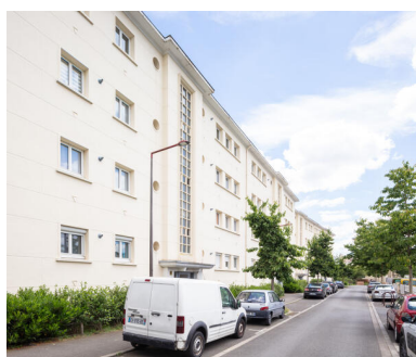
Vue du bâtiment C rue Régine-Deforges. Phot. Paul Hamelin IVR52_20227200592NUCA
