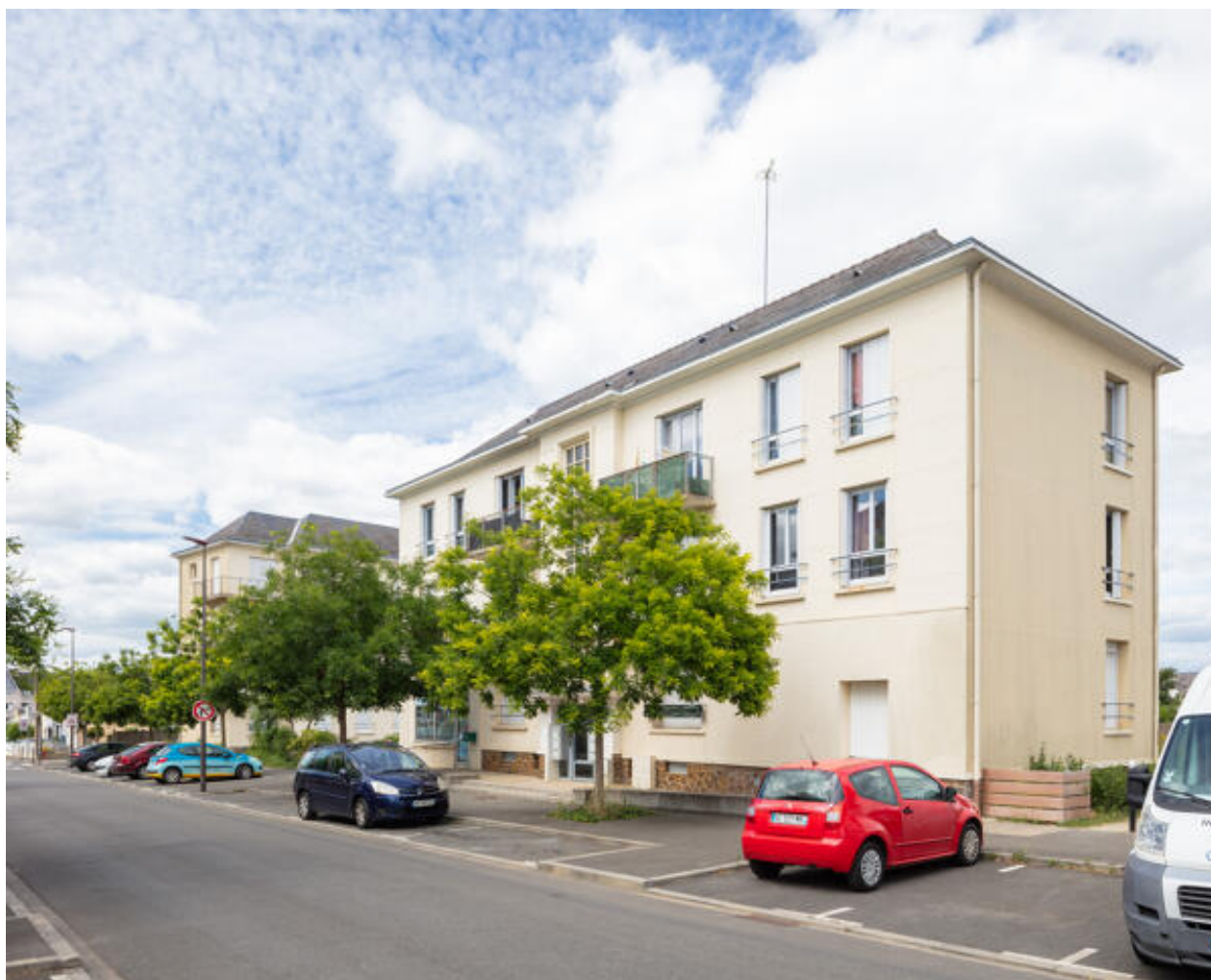
Vue de la façade principale du bâtiment G rue Raymond-Persignan.
