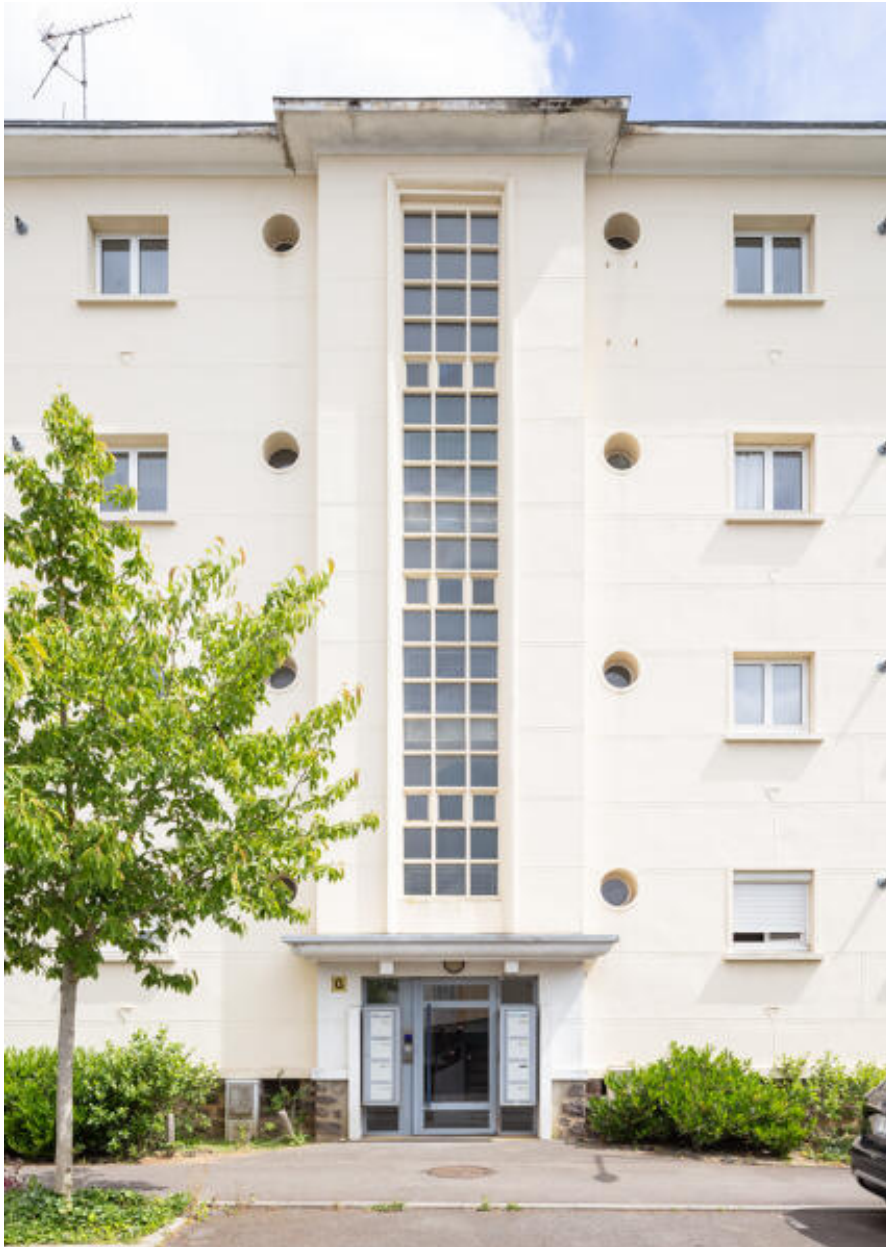
Vue de la travée centrale d'escalier du bâtiment C rue Régine-Deforges.
