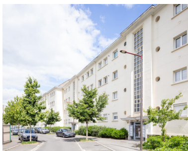
Vue de la façade principale des immeubles B et C rue Régine-Deforges. Phot. Paul Hamelin IVR52_20227200591NUCA
