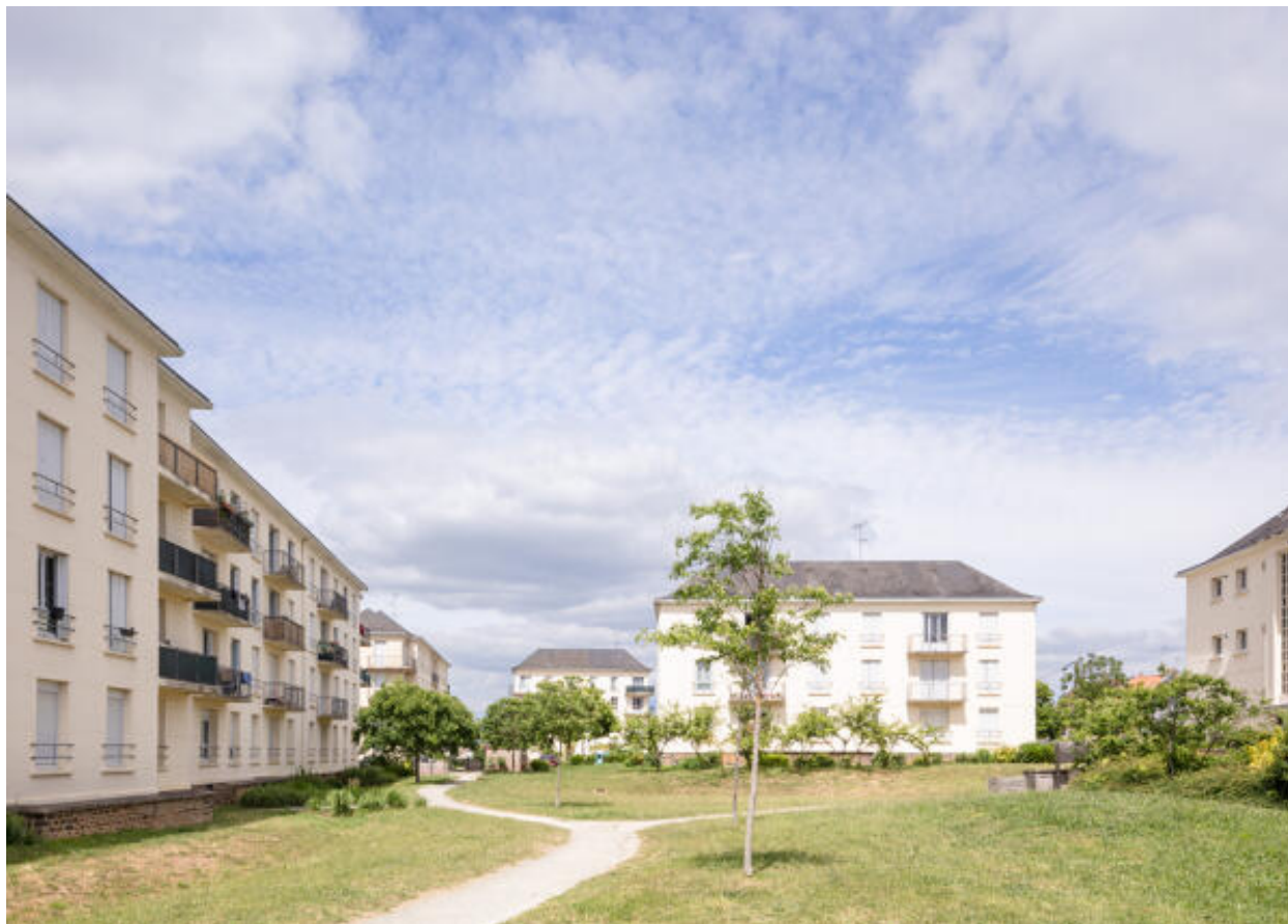
Vue de l'espace vert central vers l'est.
