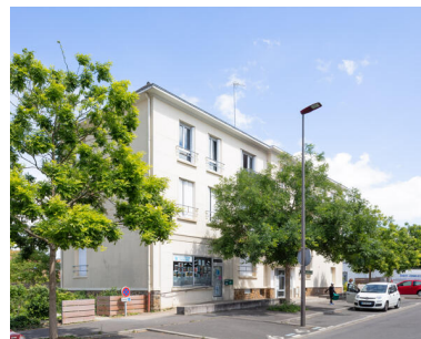
Vue de l'immeuble F rue Raymond-Persignan. Phot. Paul Hamelin IVR52_20227200588NUCA
