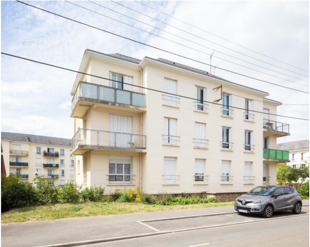
Vue de la façade principale du bâtiment H rue des Bigarreux.
