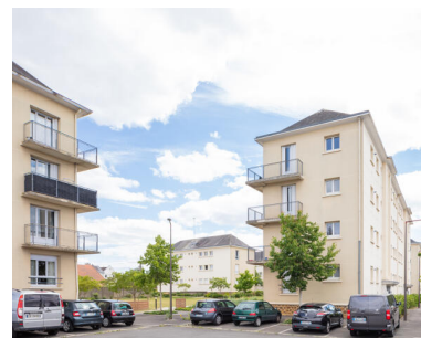
Vue de l'espace vert intérieur de la cité côté est. Phot. Paul Hamelin IVR52_20227200598NUCA
