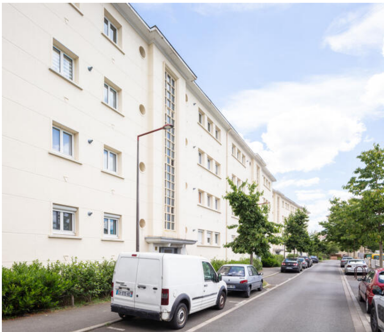
Vue du bâtiment C rue Régine-Deforges.
