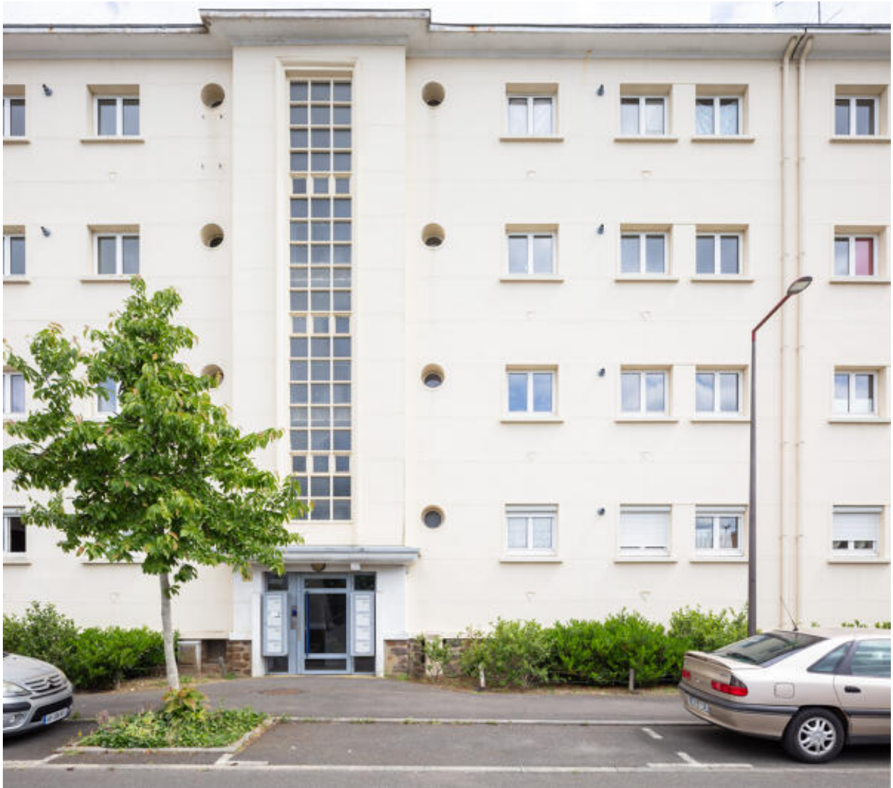
Détail de la façade principale du bâtiment C.
