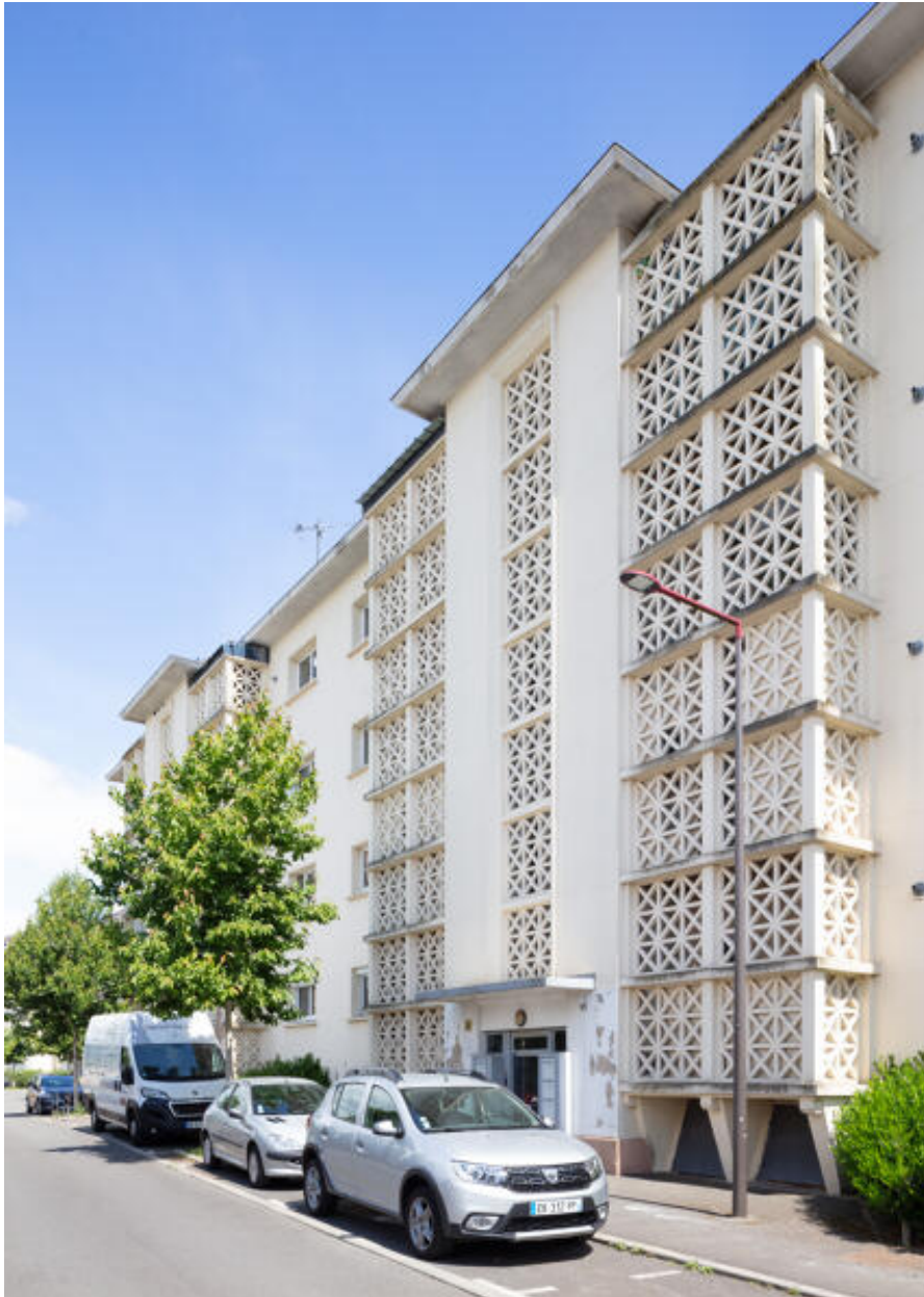
Vue de la travée centrale du bâtiment D rue Régine-Deforges.
