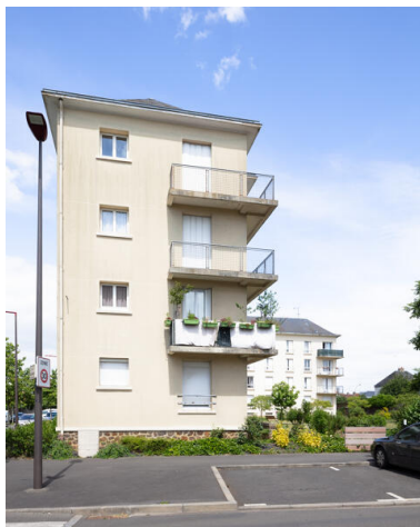
Vue des immeubles de la cité depuis la rue Raymond-Persignan. Phot. Paul Hamelin IVR52_20227200587NUCA
