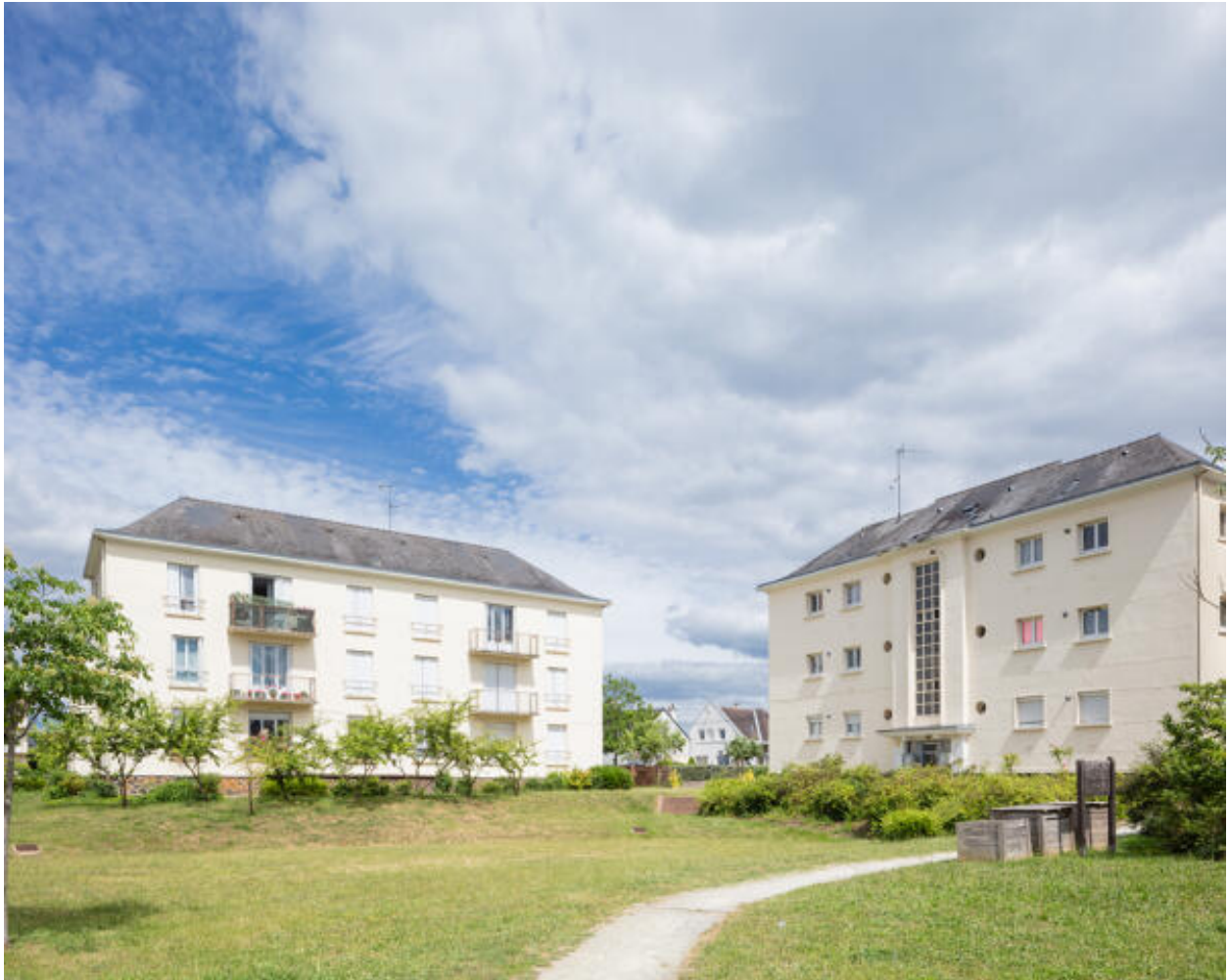
Vue de l'espace vert central vers le sud-est.
