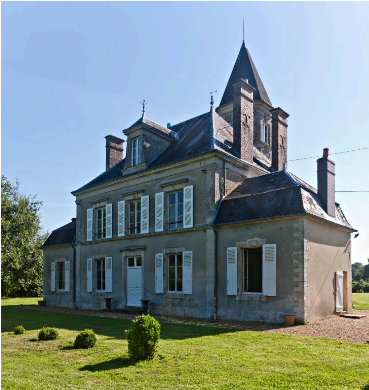
Le logis vu depuis le sud-ouest.
