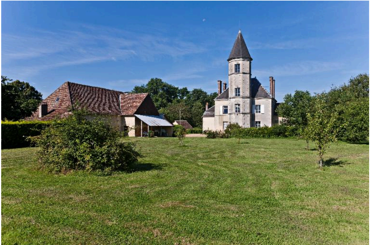
Vue d'ensemble depuis l'est. A gauche, le logis de la ferme.
