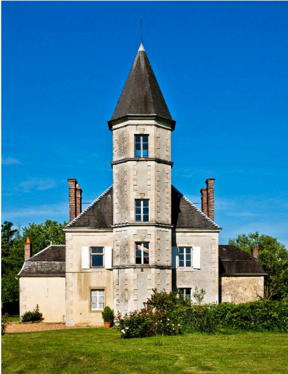
Elévation postérieure du logis.
