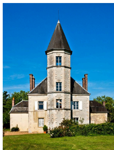
Élévation postérieure du logis.
