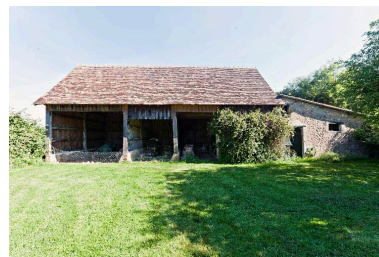
Elévation sur cour des communs. Phot. Yves Guillotin IVR52_20147201657NUCA
