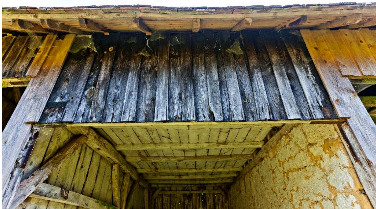
Détail de l'essentage de planche de l'élévation sur cour des communs.
