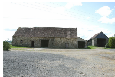
L'étable-grange et la remise. Phot. François Lasa IVR52_20035301764NUCA
