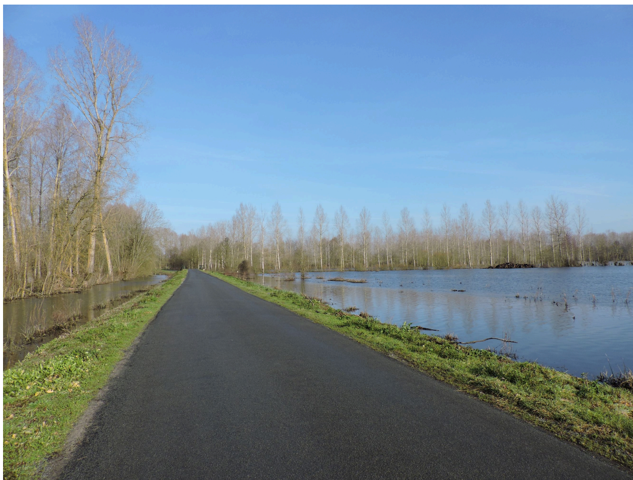
La route du Mazeau à la Sèvre longeant le marais communal, à droite, en direction du nord.
