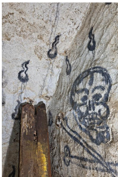
Angle sud-ouest. Marques des coups de truelles sur l'enduit et recouvrements des passes d'enduit dans l'angle. Phot. Yves Guillotin IVR52_20165300361NUCA
