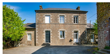
Mairie et école des garçons de Niort, façade sud. Phot. Pierre-Bernard Fourny IVR52_20225300657NUCA
