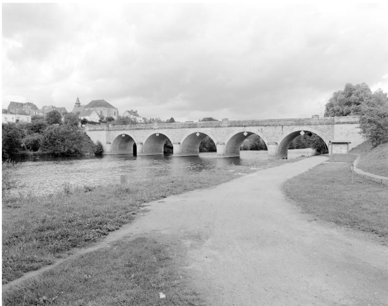
Vue depuis la rive gauche en aval.
