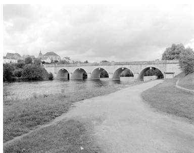
Vue depuis la rive gauche en aval. Phot. François Lasa IVR52_20025300995X
