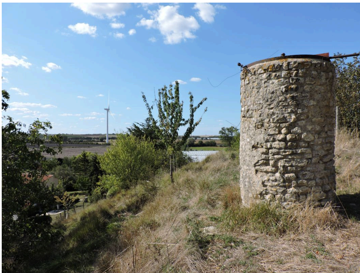
La tourelle au sommet du coteau, vue depuis le sud-est.
