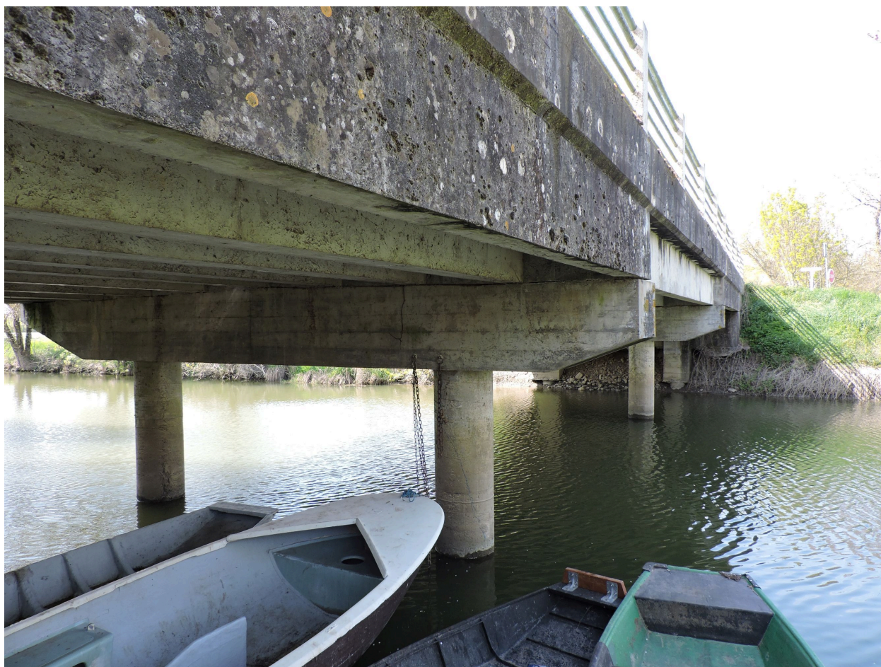
Détail du pont et de ses piles.
