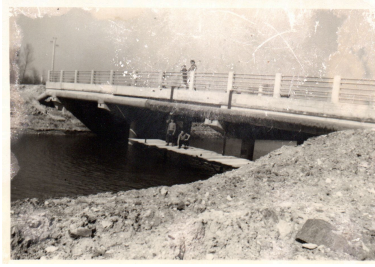
Le pont tout juste construit, en 1961. Phot. Yannis (reproduction) Suire IVR52_20218501453NUCA
