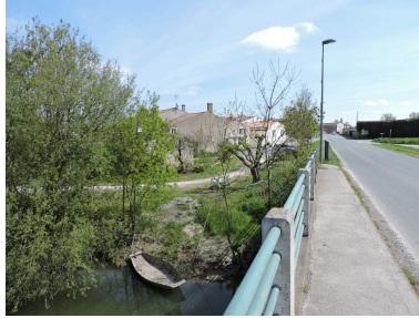
Le pont et, à gauche, l'emplacement de l'ancien port. Phot. Yannis Suire IVR52_20218501186NUCA
