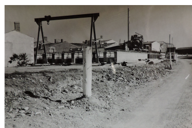
La construction du pont en 1961, vue depuis le nord-ouest. Phot. Yannis (reproduction) Suire IVR52_20218501357NUCA
