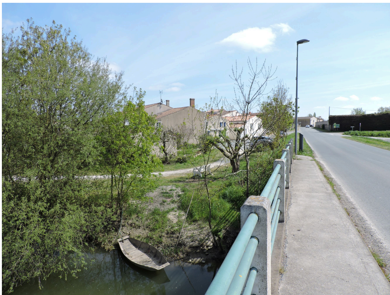
Le pont et, à gauche, l'emplacement de l'ancien port.
