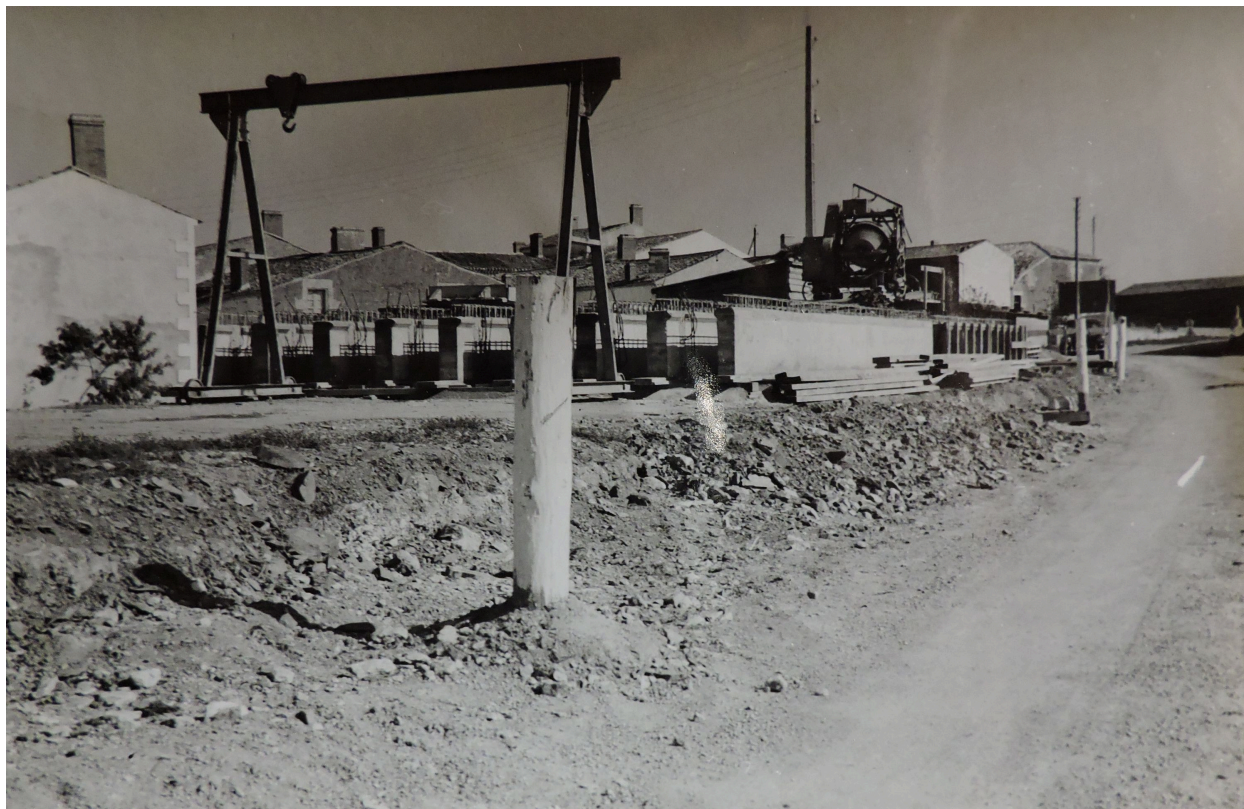
La construction du pont en 1961, vue depuis le nord-ouest.
