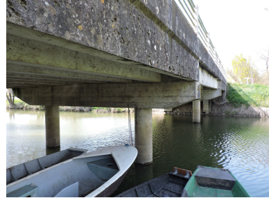
Détail du pont et de ses piles. Phot. Yannis Suire IVR52_20218501185NUCA
