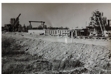
Construction du pont en 1961, depuis le sud. Phot. Yannis (reproduction) Suire IVR52_20218501356NUCA
