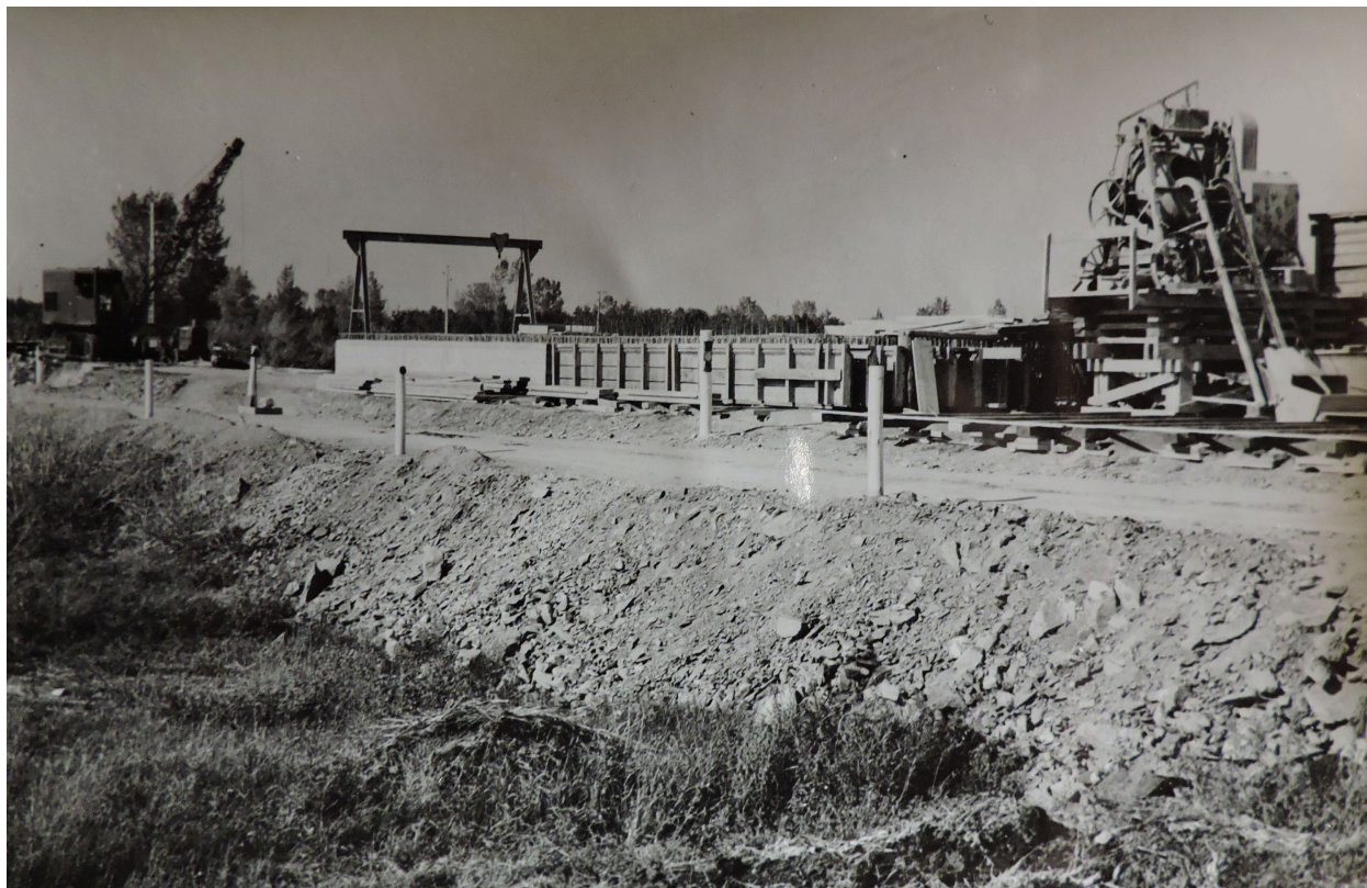
Construction du pont en 1961, depuis le sud.
