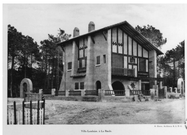
Angle sud-ouest de la villa landaise Abjamico. Phot. Denis (reproduction) Pillet IVR52_19984400583X
