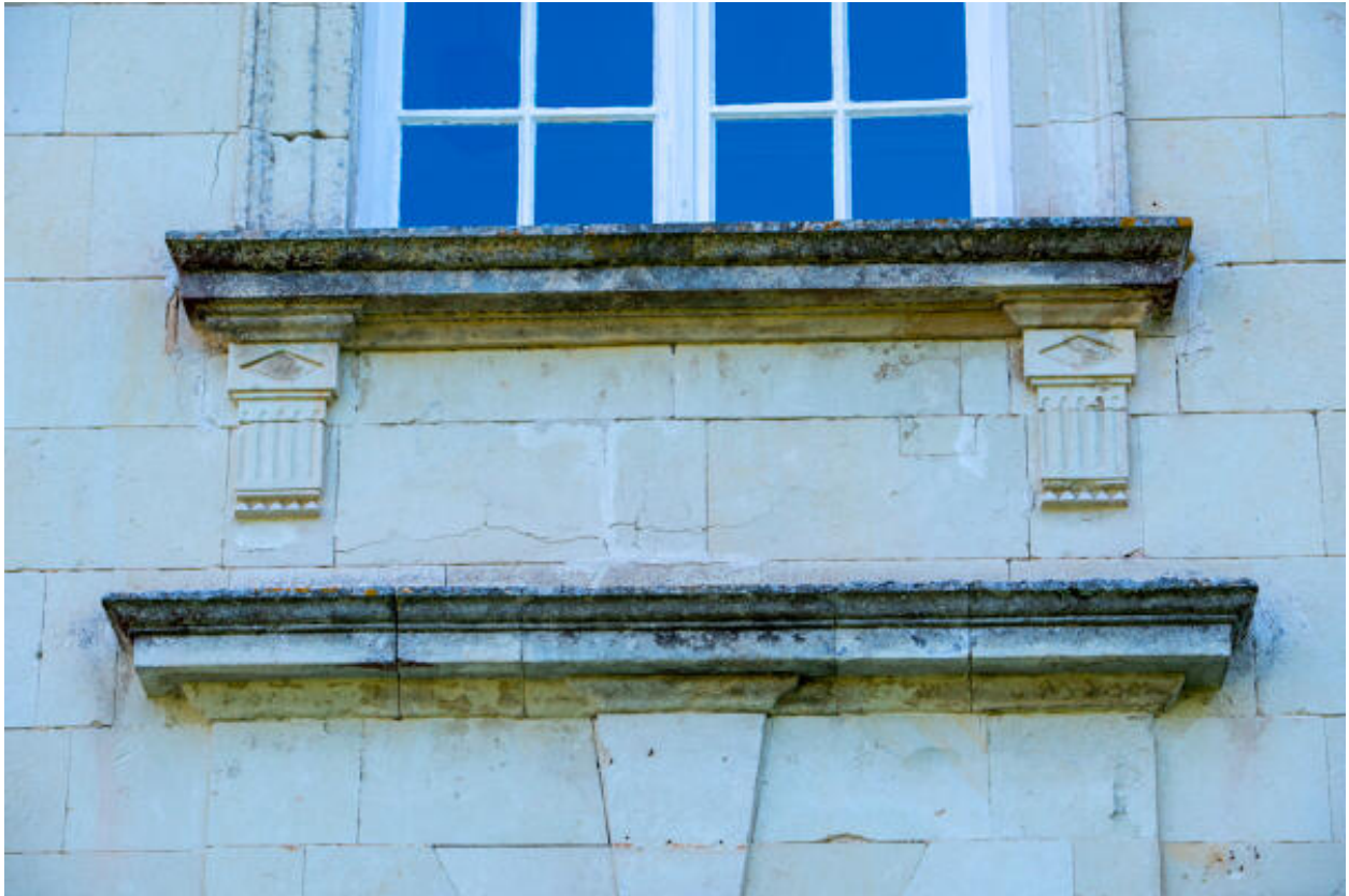
Un détail d'un larmier et d'un appui de fenêtre.
