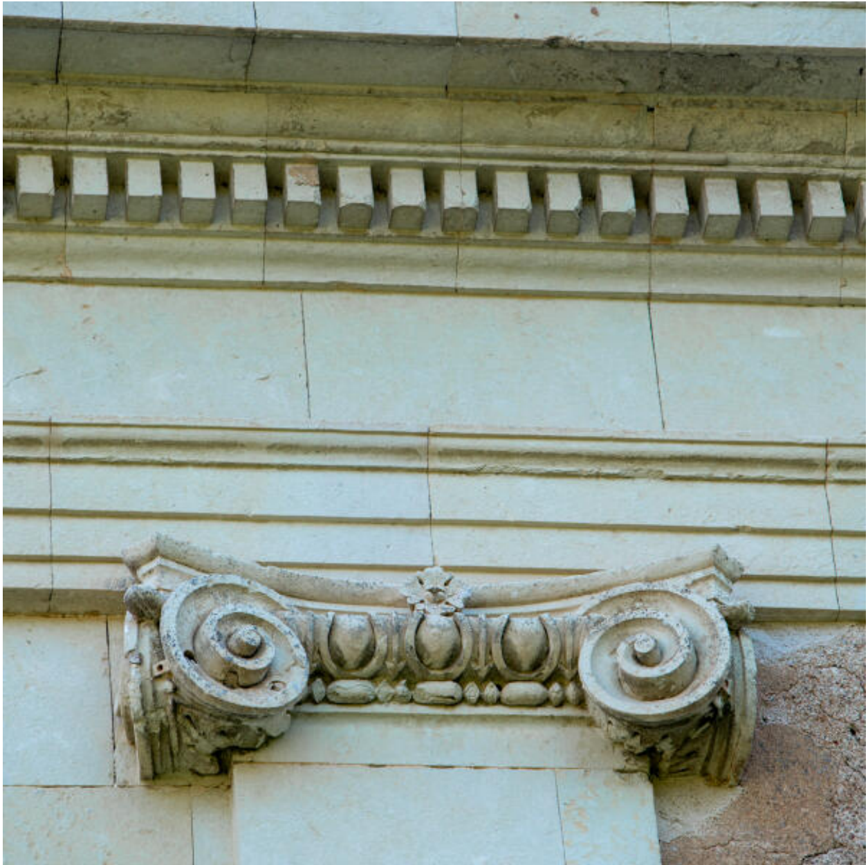
Un détail d'un pilastre et de la corniche.
