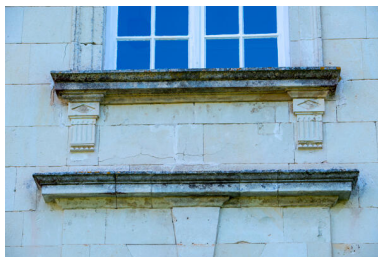
Un détail d'un larmier et d'un appui de fenêtre. Phot. Pierre-Bernard Fourny IVR52_20235300306NUCA
