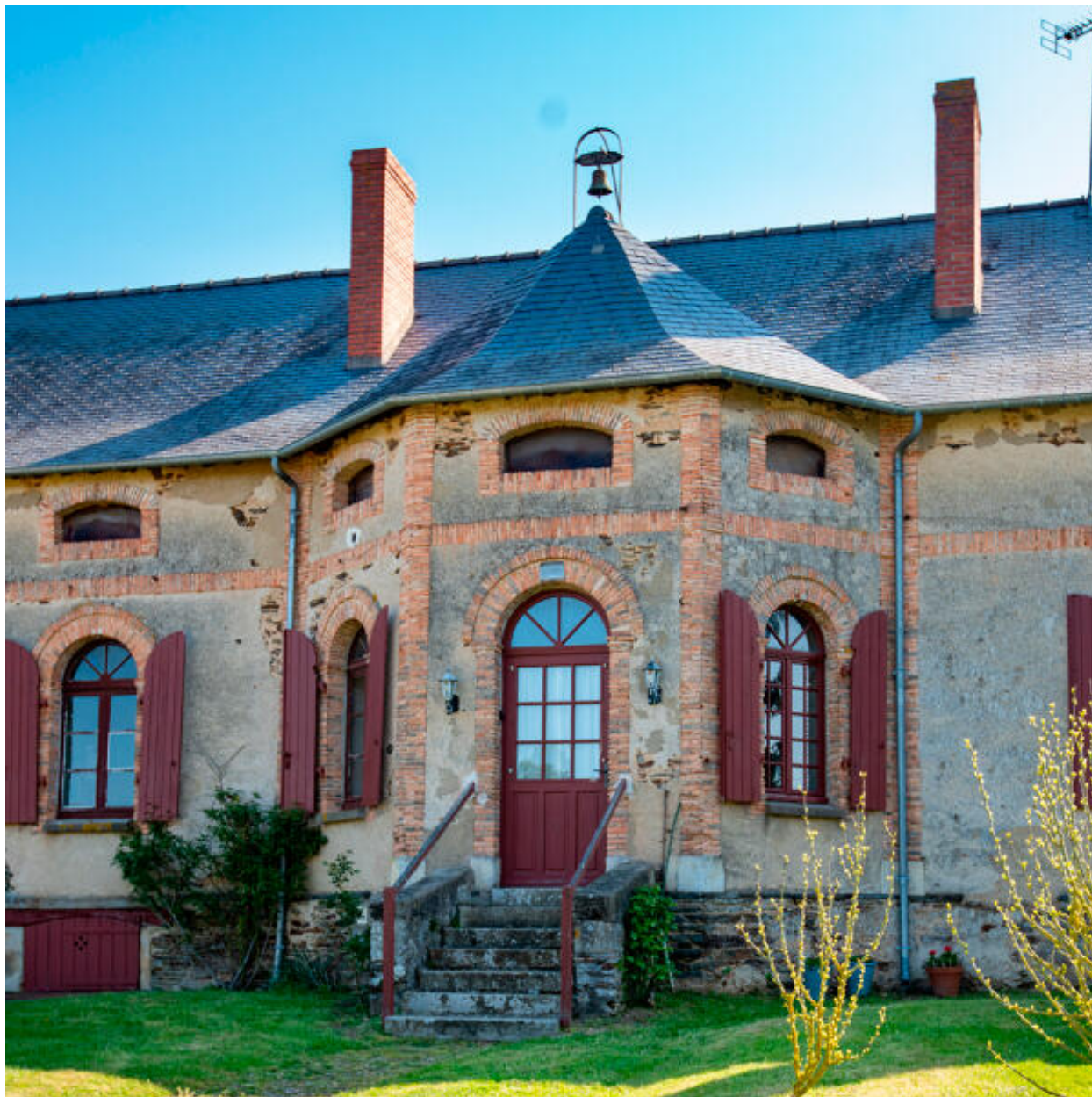
Le logis du fermier, détail de l'avant-corps.
