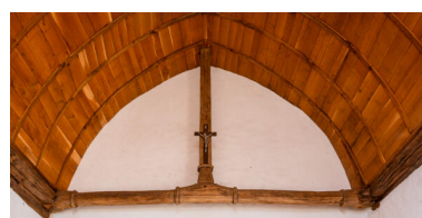
L'intérieur de la chapelle, détail du couvrement. Phot. Pierre-Bernard Fourny IVR52_20235300278NUCA
