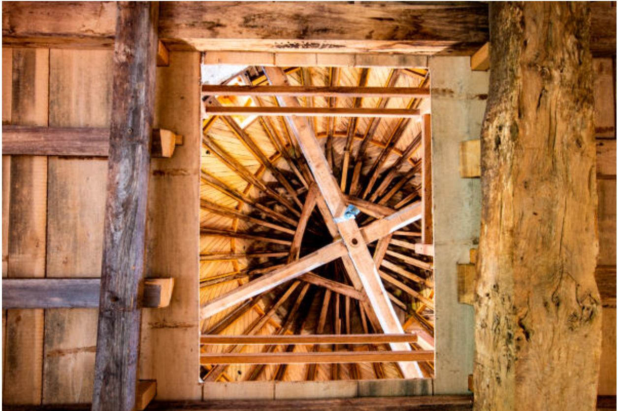
L'intérieur du pigeonnier, la charpente.
