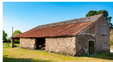
La grange-étable. Phot. Pierre-Bernard Fourny IVR52_20235300295NUCA
