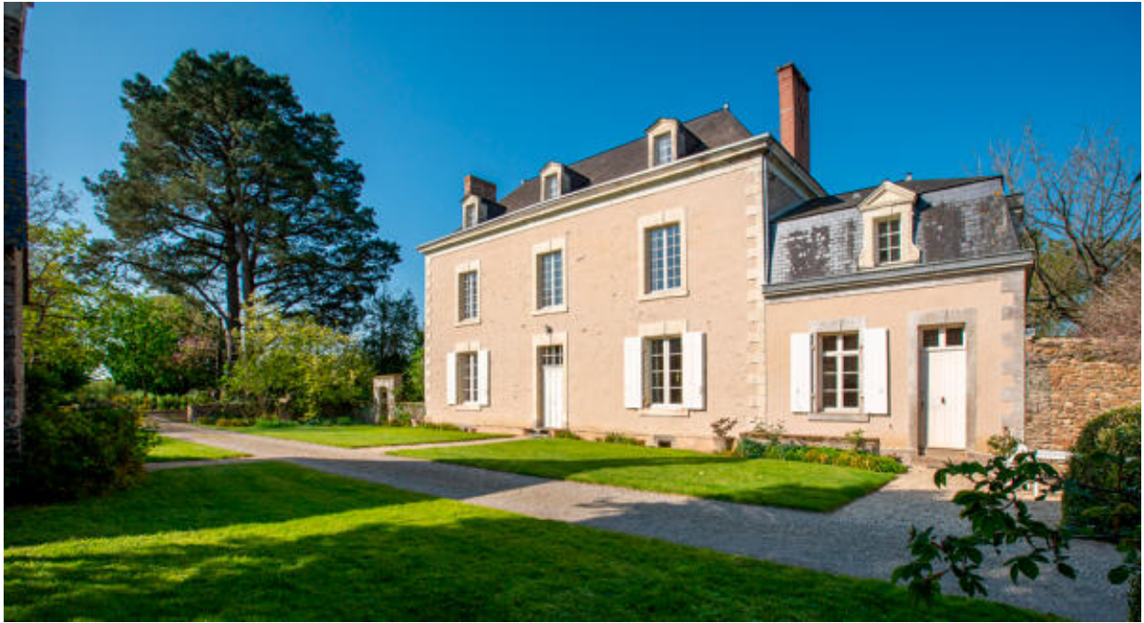
La demeure, élévation antérieure.
