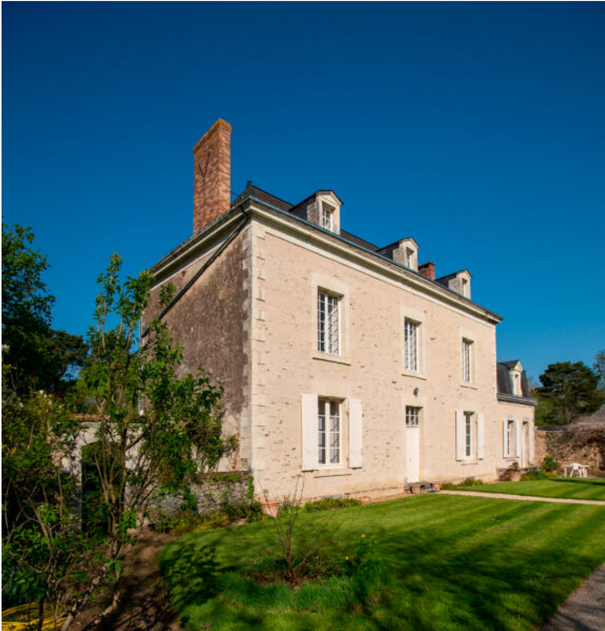
La demeure, élévation postérieure.
