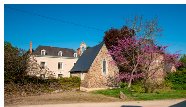
La demeure, la chapelle et le pigeonnier. Phot. Pierre-Bernard Fourny IVR52_20235300289NUCA
