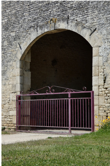
La porte charretière de la grange-étable-écurie. Phot. Yannis Suire IVR52_20238501796NUCA
