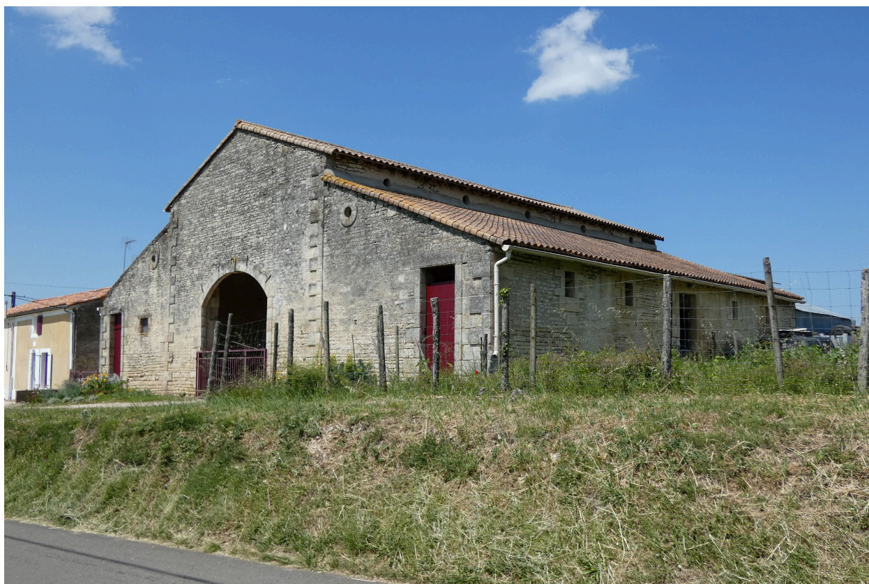
La grange-étable-écurie vue depuis le sud-est.
