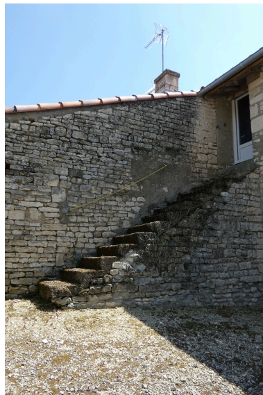
L'escalier extérieur sur le côté nord du logis. Phot. Yannis Suire IVR52_20238501791NUCA
