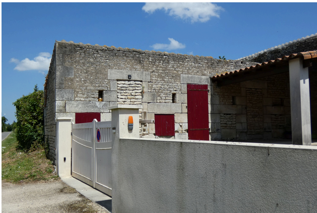
Le toit à porcs dans la cour nord.
