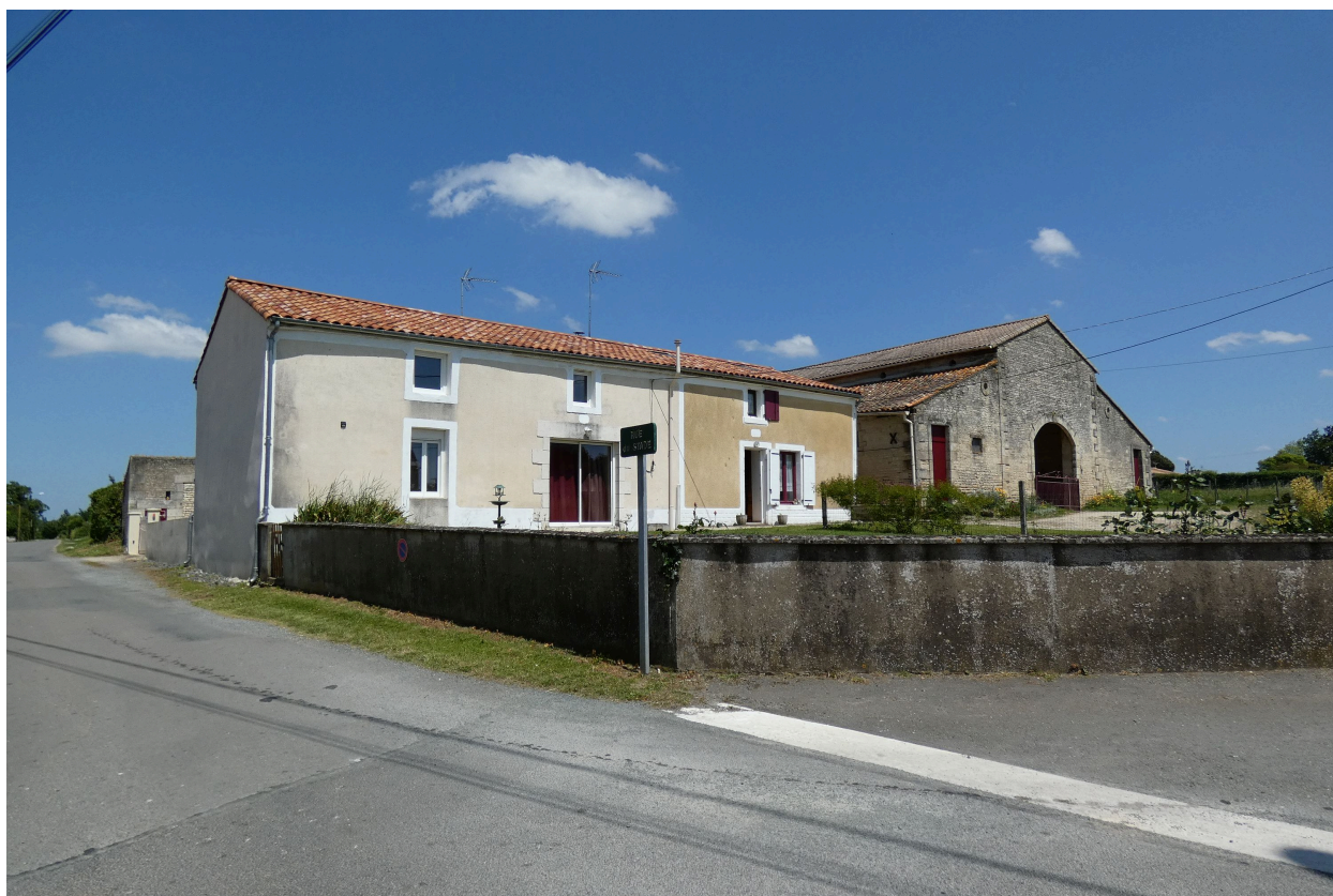
La ferme vue depuis le sud-ouest.
