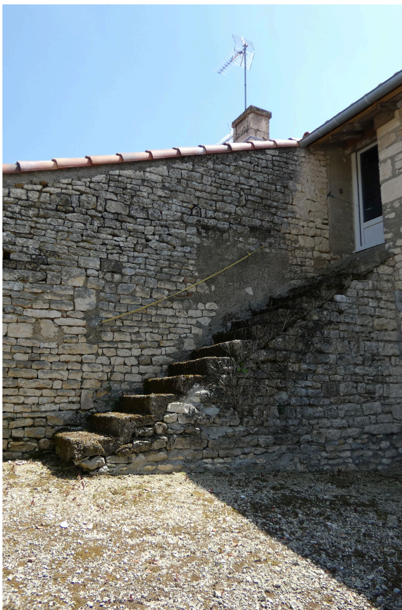
L'escalier extérieur sur le côté nord du logis.
