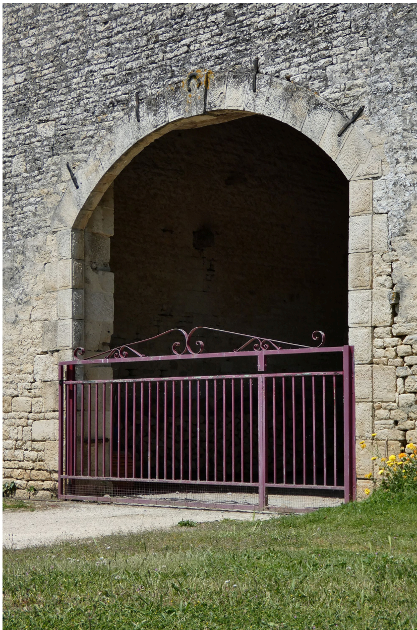
La porte charretière de la grange-étable-écurie.
