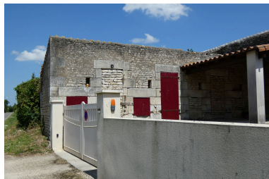
Le toit à porcs dans la cour nord. Phot. Yannis Suire IVR52_20238501790NUCA
