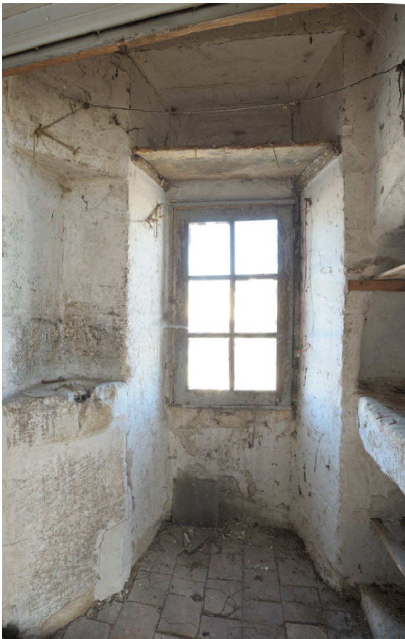
Etage, salle nord. Cabinet nord, vue d'ensemble, avec baie haute de la demi-croisée occluse.
