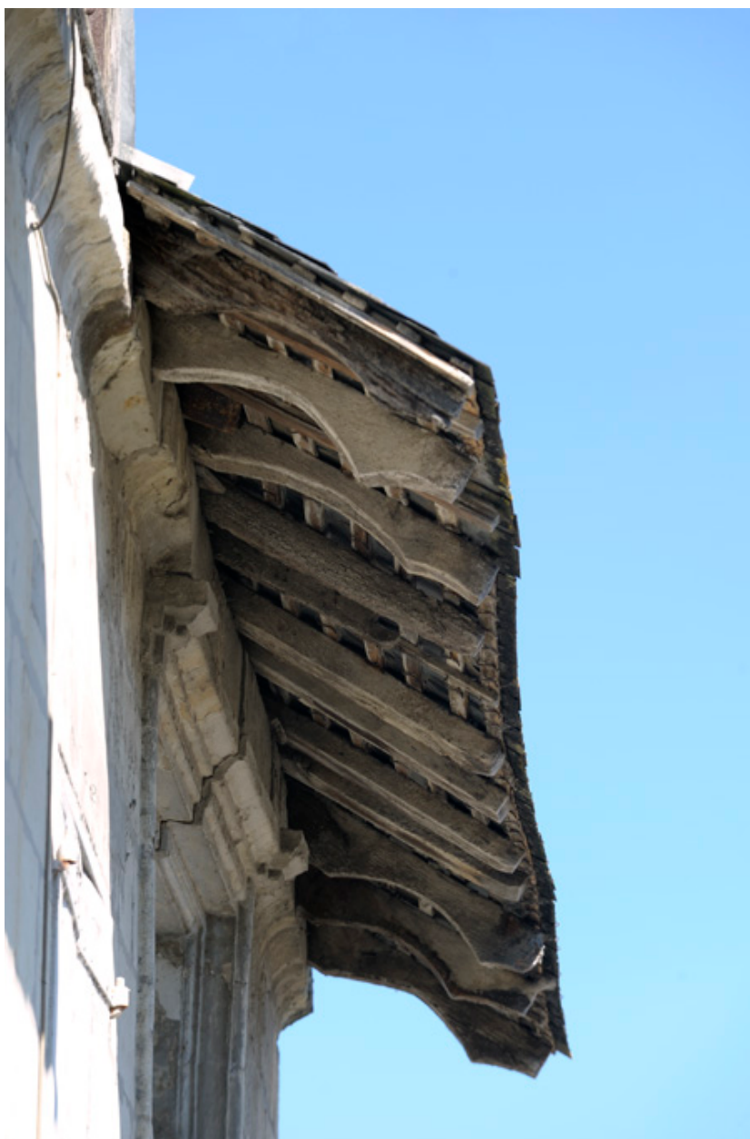
Façade est. Détail du profil des coyaux.
