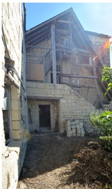
Façade ouest du logis, sur cour. Escalier extérieur. Phot. Bruno Rousseau IVR52_20124901522NUCA
