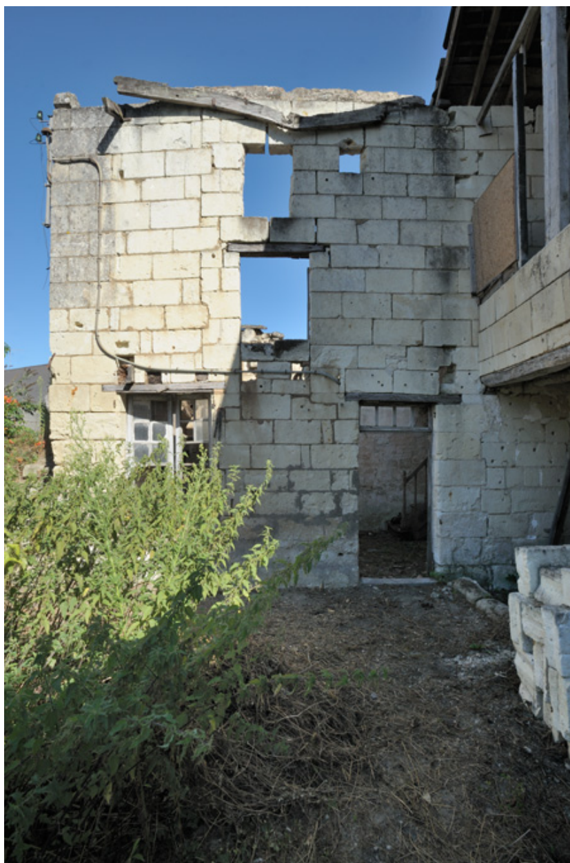
Ruines de l'appentis (seconde moitié XVIIIe ou début XIXe siècle) qui flanque le logis, à l'ouest.
