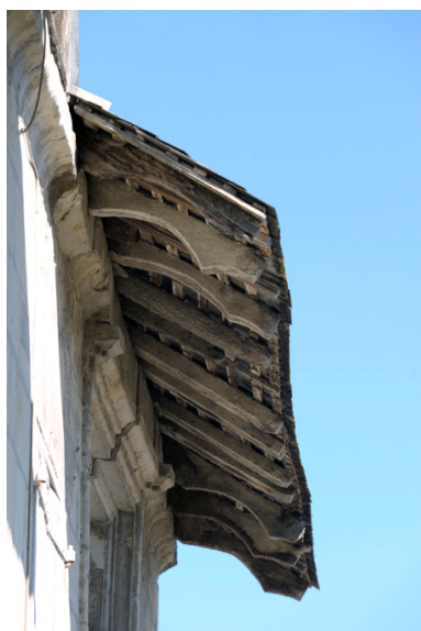
Façade est. Détail du profil des coyaux. Phot. Bruno Rousseau IVR52_20124901525NUCA
