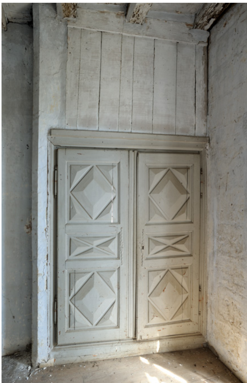
Etage, salle nord. Huisserie (XVIIe siècle ?) fermant le cabine nord.
