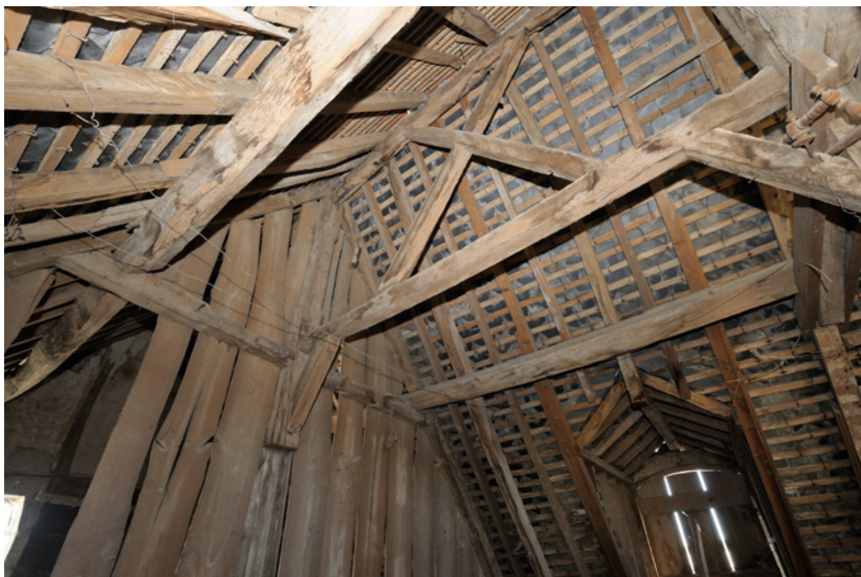
Comble. Charpente, avec panne sur entrain retroussé.
