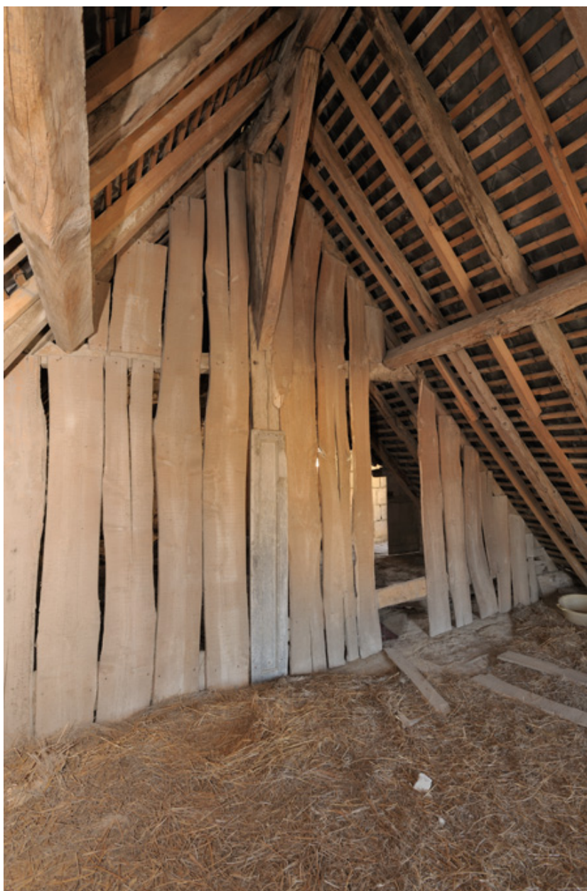
Comble. Détail de la séparation en planches du grenier, réalisée au XIXe siècle.
