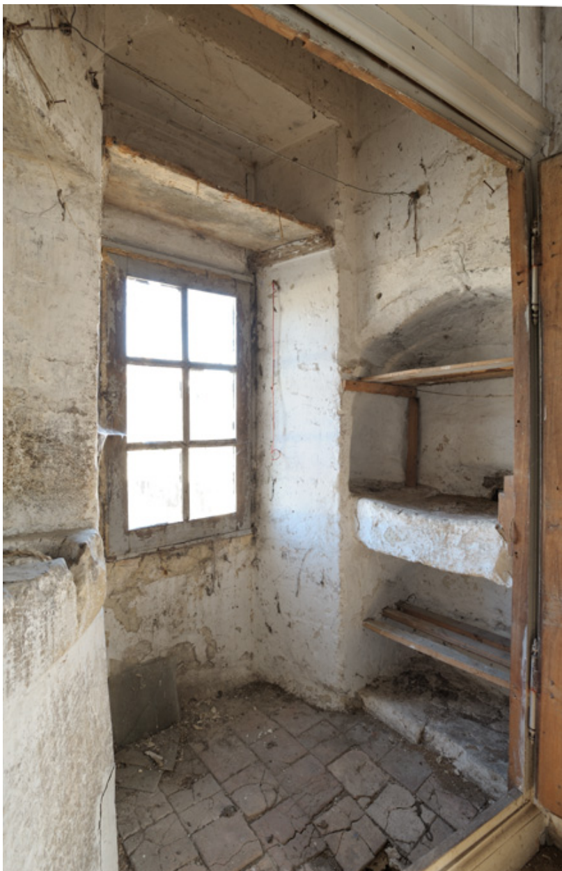
Etag, salle nord. Cabinet nord.
