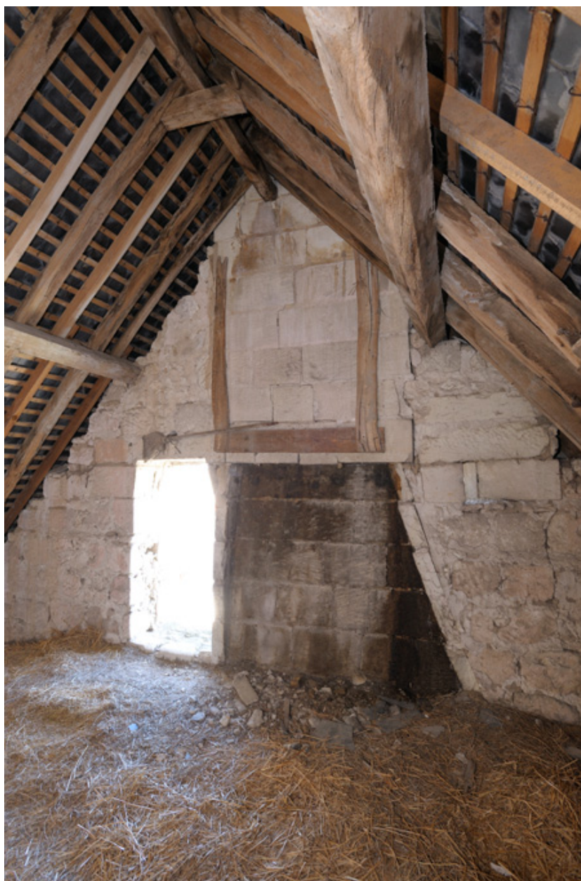
Comble. Pignon nord, avec conduit de cheminée et jour en biais pratiqué entre deux pierres de taille (à gauche).
