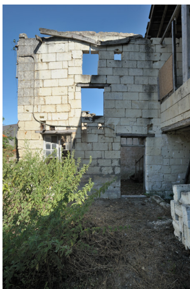
Ruines de l'appentis (seconde moitié XVIIIe ou début XIXe siècle) qui flanque le logis, à l'ouest. Phot. Bruno Rousseau IVR52_20124901519NUCA
