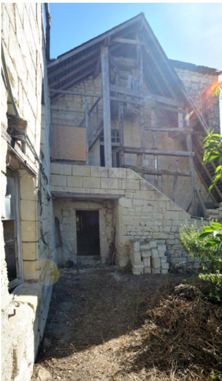
Façade ouest du logis, sur cour. Escalier extérieur.
