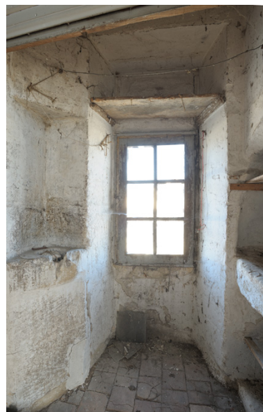
Etage, salle nord. Cabinet nord, vue d'ensemble, avec baie haute de la demi-croisée occluse. Phot. Bruno Rousseau IVR52_20124901516NUCA
