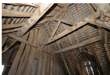
Comble. Charpente, avec panne sur entrait retroussé.
