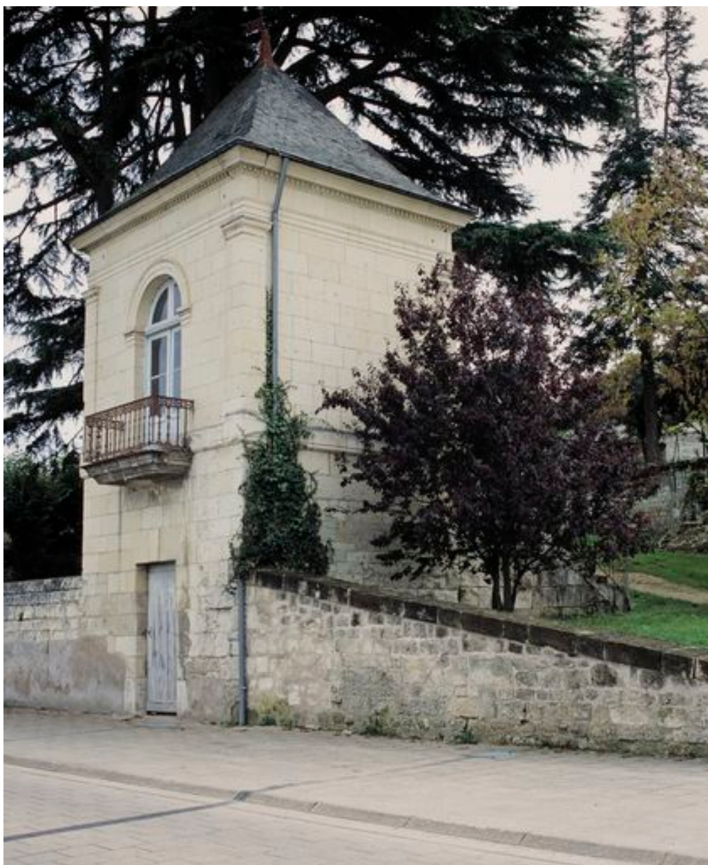
Pavillon : façade sur Loire, avant restauration.
