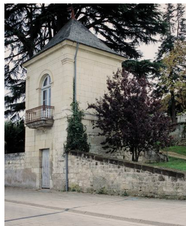
Pavillon : façade sur Loire, avant restauration. Phot. Bruno Rousseau IVR52_20014910064XA
