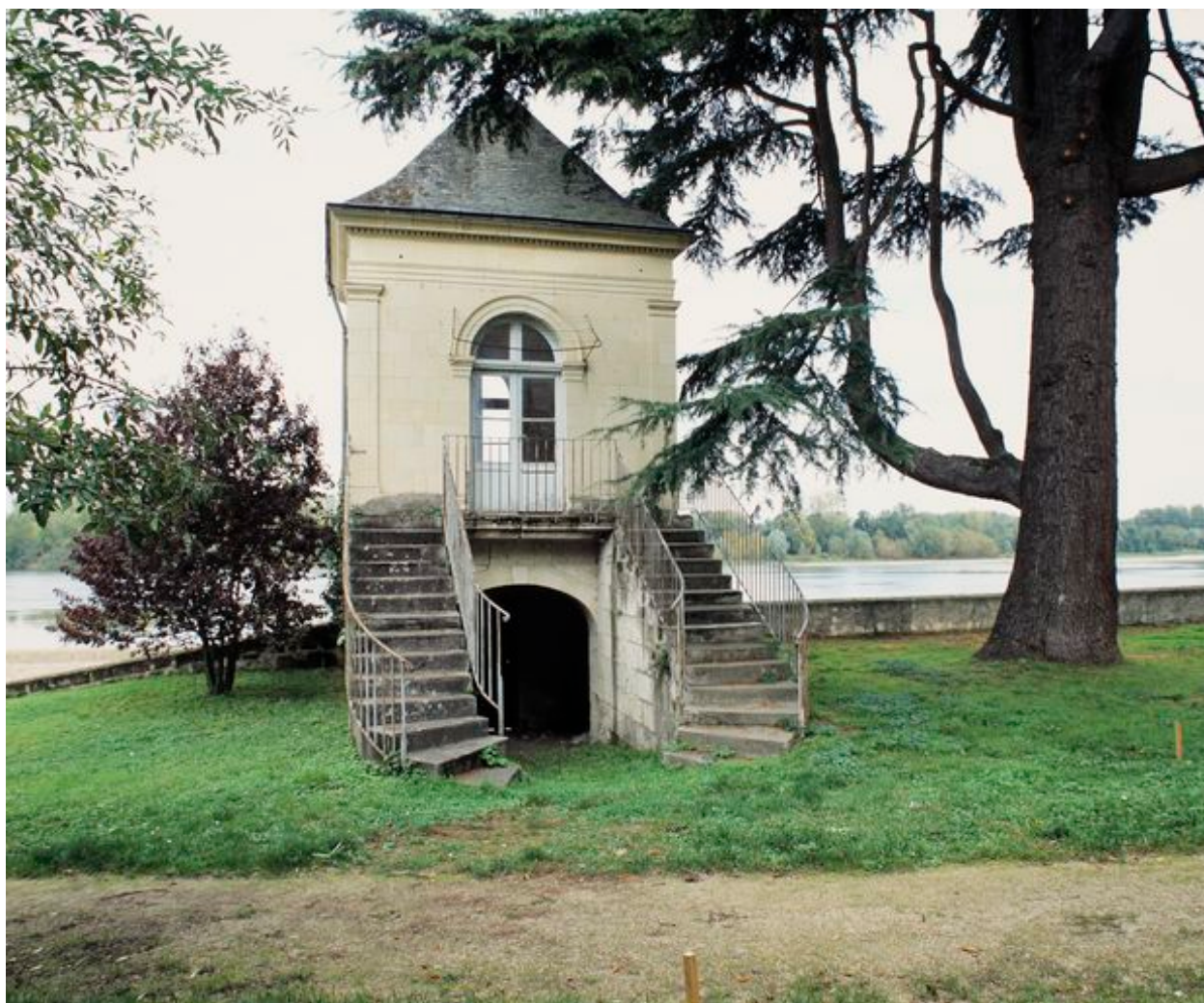
Pavillon : vue d'ensemble avant restauration.
