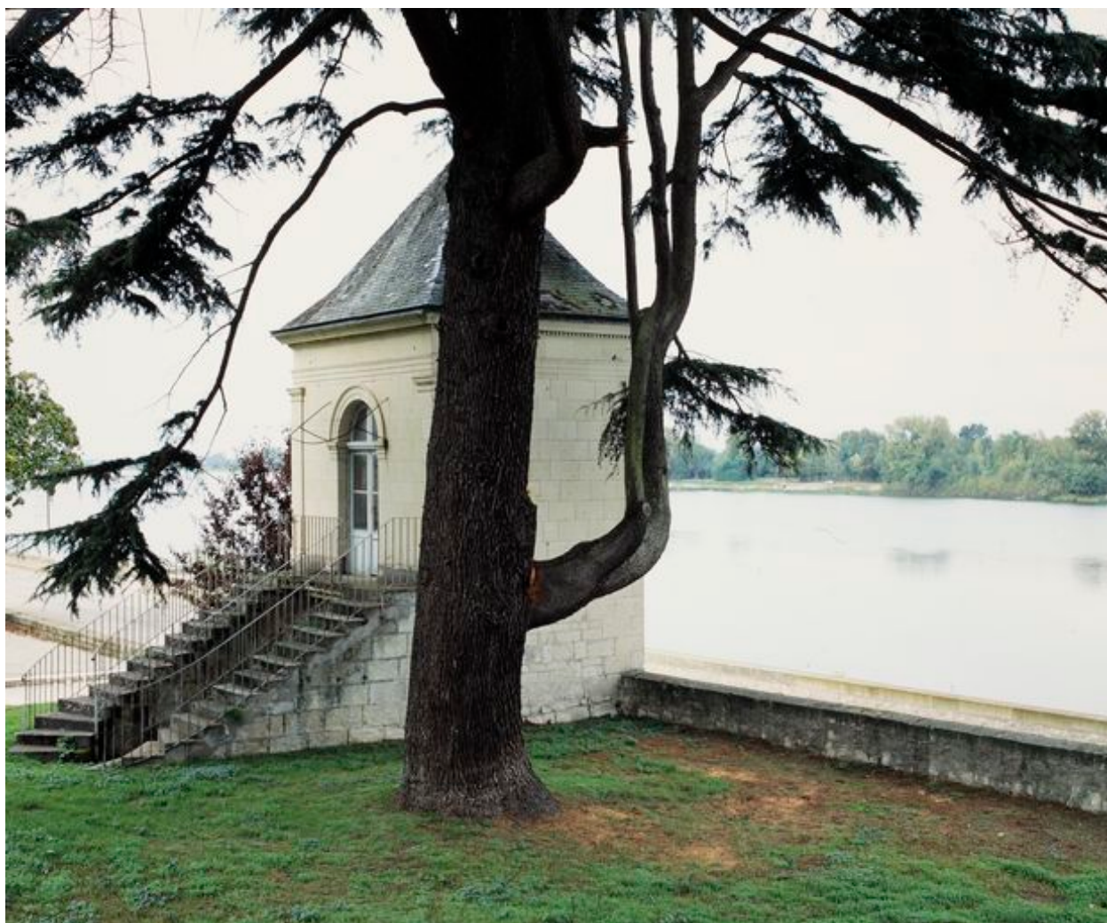
Pavillon : vue d'ensemble avant restauration.
