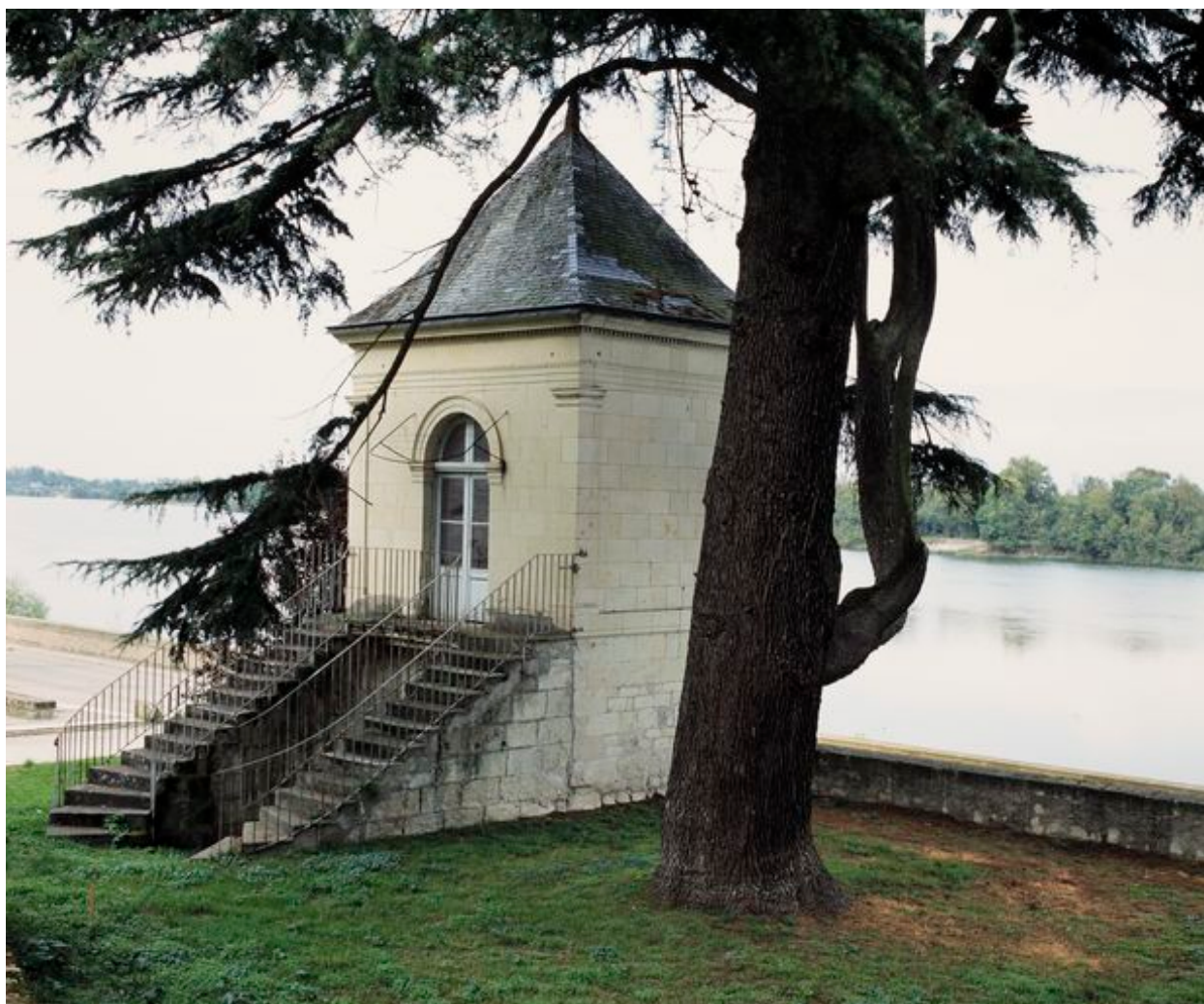
Pavillon : vue d'ensemble avant restauration.
