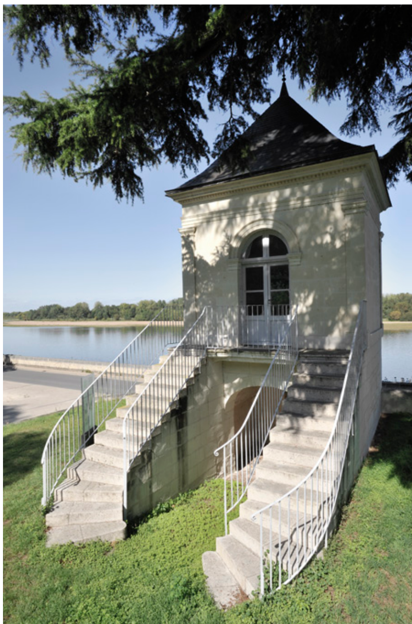
Pavillon : vue générale depuis le parc.
