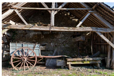
Hameau du Baz-Hazay, loge en pan de bois édifiée contre le mur-pignon ouest de l'alignement nord, charrette et maie de pressoir en bois. Phot. Yves Guillotin IVR52_20195300332NUCA
