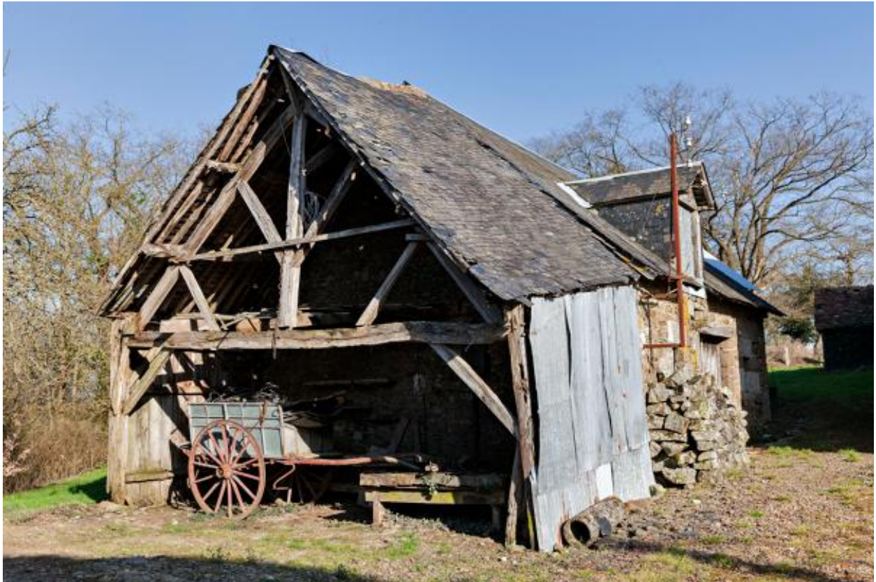
Hameau du Baz-Hazay, loge en pan de bois édifée contre le mur-pignon ouest de l'alignement nord.
