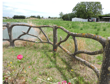
Détail de la clôture en faux bois de ciment. Phot. Yannis Suire IVR52_20198502162NUCA
