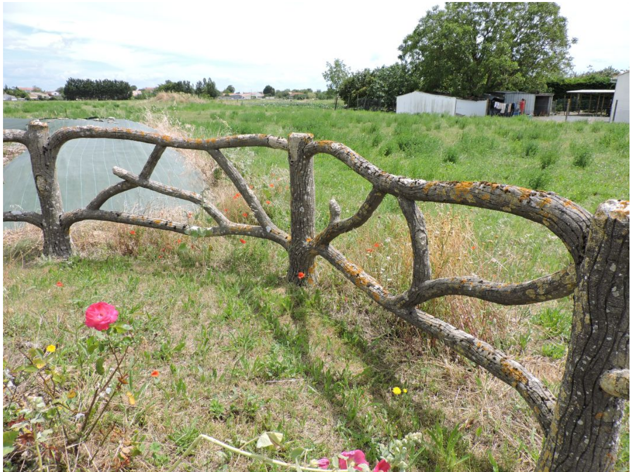
Détail de la clôture en faux bois de ciment.
