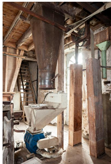
Premier étage, partie sud-ouest : vue depuis le nord-est : au premier plan, l'ensacheur à farine de blé qui a fonctionné jusqu'au début des années 1980 et dans lequel tombait la farine stockée dans la chambre ronde située au-dessus. Phot. Yves Guillotin IVR52_20205300020NUCA
