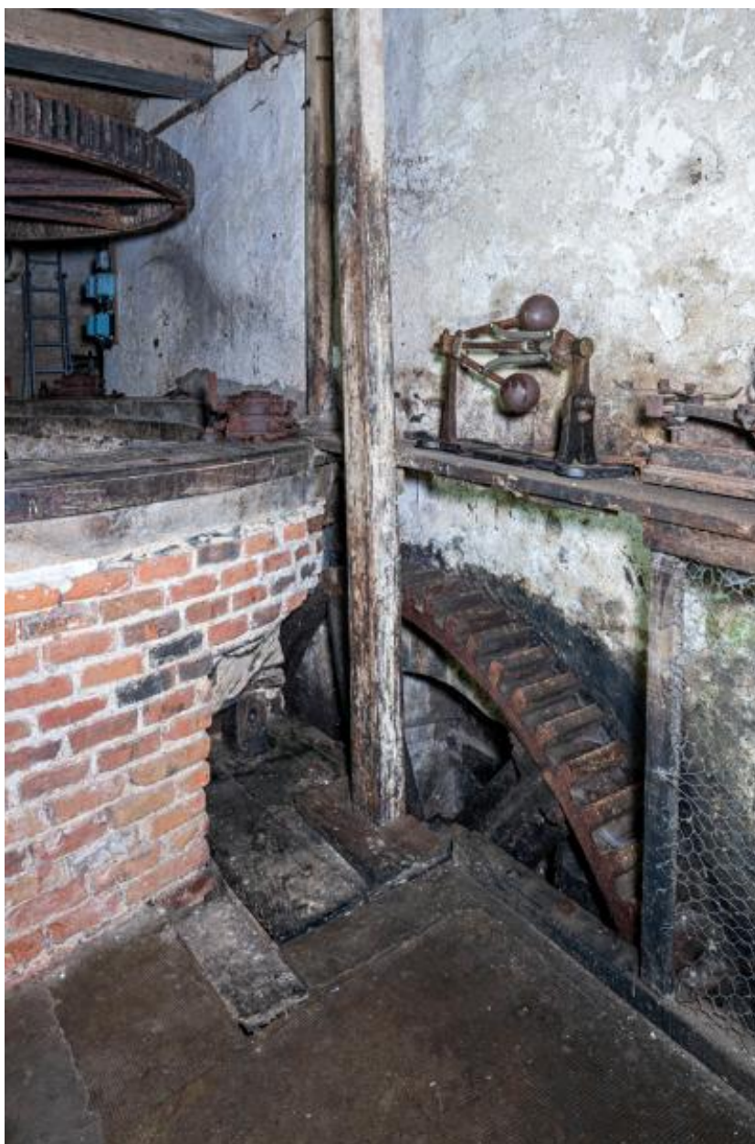
Rez-de-chaussée : le rouet de fosse, situé à l'extrémité de l'arbre de la roue hydraulique, vu depuis le sud-ouest. Au-dessus, le régulateur de vitesse provenant d'un autre moulin situé dans l'est de la France.
