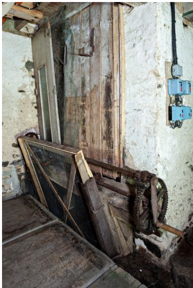
Rez-de-chaussée, angle nord- est : la vanne d'amont de la roue. Phot. Yves Guillotin IVR52_20205300026NUCA
