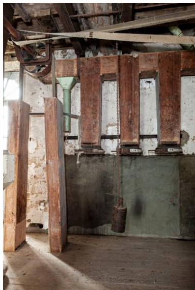
Premier étage, partie nord-ouest : les trois ensacheurs à son et à recoupe ou remoulage vues depuis l'est. Phot. Yves Guillotin IVR52_20205300019NUCA
