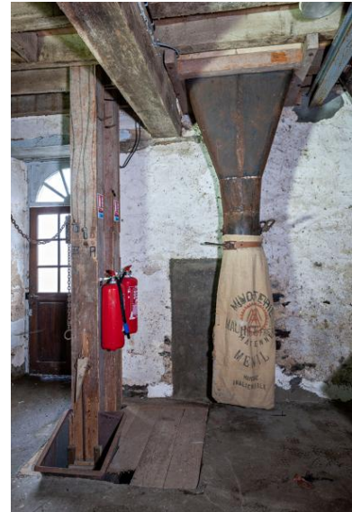
Rez-de-chaussée, partie sud vue depuis le nord : un des ensacheurs à farine et l'élévateur utilisé jusque dans les années 1970 pour le blé, amené en sacs et vidé dans la trémie située à sa base, puis pour l'orge. Phot. Yves Guillotin IVR52_20205300031NUCA
