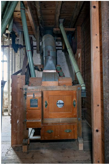
Deuxième étage, partie nord-est : la brosse à blé, de la marque Cesbron, vue depuis le sud. Installée vers 1958, elle est reliée à la chambre à blé propre. Phot. Yves Guillotin IVR52_20205300010NUCA
