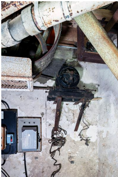
Rez-de-chaussée, mur ouest : dynamo qui était reliée à des batteries situées dans une dépendance et permettait, jusque vers 1955, l'éclairage du moulin et de la maison. Phot. Yves Guillotin IVR52_20205300027NUCA
