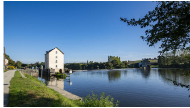
Le moulin. Phot. Pierre-Bernard Fourny IVR52_20235301660NUCA
