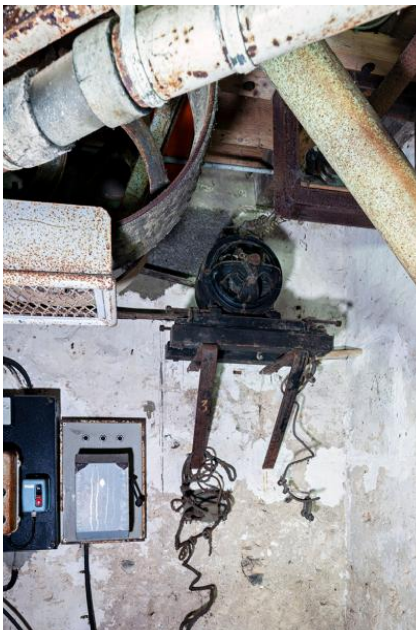
Rez-de-chaussée, mur ouest : dynamo qui était reliée à des batteries situées dans une dépendance et permettait, jusque vers 1955, l'éclairage du moulin et de la maison.
