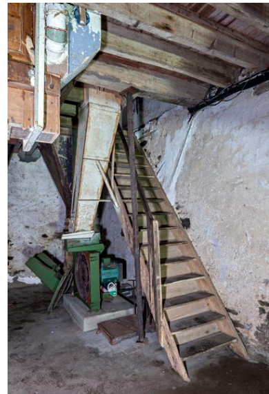
Rez-de-chaussée, partie sud-ouest : l'escalier et le broyeur à marteau utilisé pour l'orge (marque PROMIL, type B4C, N° 9252, date : 27/9/71). Phot. Yves Guillotin IVR52_20205300029NUCA
