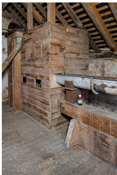
Étage en surcroît, partie nord-est vue depuis le sud-ouest : la chambre à blé propre. Phot. Yves Guillotin IVR52_20205300002NUCA
