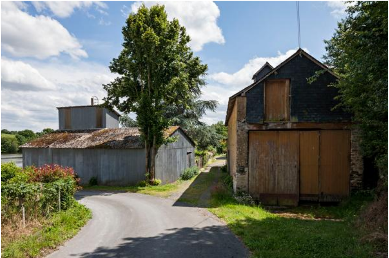
L'entrepôt à grains moderne et l'ancien entrepôt vus depuis le nord.
