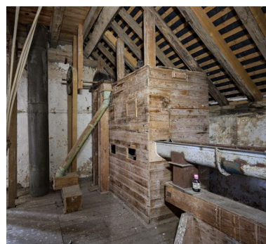
Étage en surcroît, partie nord-est vue depuis le sud-ouest : la chambre à blé propre, recevant le blé humidifié. Phot. Yves Guillotin IVR52_20205300046NUCA
