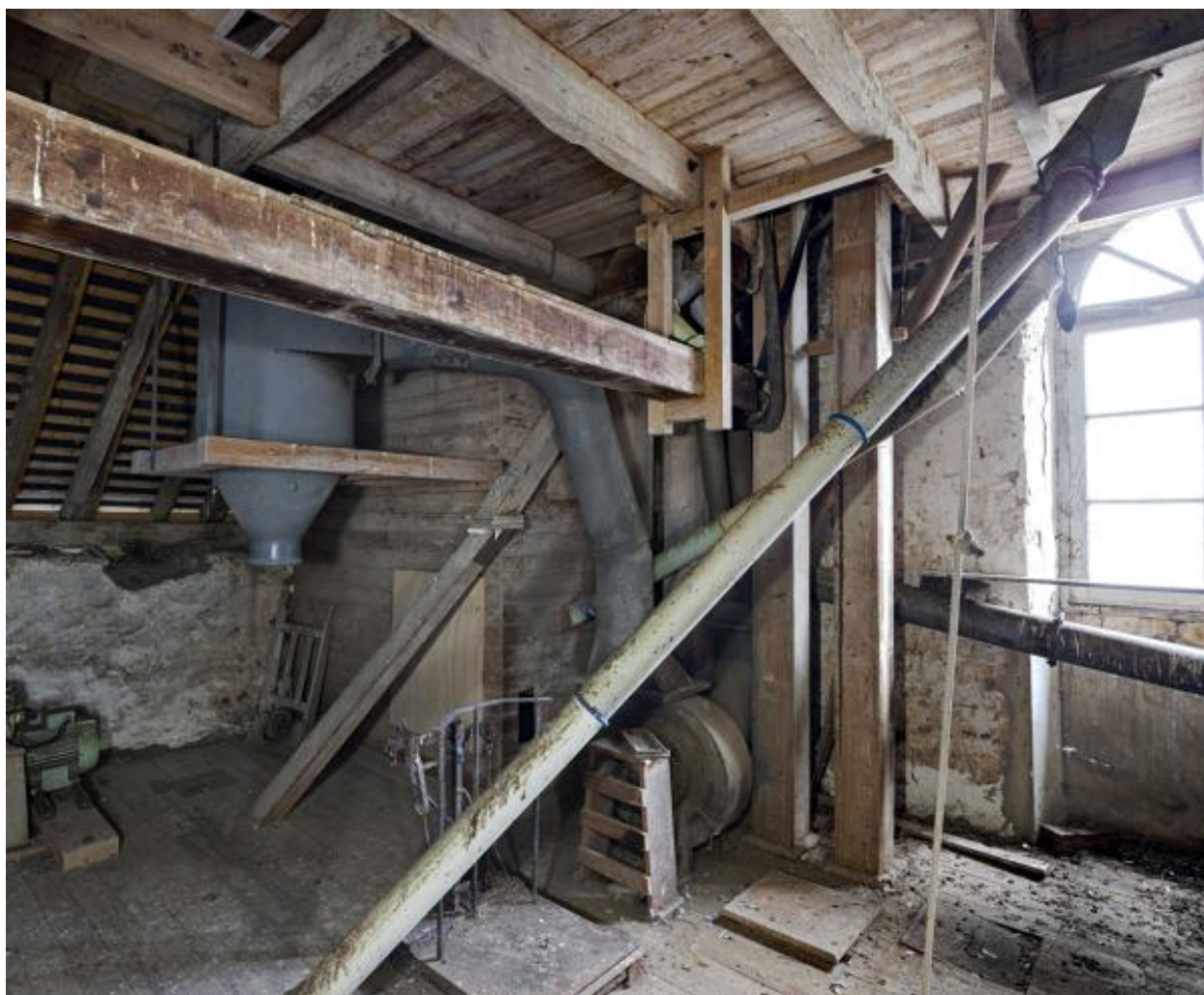
Étage en surcroît, partie sud-est vue depuis le nord-ouest : la chambre à blé sale et le récupérateur de poussière.
