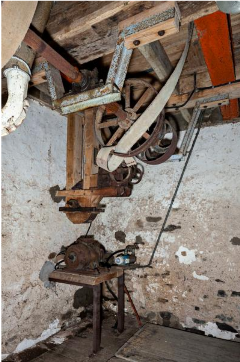
Rez-de-chaussée, angle nord-est : le moteur d'appoint de la roue (Moteurs Ch. Roulland, Vincennes, moteur asynchrone triphasé, type PL1202k, N°551947).
