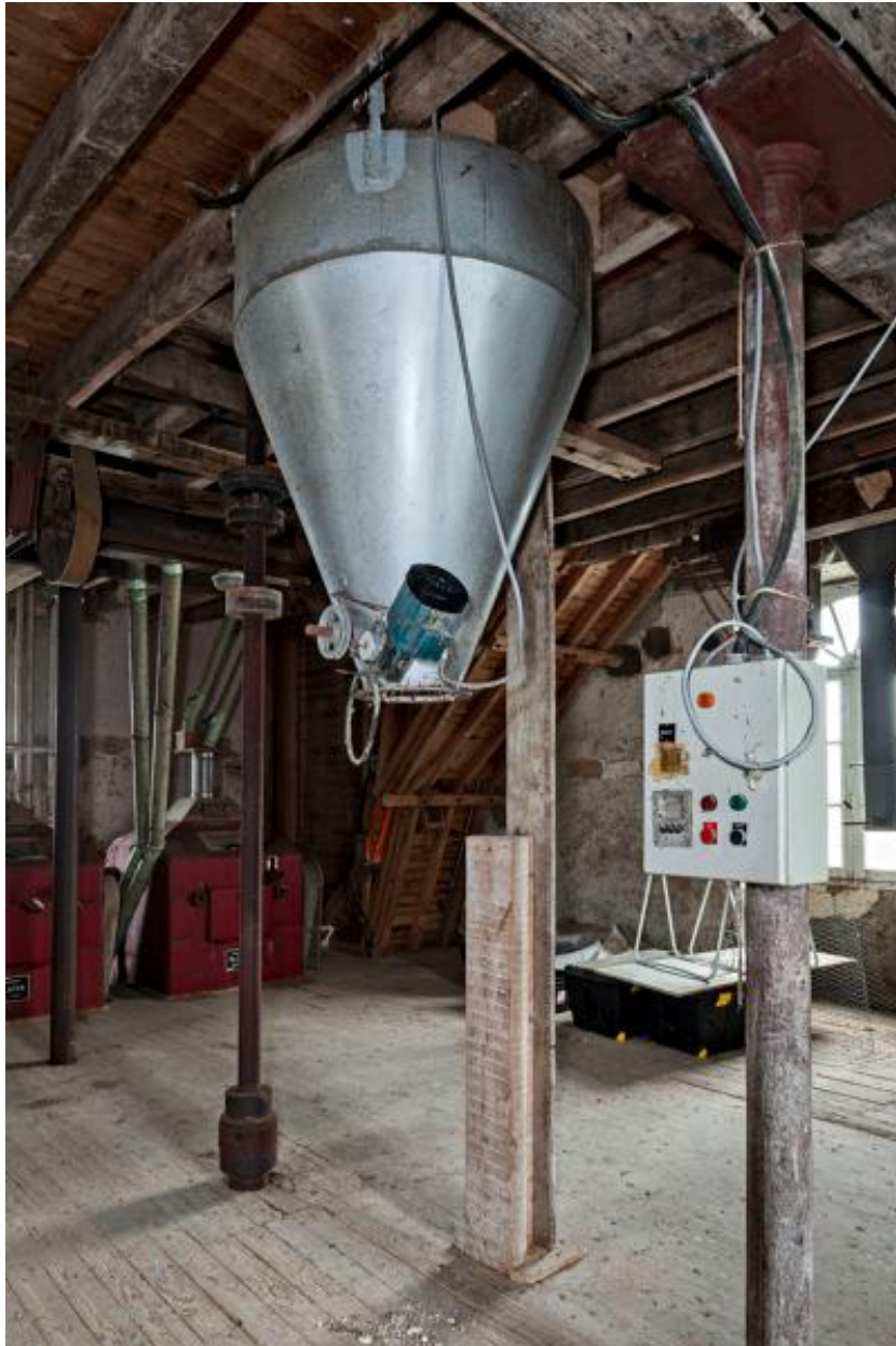
Premier étage, partie nord-est vue depuis le sud-ouest : au premier plan, l'ensacheuse-peseuse installée en mai 1981, achetée à Rodez (établissements Layrolle).
