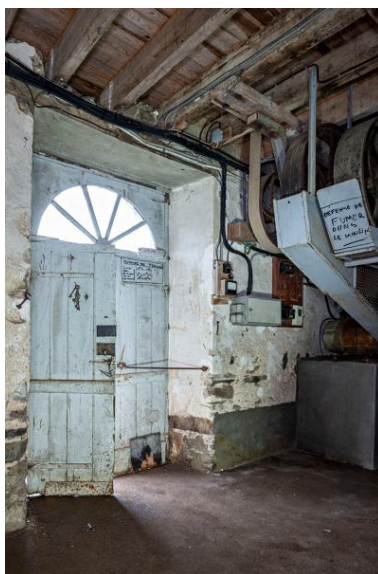
Rez-de-chaussée : la porte d'entrée, située côté ouest. Phot. Yves Guillotin IVR52_20205300036NUCA
