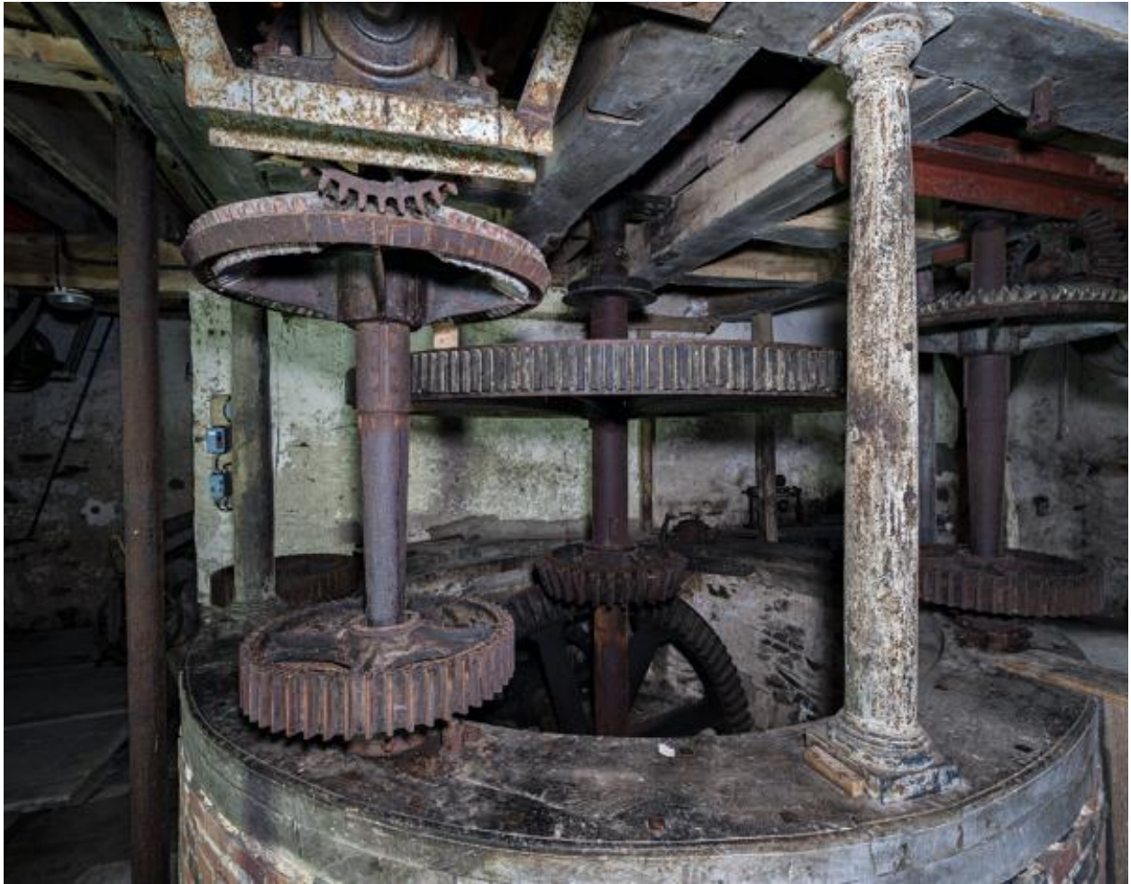
Rez-de-chaussée : le système de transmission, situé dans la poquerie, vu depuis l'ouest.
