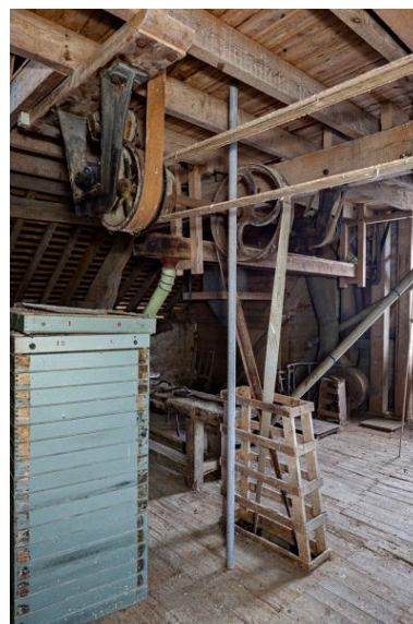
Étage en surcroît, partie sud-est vue depuis le nord-ouest : tiroirs provenant du plansichter et, au-dessus, courroies actionnant le monte-sac. Phot. Yves Guillotin IVR52_20205300004NUCA
