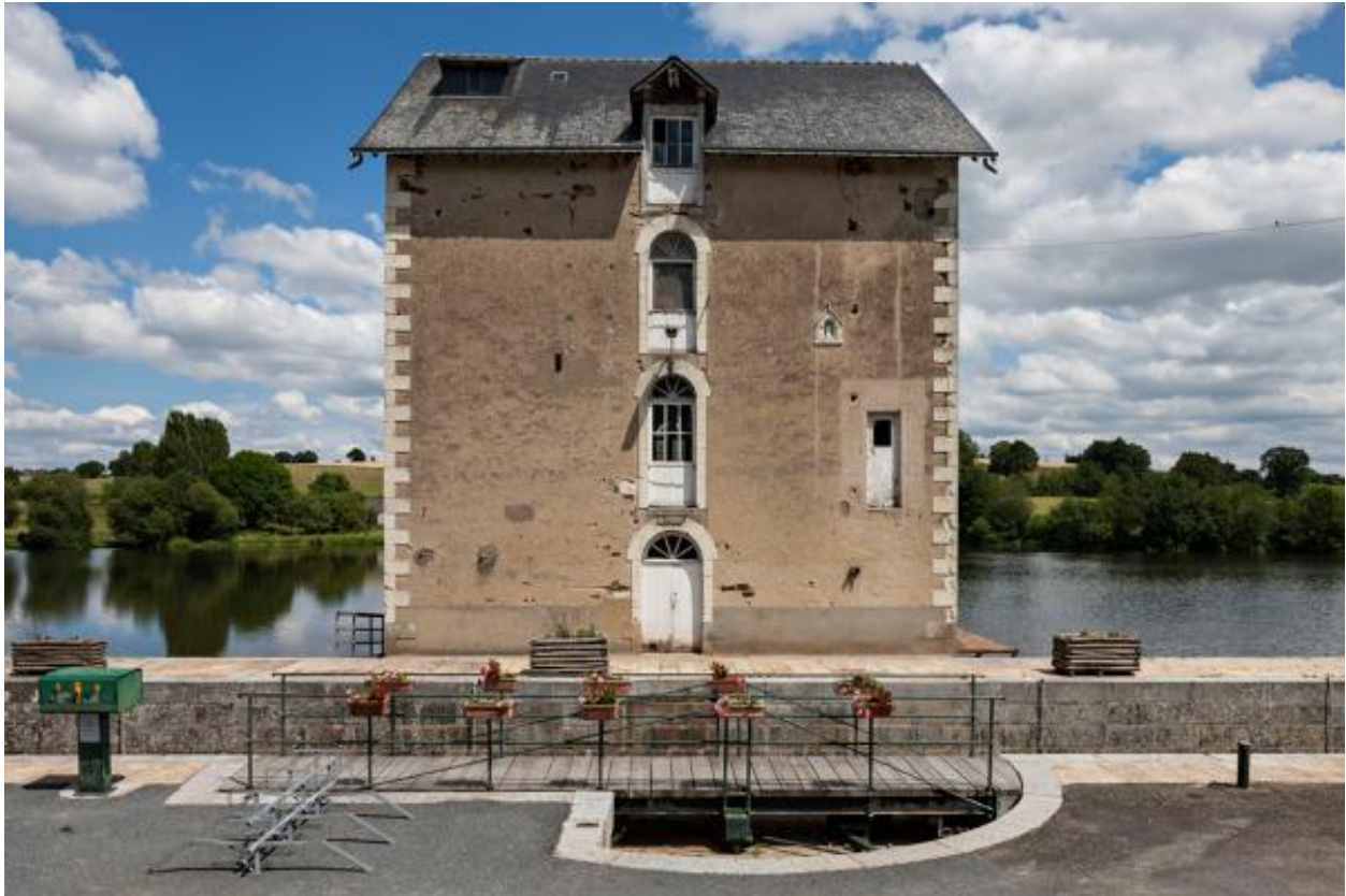
La façade ouest du moulin.
