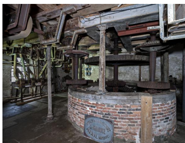
Rez-de-chaussée, partie nord- est vue depuis le sud-ouest : la poquerie contenant le système de transmission du moulin. Au fond, les conduites pneumatiques. Phot. Yves Guillotin IVR52_20205300060NUCA
