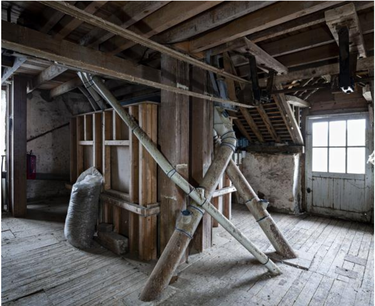
Étage en surcroît, partie sud-ouest vue depuis le nord-est : la chambre à farine installée en 1981.
