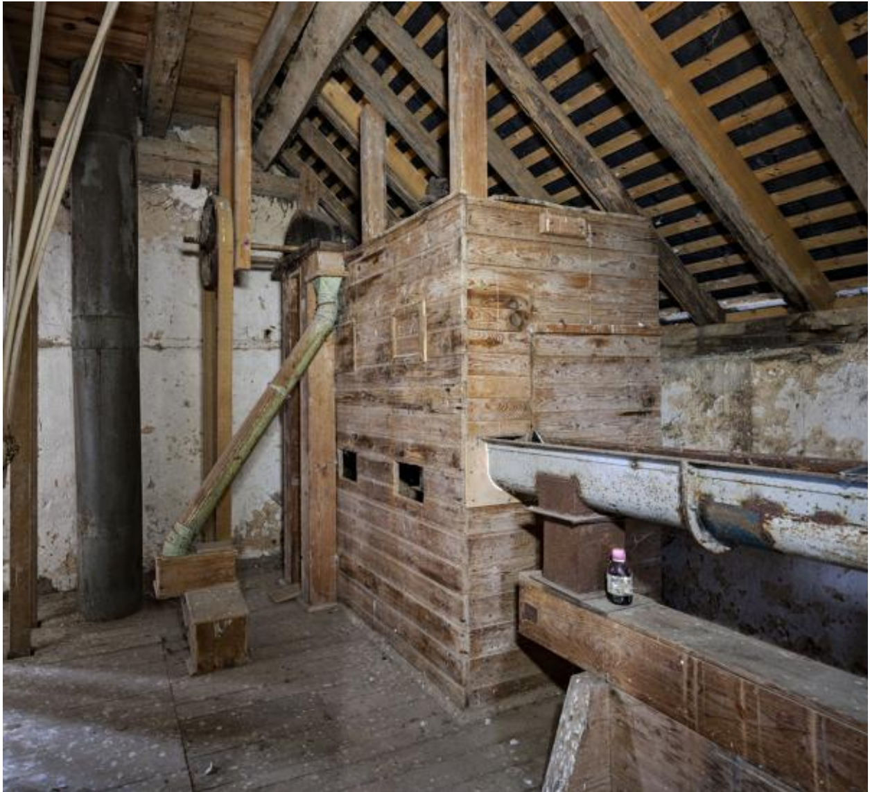
Étage en surcroît, partie nord-est vue depuis le sud-ouest : la chambre à blé propre, recevant le blé humidifié.
