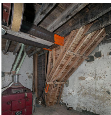
Premier étage, partie nord-est vue depuis le sud-ouest : la chambre à blé propre. Phot. Yves Guillotin IVR52_20205300055NUCA
