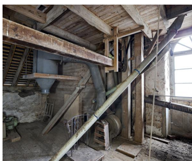
Étage en surcroît, partie sud-est vue depuis le nord-ouest : la chambre à blé sale et le récupérateur de poussière. Phot. Yves Guillotin IVR52_20205300043NUCA
