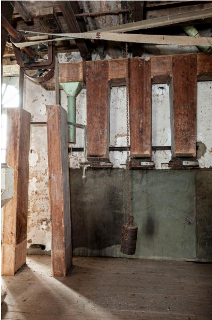
Premier étage, partie nord-ouest : les trois ensacheurs à son et à recoupe ou remoulage vues depuis l'est.
