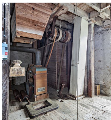
Deuxième étage, partie sud-est vue depuis le nord-ouest : le séparateur à blé et la chambre à blé sale. Au premier plan, emplacement du broyeur déplacé à l'étage inférieur et ayant servi d'aplatisseur à la fin de l'activité du moulin. Phot. Yves Guillotin IVR52_20205300051NUCA
