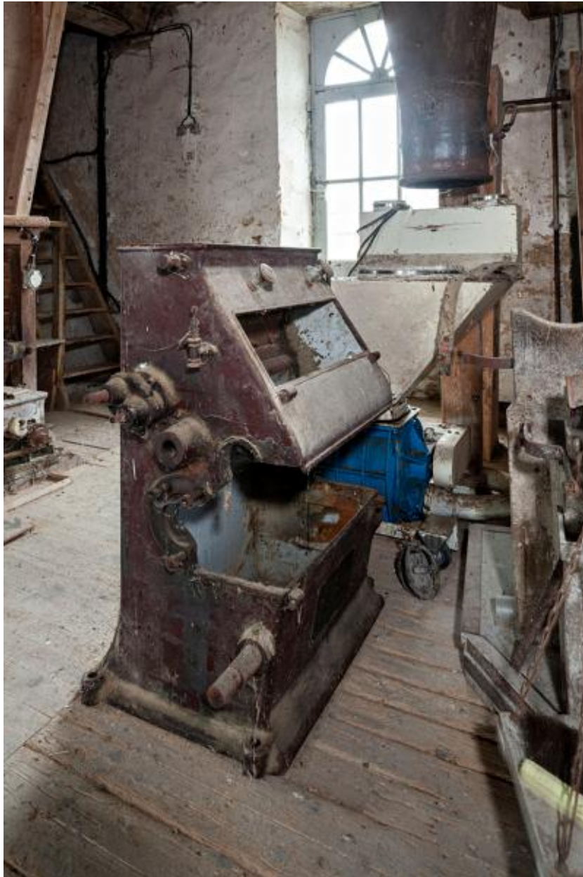
Premier étage, partie ouest : broyeur de la marque Lafon, acheté d'occasion vers 1975 près de Tours, et qui a été déplacé du deuxième étage.
