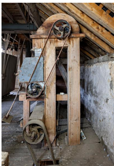
Étage en surcroît, partie est : l'élévateur accolé au mouilleur à blé vu depuis le sud. Il remontait le grain depuis le nettoyeur situé au deuxième étage. Phot. Yves Guillotin IVR52_20205300001NUCA
