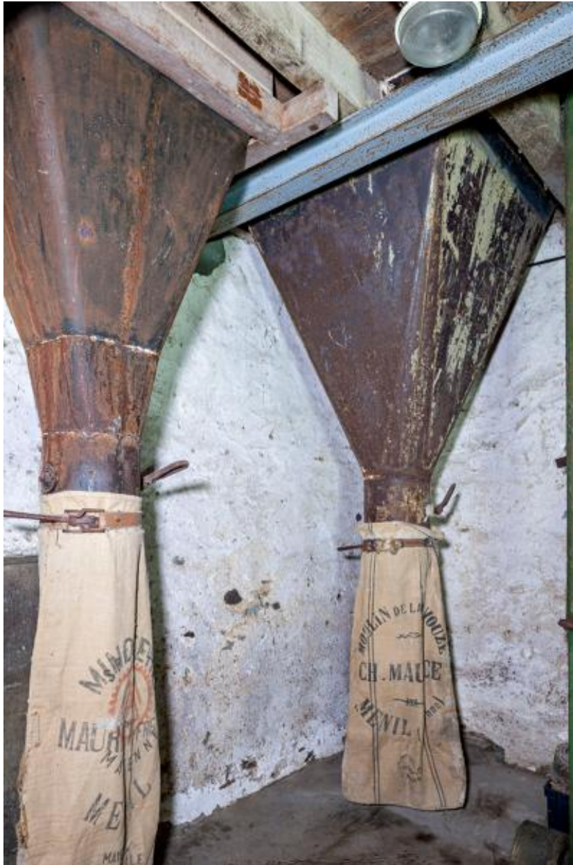
Rez-de-chaussée, partie sud-ouest : les ensacheurs à farine d'orge vus depuis le nord-est.
