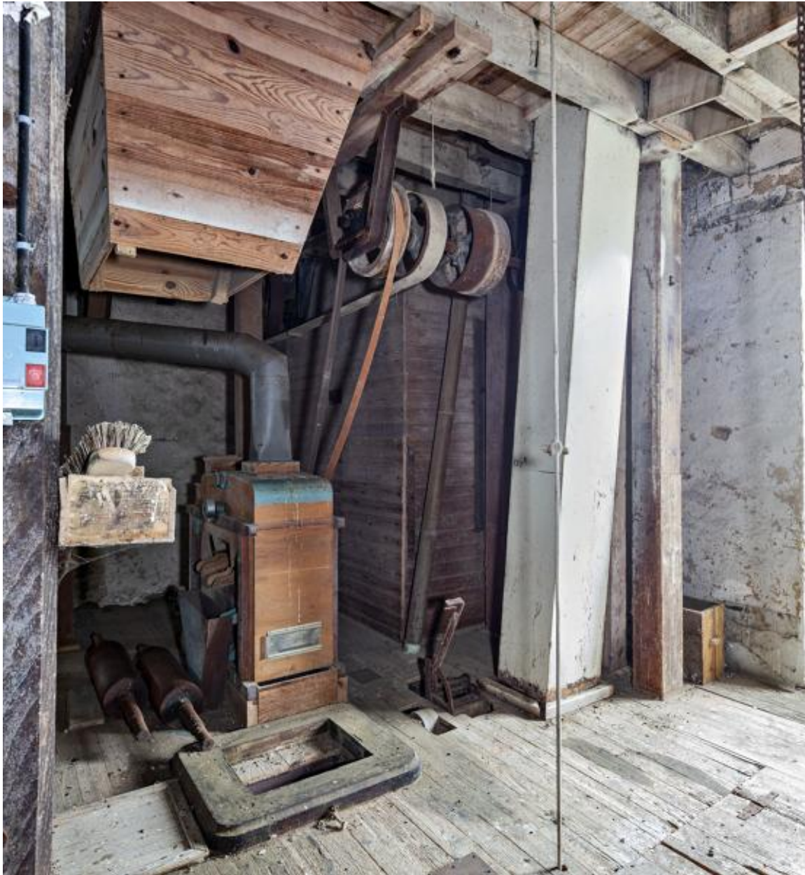
Deuxième étage, partie sud-est vue depuis le nord-ouest : le séparateur à blé et la chambre à blé sale. Au premier plan, emplacement du broyeur déplacé à l'étage inférieur et ayant servi d'aplatisseur à la fin de l'activité du moulin.
