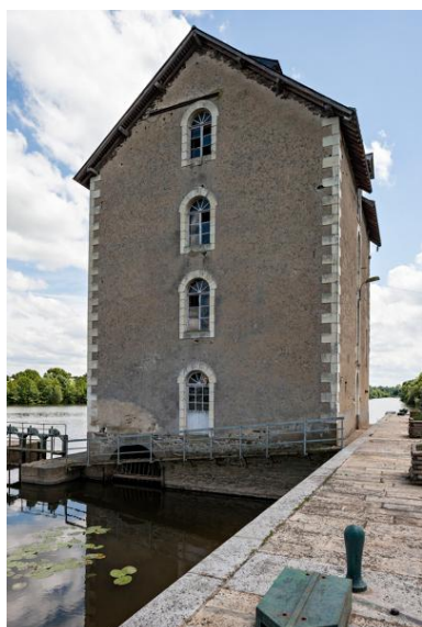
La façade nord du moulin, située à l'amont de la rivière. Phot. Yves Guillotin IVR52_20195301048NUCA
