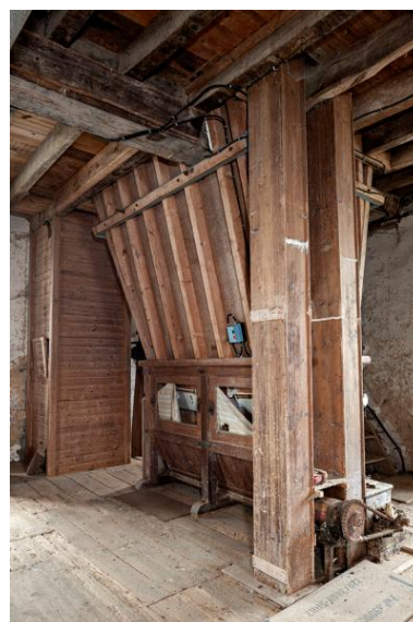
Premier étage, partie sud-ouest vue depuis le nord-est : à gauche, la chambre à farine d'orge ; au centre, la mélangeuse à farine de blé de la marque Teisset-Rosc-Brault, installée en 1981 en même temps que la chambre à farine de blé située au-dessus ; à droite, les élévateurs permettant de monter la farine au-dessus de la peseuse-ensacheuse installée en même temps que la chambre et la mélangeuse. Phot. Yves Guillotin IVR52_20205300021NUCA
