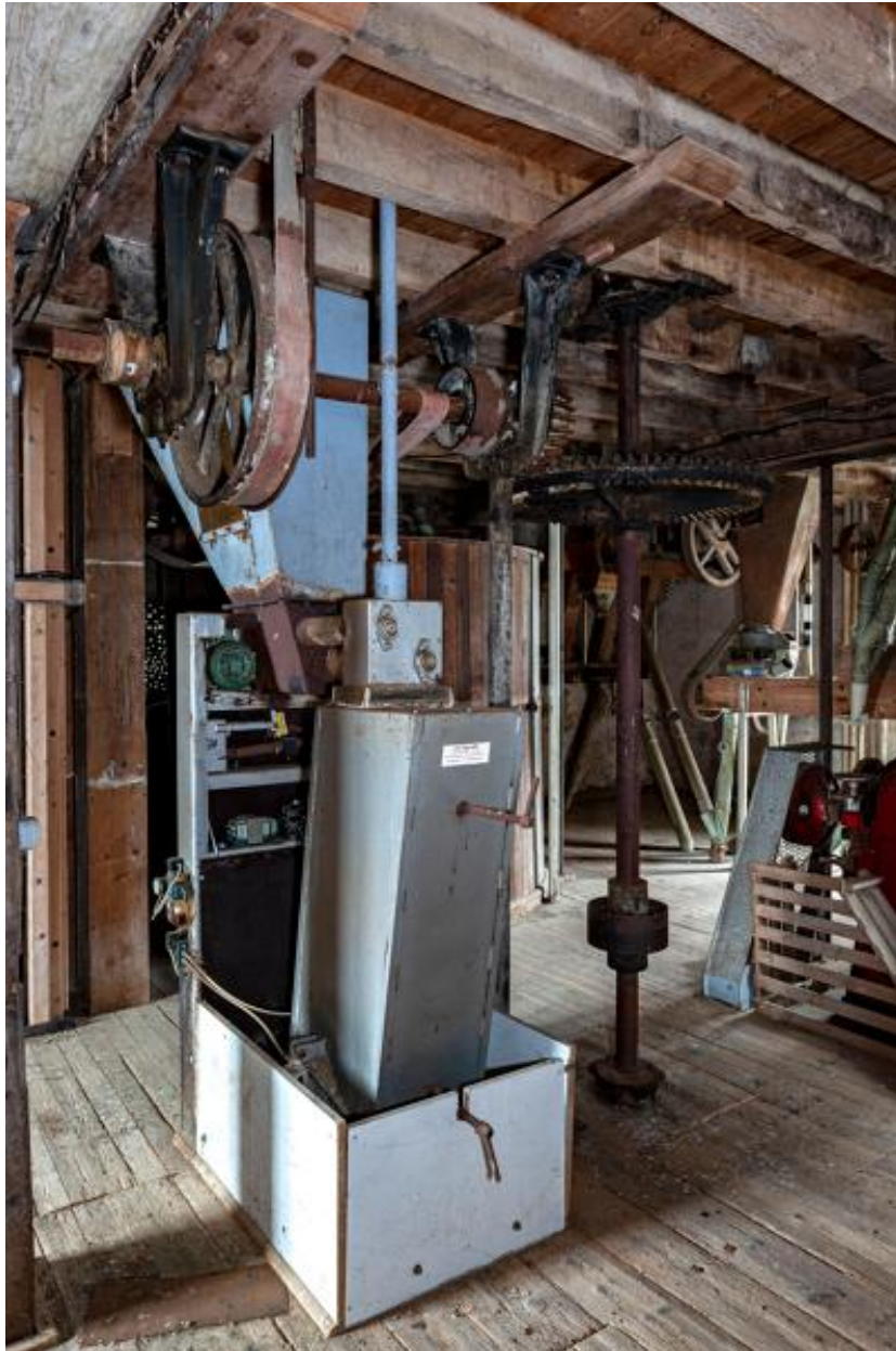
Deuxième étage, vue depuis le sud-est : partie supérieure de la peseuse-ensacheuse située à l'étage inférieur et installée en 1981.
