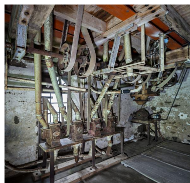
Rez-de-chaussée, partie nord vue depuis le sud-ouest : les conduites pneumatiques permettant la remontée de la mouture issue des broyeurs vers le plansichter. Au fond, dans l'angle, le moteur d'appoint de la roue. Phot. Yves Guillotin IVR52_20205300057NUCA
