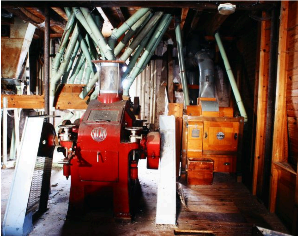
Deuxième étage, partie nord-est vue depuis le sud en 2002 : broyeur à cylindres de la marque SOCAM et brosse à blé de la marque Cesbron.
