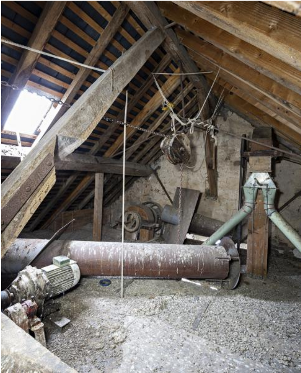
Comble, partie sud vue depuis le nord : les parties supérieures des deux élévateurs sud, la chaîne et la poulie du monte-sac.
