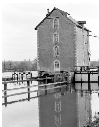
La façade nord du moulin, située en amont de la rivière, en 2002. Phot. François Lasa IVR52_20025300210X
