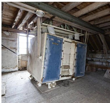
Étage en surcroît, partie nord : le plansichter vu depuis le sud-ouest.
