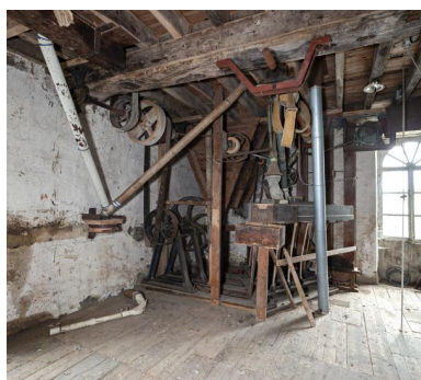
Premier étage, partie sud-est vue depuis le nord : l'épierreur et, au fond, la chambre à blé sale. Phot. Yves Guillotin IVR52_20205300054NUCA
