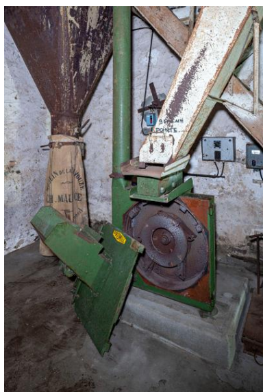
Rez-de-chaussée, partie sud-ouest vue depuis l'est : un des ensacheurs à farine d'orge et le broyeur à marteau utilisé pour l'orge. Phot. Yves Guillotin IVR52_20205300030NUCA
