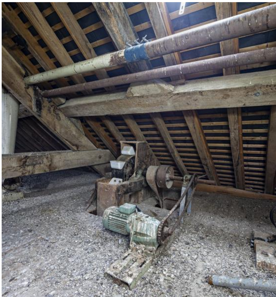
Comble, partie ouest vue depuis l'est : partie supérieure d'un élévateur sur lequel a été fixé un moteur.
