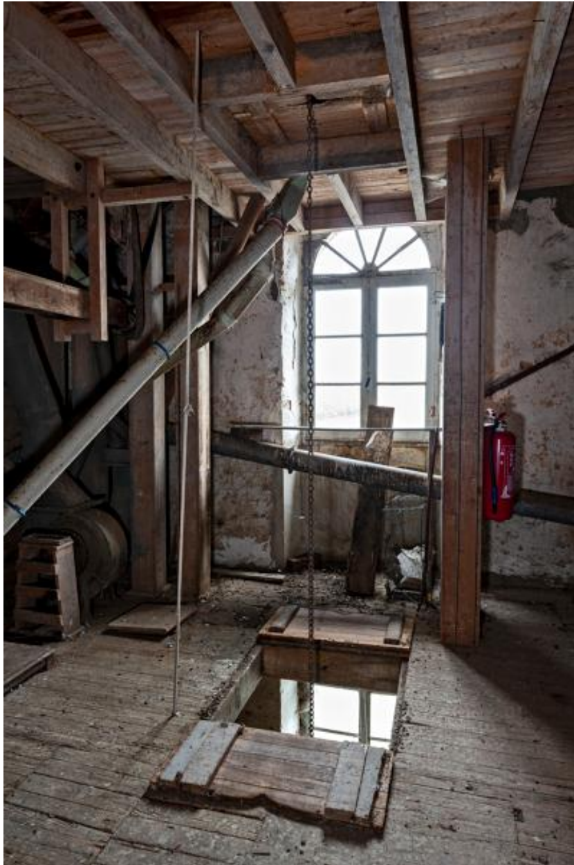
Étage en surcroît, partie sud vue depuis le nord : le monte-sac et les élévateurs à godets sud.
