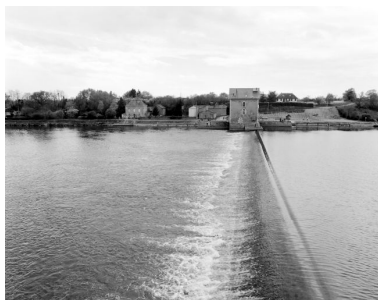
Vue d'ensemble du site du moulin depuis le moulin de la Grande-Bavouze sur la rive gauche, en 2002 : maison de meunier, dépendances, moulin. Phot. François Lasa IVR52_20025300554X
