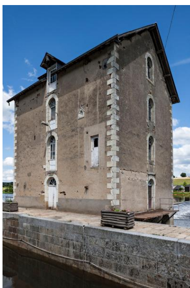
Les façades ouest et sud du moulin. Au premier plan, l'écluse. Phot. Yves Guillotin IVR52_20195301045NUCA
