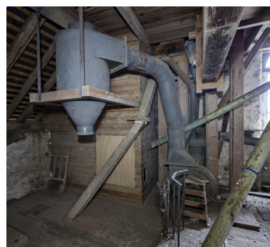
Étage en surcroît, partie sud-est vue depuis le nord : la chambre à blé sale et le récupérateur de poussière. Phot. Yves Guillotin IVR52_20205300044NUCA
