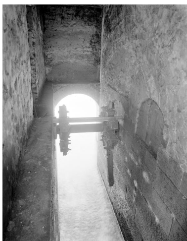
Le passage d'eau et les vestiges de la roue vus depuis le nord, en 2002. Phot. François Lasa IVR52_20025300221X
