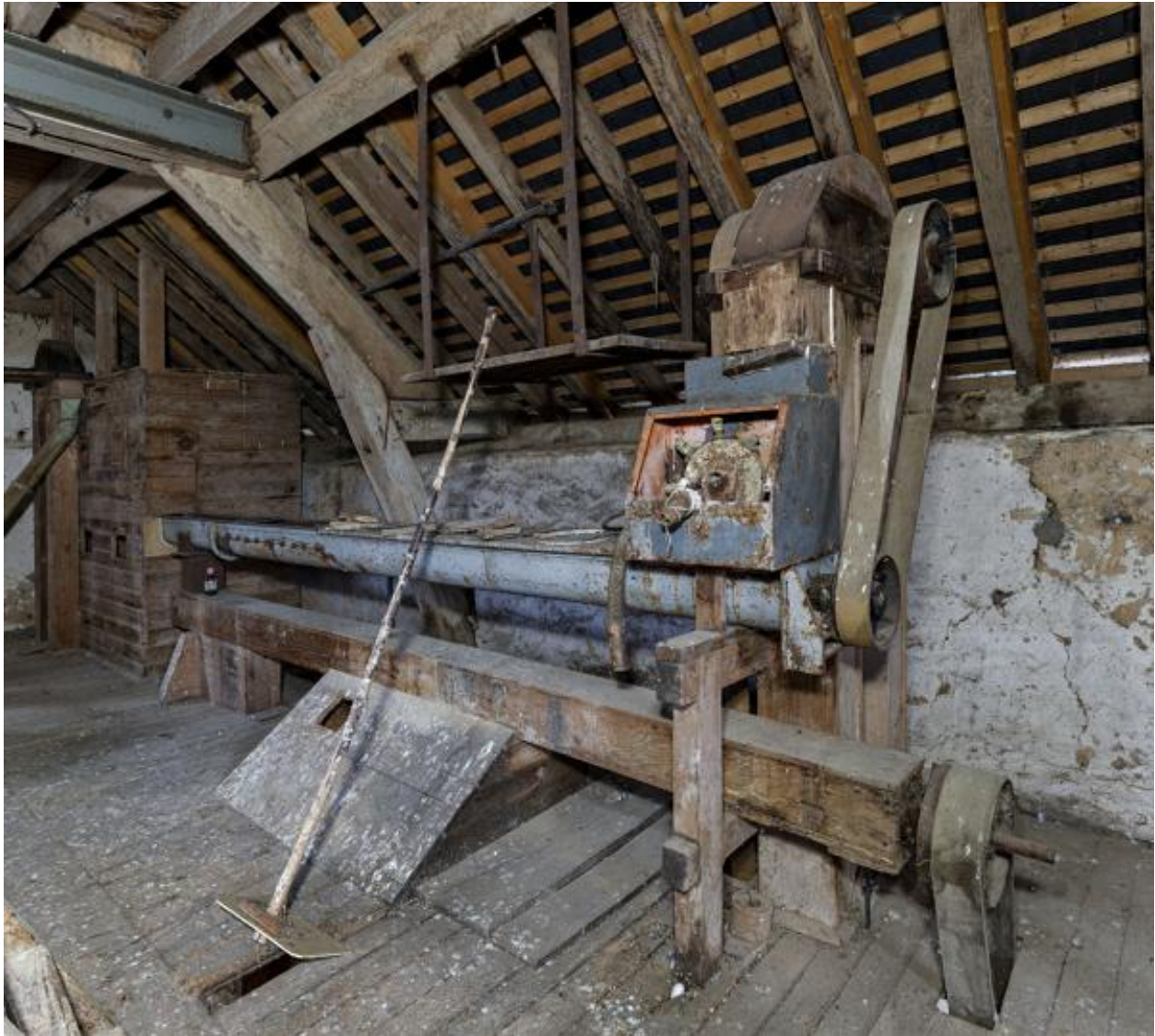
Étage en surcroît, partie est vue depuis le sud-ouest : le mouilleur à blé, avec sa vis sans fin, et l'élevateur qui y est adossé. A l'autre extrémité, la chambre à blé propre.
