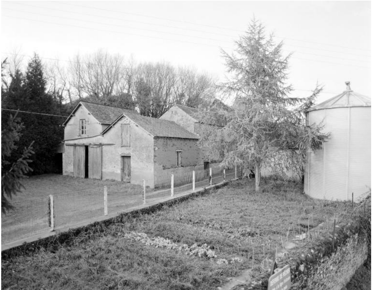
La remise et (à l'étage) les anciens logements d'ouvriers, vus depuis le sud-est, en 2002. A droite, le silo.
