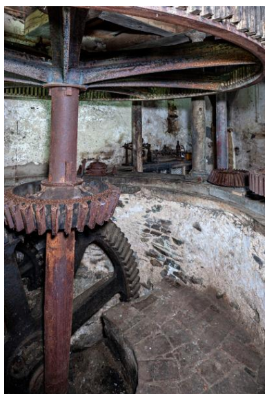
Rez-de-chaussée : vue rapprochée du système de transmission depuis le nord-ouest. Phot. Yves Guillotin IVR52_20205300028NUCA
