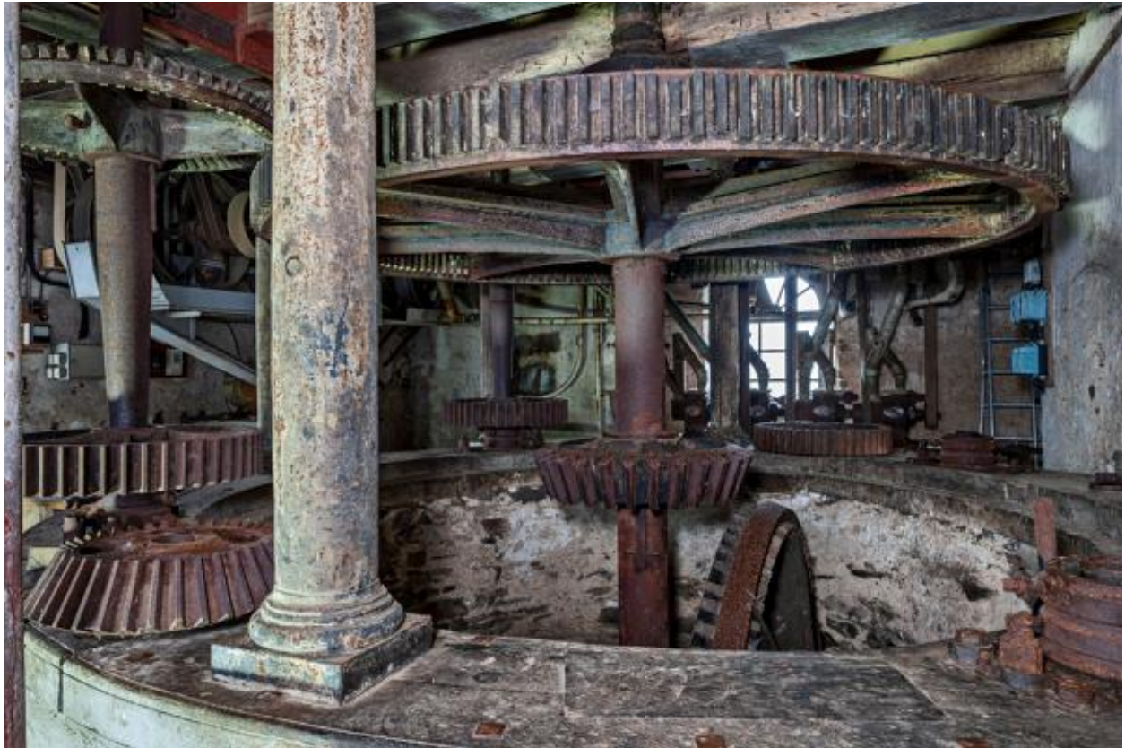
Rez-de-chaussée : la poquerie, contenant le système de transmission, vue depuis le sud.
