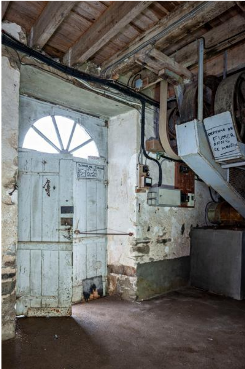
Rez-de-chaussée : la porte d'entrée, située côté ouest.
