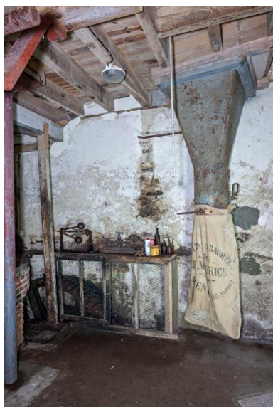
Rez-de-chaussée, partie sud-est vue depuis l'ouest : l'ensacheur qui recevait la mouture de l'aplatisseur qui se trouvait juste au-dessus. Phot. Yves Guillotin IVR52_20205300033NUCA
