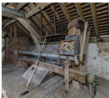
Étage en surcroît, partie est vue depuis le sud-ouest : le mouilleur à blé, avec sa vis sans fin, et l'élévateur qui y est adossé. A l'autre extrémité, la chambre à blé propre. Phot. Yves Guillotin IVR52_20205300045NUCA
