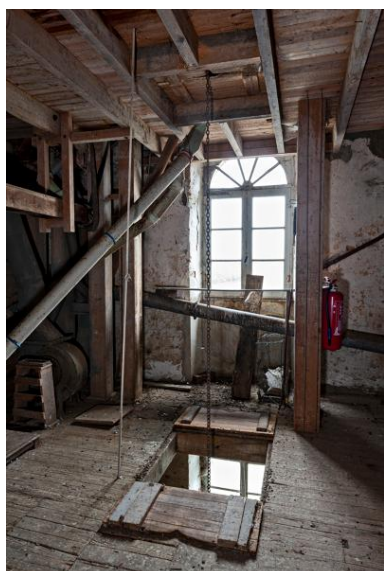
Étage en surcroît, partie sud vue depuis le nord : le monte-sac et les élévateurs à godets sud. Phot. Yves Guillotin IVR52_20205300006NUCA
