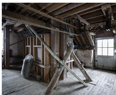
Étage en surcroît, partie sud-ouest vue depuis le nord-est : la chambre à farine installée en 1981. Phot. Yves Guillotin IVR52_20205300048NUCA
