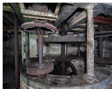
Rez-de-chaussée : le système de transmission, situé dans la poquerie, vu depuis l'ouest. Phot. Yves Guillotin IVR52_20205300061NUCA
