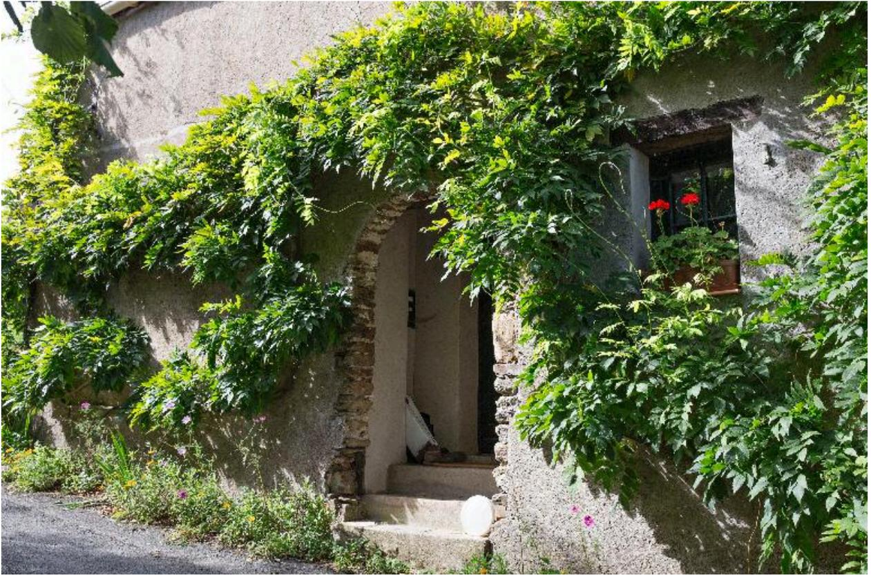
Maison avec porte en arc segmentaire en dalles de schiste recouverte par un enduit en ciment. impasse des Sineaux, CT01-514, cadastre 2018.
