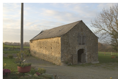
L'étable à chevaux vue depuis le sud-est. Phot. François Lasa IVR52_20045303447NUCA
