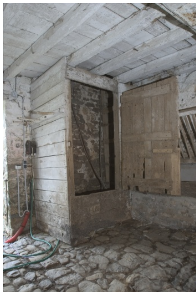
Vue intérieure de l'étable à chevaux : l'abat-foin. Phot. François Lasa IVR52_20045303450NUCA
