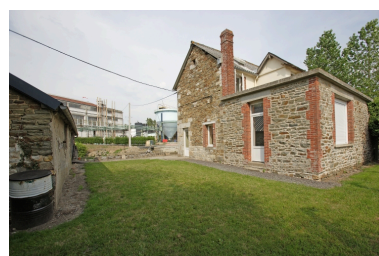
Le logis vu depuis le sud-ouest.
