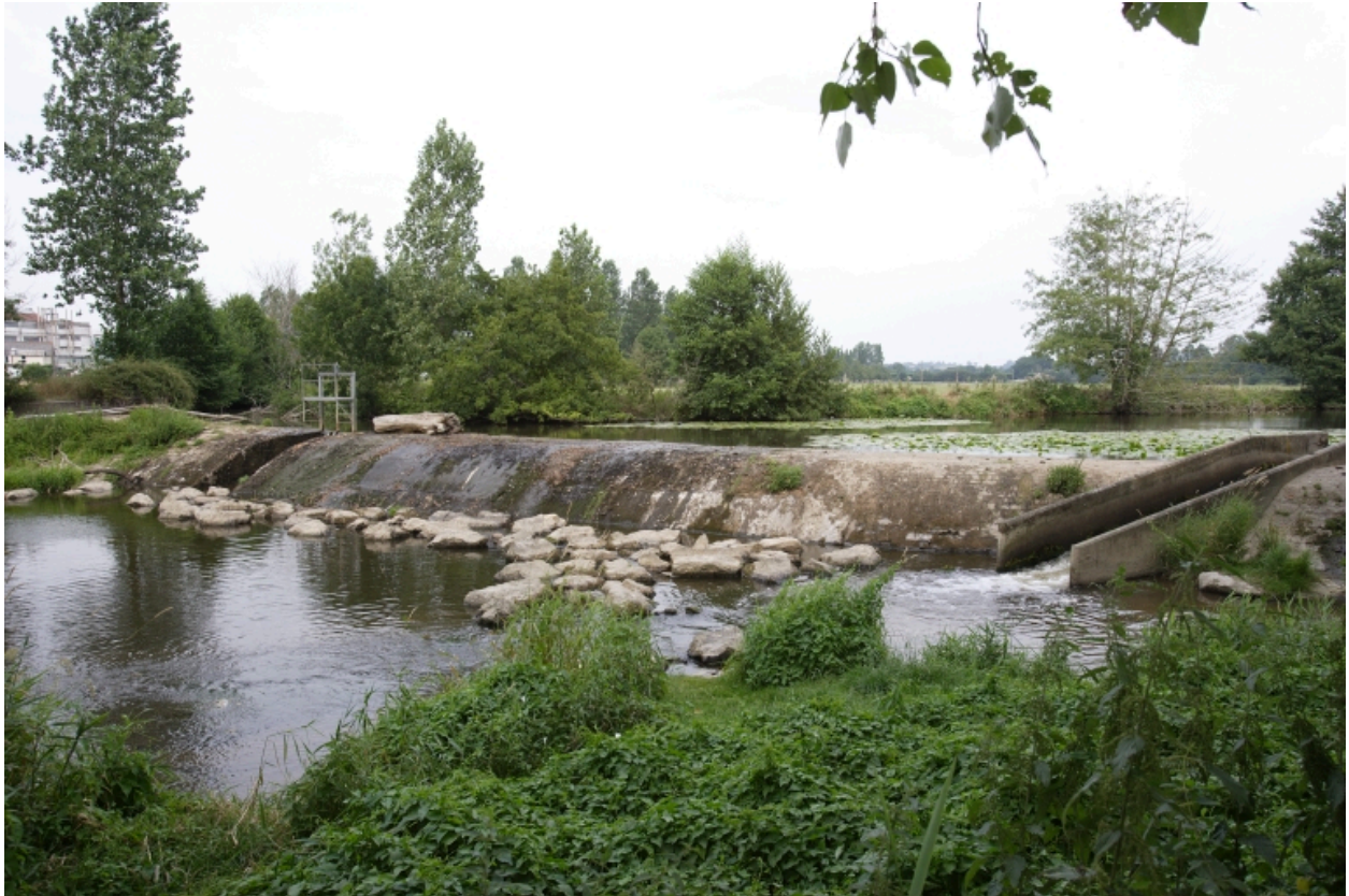
Le barrage de Corberie, sur la dérivation de la rivière, vu depuis le sud.
