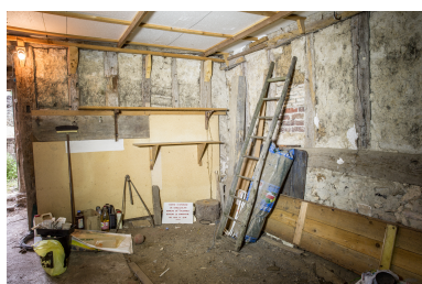
Des cloisons à pans de bois entre les logements en rez-de-chaussée. Phot. Pierre-Bernard Fourny IVR52_20187201940NUCA
