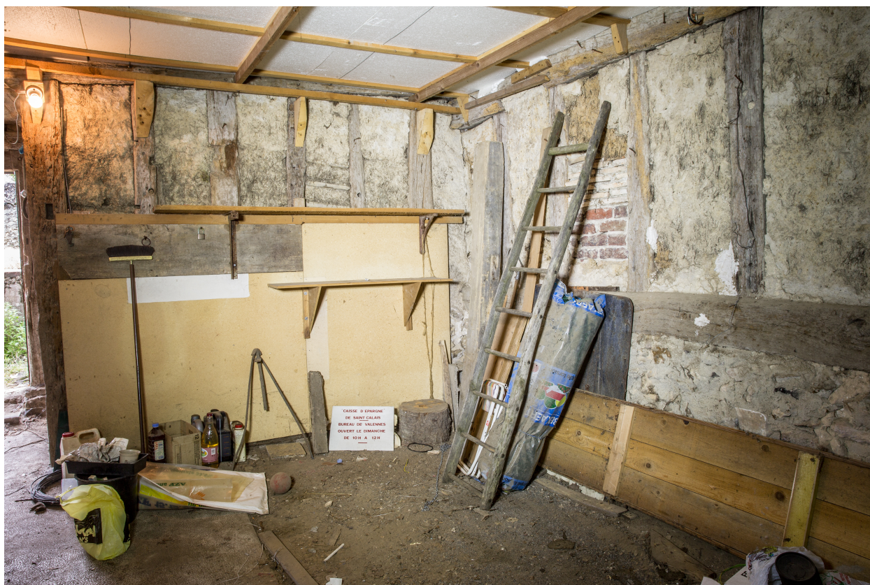
Des cloisons à pans de bois entre les logements en rez-de-chaussée.
