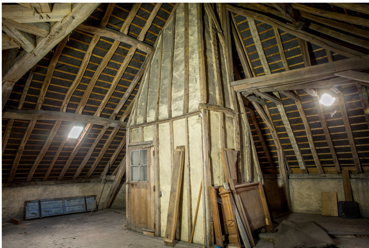
La cage d'escalier de la maison principale.
