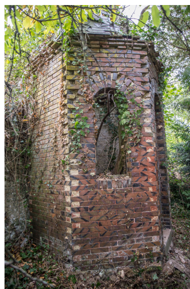
Le belvédère. Phot. Pierre-Bernard Fourny IVR52_20187201943NUCA
