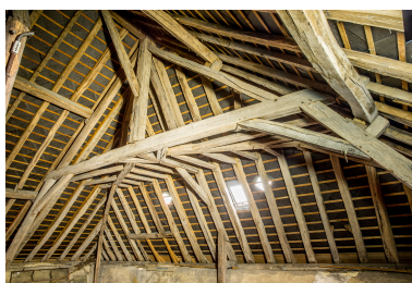
La charpente de la maison principale. Phot. Pierre-Bernard Fourny IVR52_20187201937NUCA
