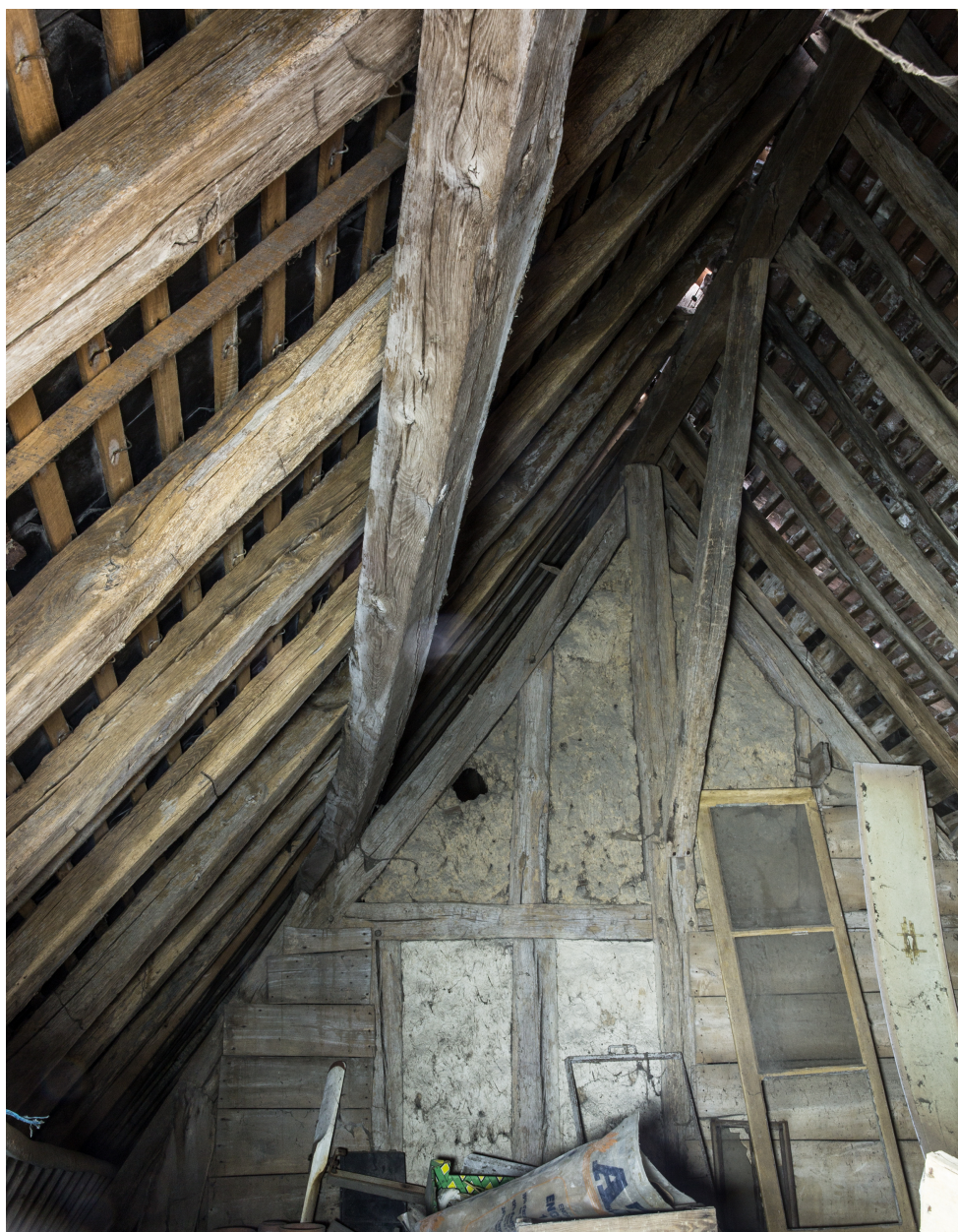
La charpente du logement à pièce unique.
