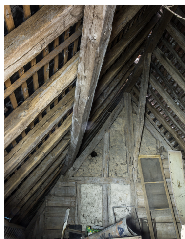
La charpente du logement à pièce unique. Phot. Pierre-Bernard Fourny IVR52_20187201942NUCA
