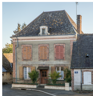
La maison principale. Phot. Pierre-Bernard Fourny IVR52_20187202056NUCA
