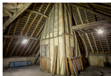
La cage d'escalier de la maison principale. Phot. Pierre-Bernard Fourny IVR52_20187201938NUCA
