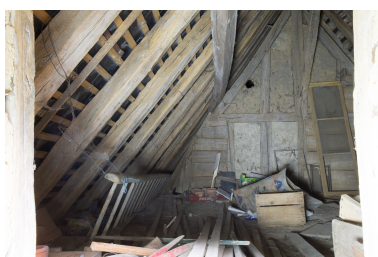
La charpente du logement à pièce unique. Phot. Pierre-Bernard Fourny IVR52_20187201941NUCA
