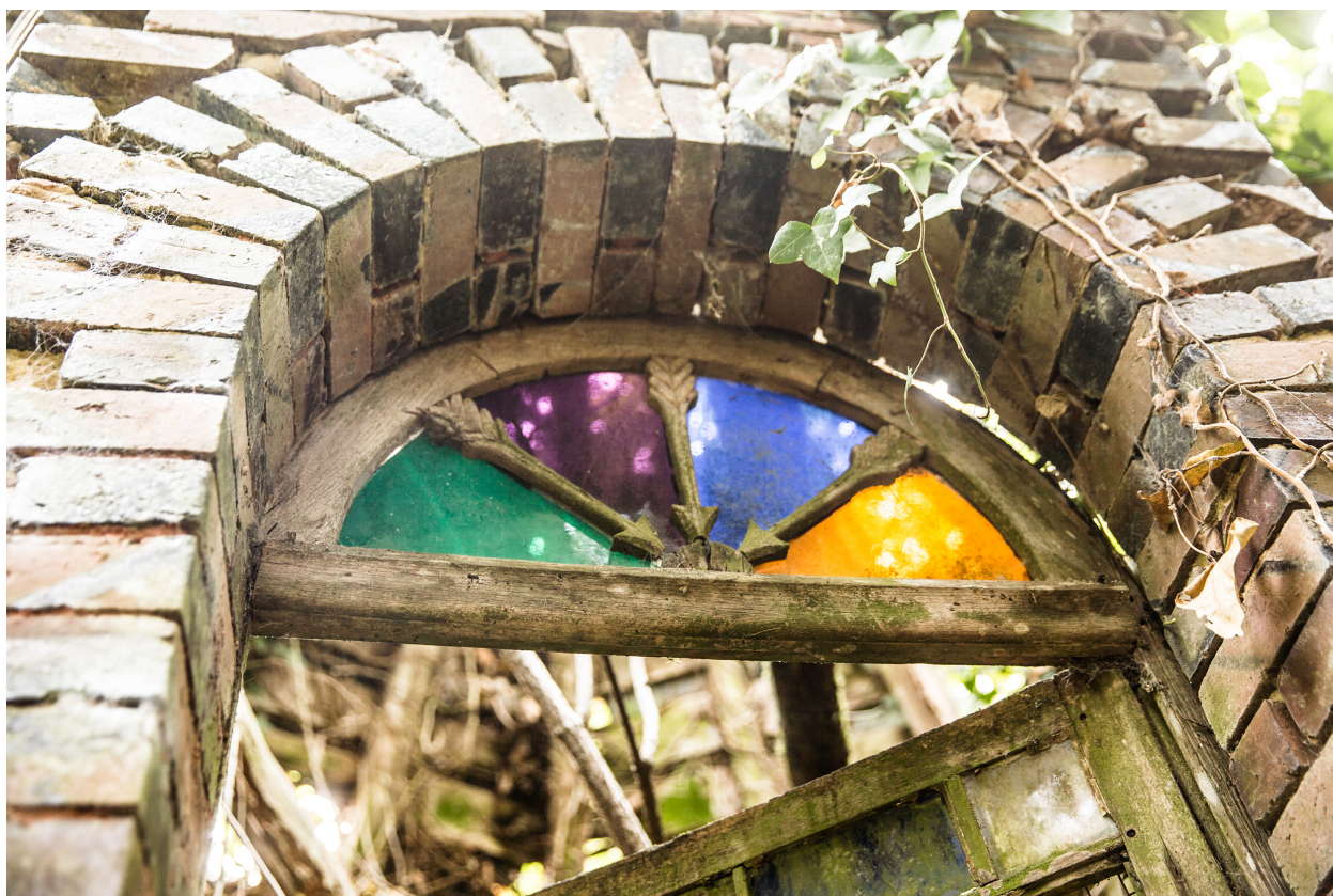
Un détail de l'imposte de la porte du belvédère.
