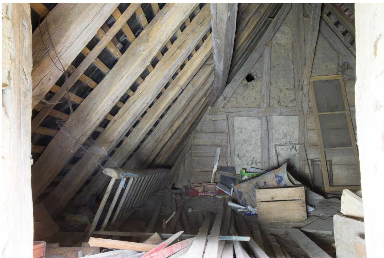
La charpente du logement à pièce unique.
