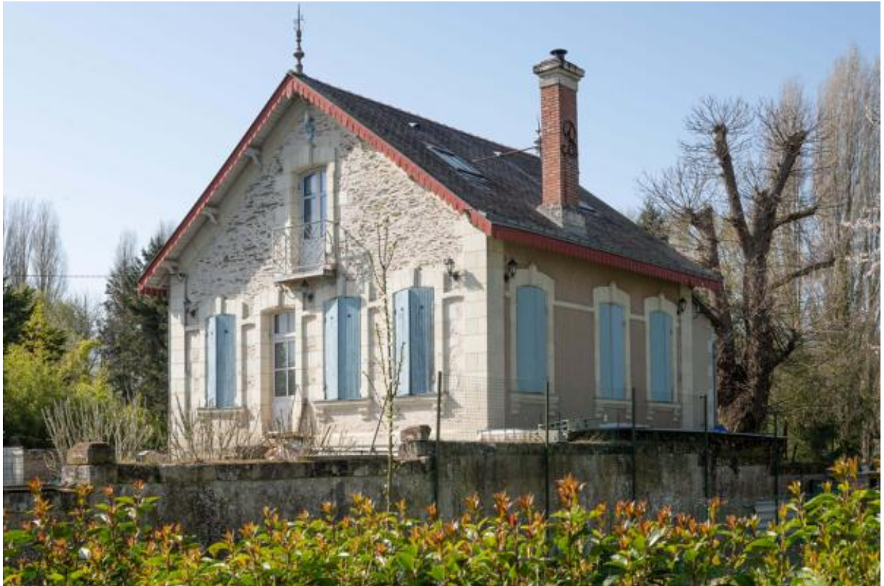
La Comète. Vue depuis le nord-est.
