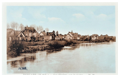
Les chalets sur la Loire (inondations de février 1904), carte postale, 1er quart 20e siècle. Repro. Bruno Rousseau IVR52_20174900079NUCA
