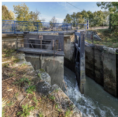
Porte de flot de l'écluse du Dareau. Phot. Pierre-Bernard Fourny IVR52_20184400653NUCA
