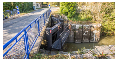
Vue du pont routier sur l'écluse. Phot. Pierre-Bernard Fourny IVR52_20184400654NUCA
