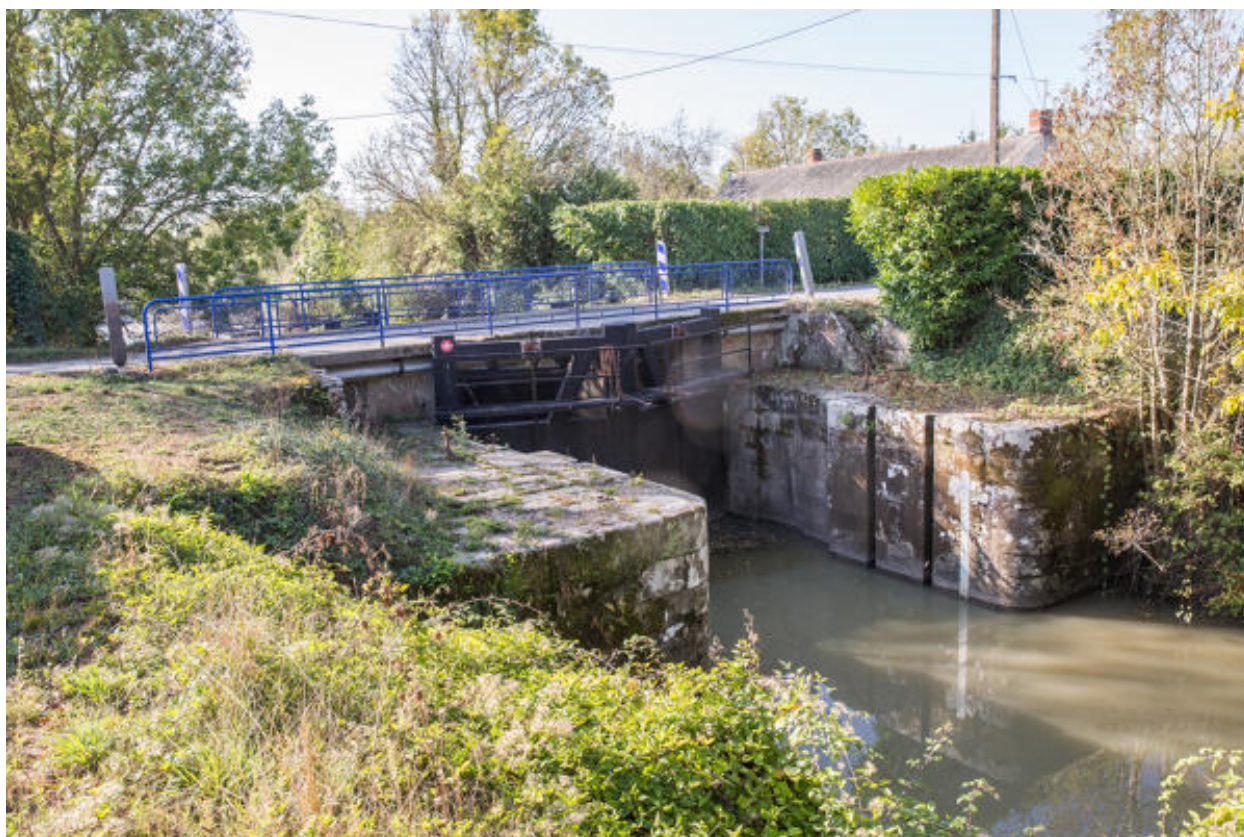
Vue générale de l'écluse vers le sud.
