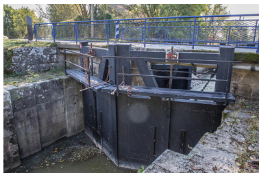
Porte d'èbe de l'écluse du Dareau. Phot. Pierre-Bernard Fourny IVR52_20184400652NUCA
