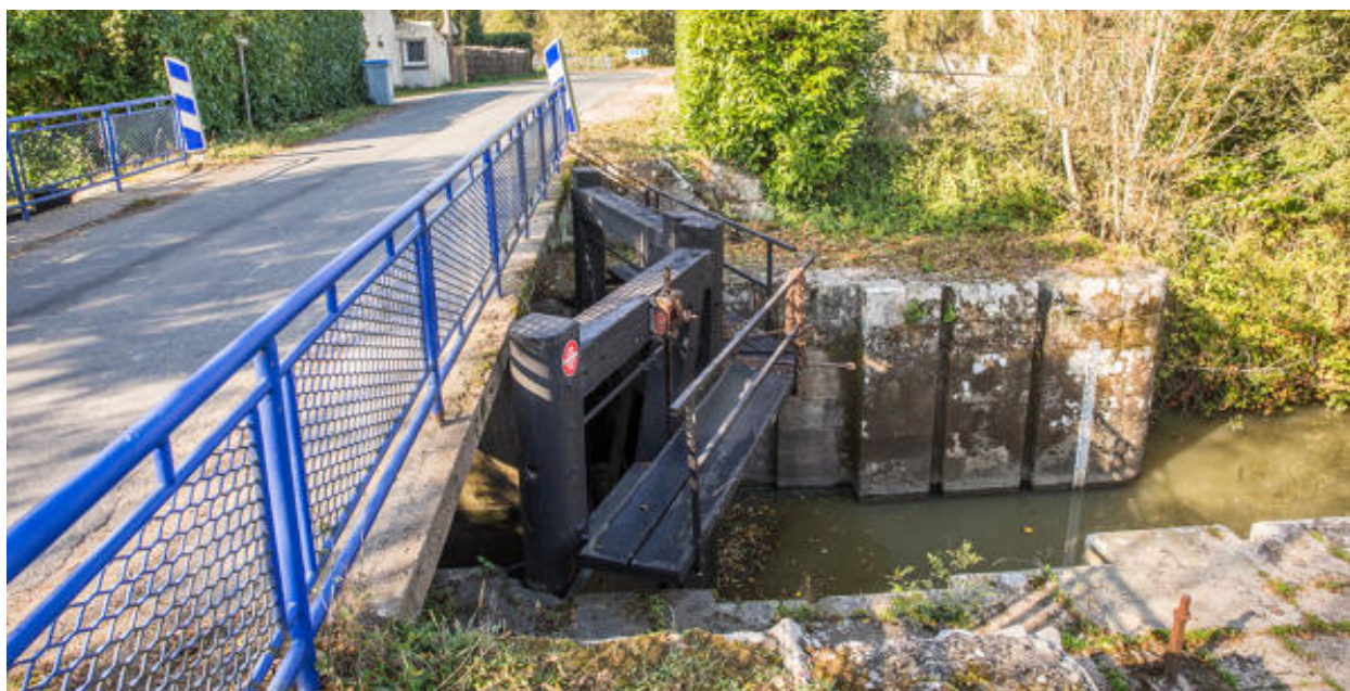
Vue du pont routier sur l'écluse.
