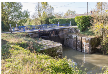
Vue générale de l'écluse vers le sud. Phot. Pierre-Bernard Fourny IVR52_20184400650NUCA
