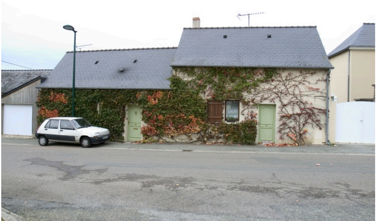
Vue depuis la route.
