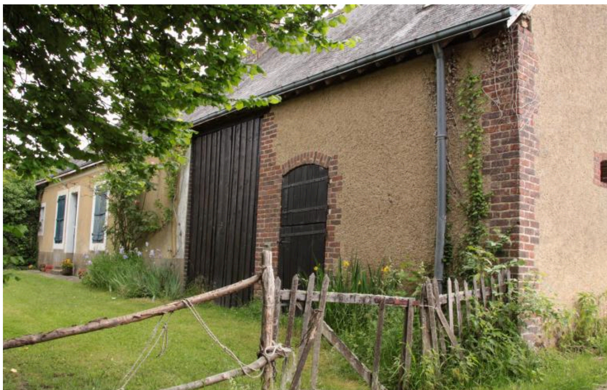
Grange et étable dans le prolongement de la maison.
