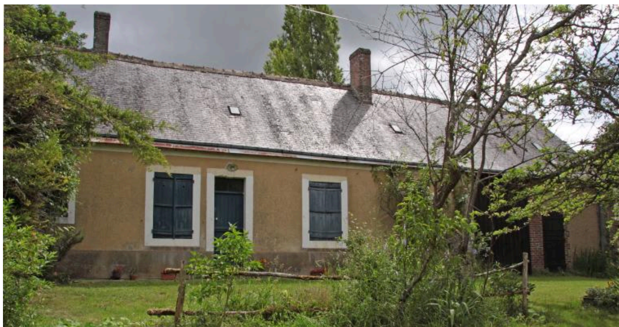
Vue d'ensemble prise depuis le sud.
