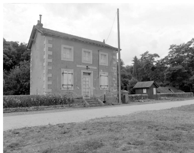
La maison éclusière. Phot. François Lasa IVR52_20025300999X
