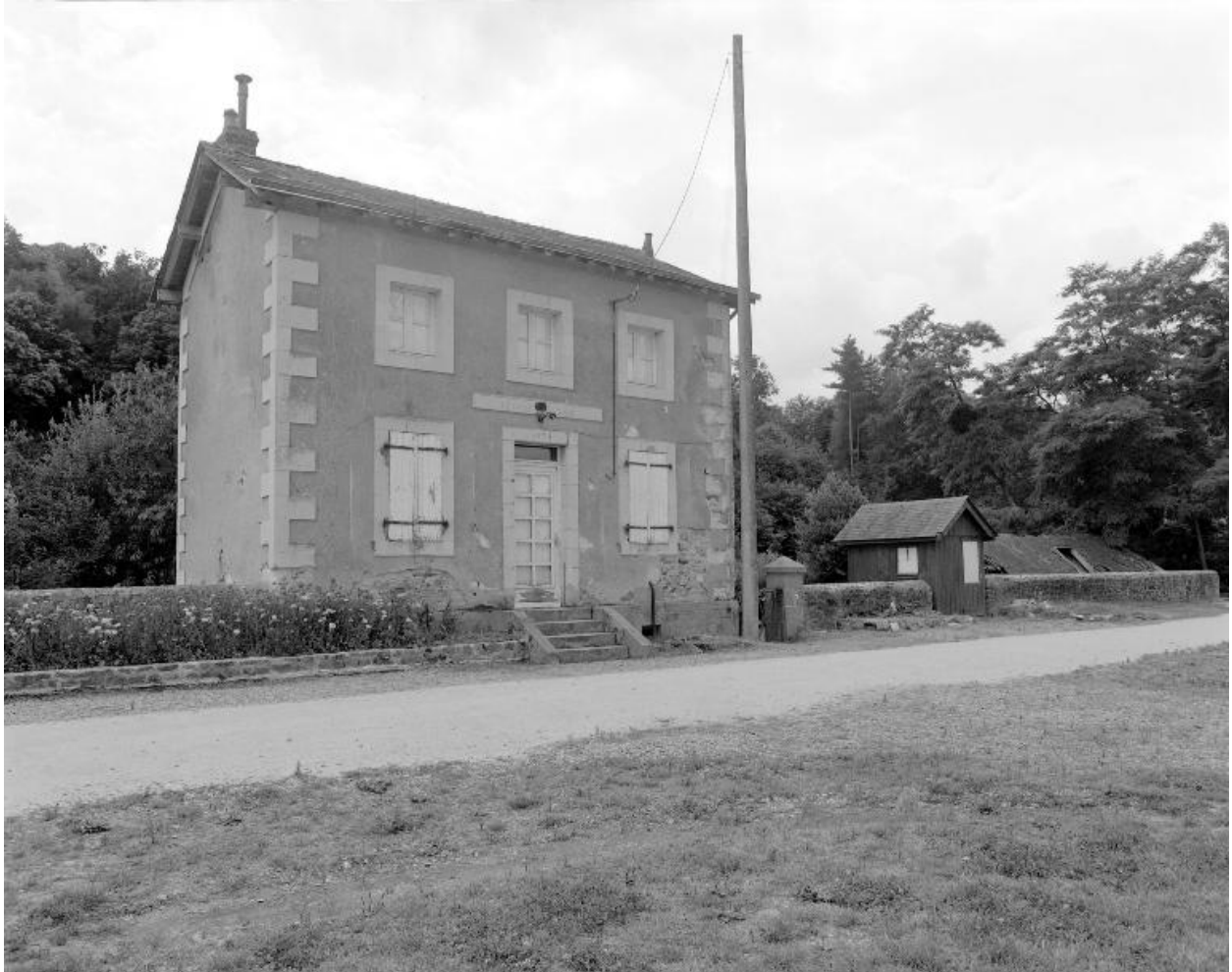
La maison éclusière.
