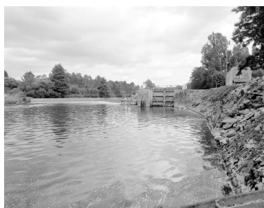
Vue d'ensemble du site depuis la rive gauche, en aval : barrage, centrale micro-électrique, écluse, maison éclusière. Phot. François Lasa IVR52_20025301000X
