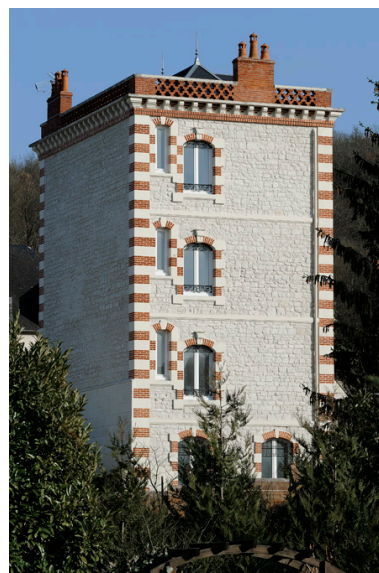
Façade postérieure Phot. Bruno Rousseau, Phot. Youenn Communeau IVR52_20114900637NUCA
