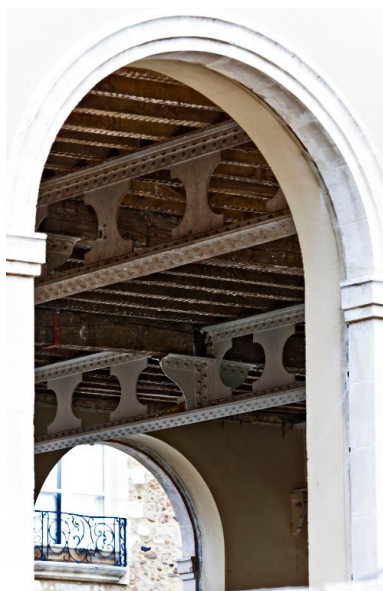
Poutrelles en fer mises en place lors des travaux de 1907-1909. Phot. Yves Guillotin IVR52_20177200744NUCA
