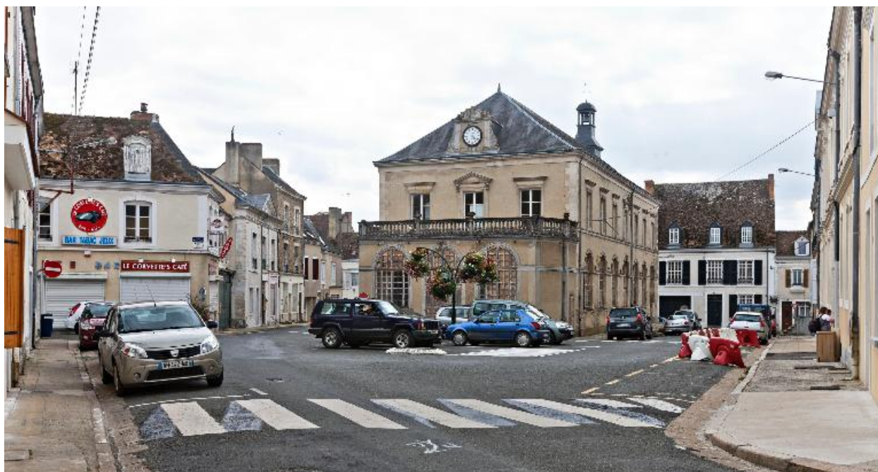
Vue générale depuis l'est.
