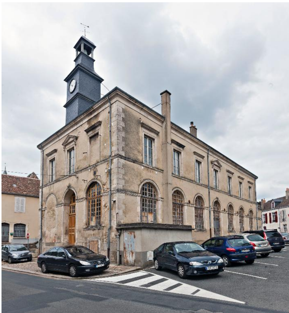
Vue depuis le sud.
