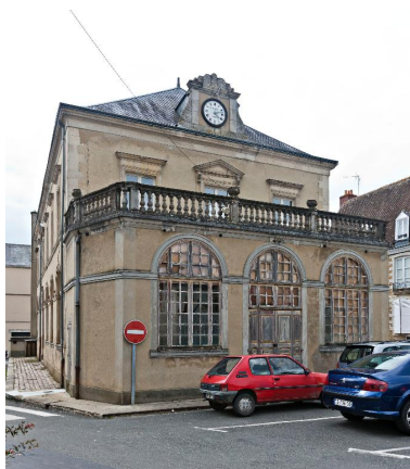
Le corps accoté en 1931 au mur-pignon est. Phot. Yves Guillotin IVR52_20147201933NUCA
