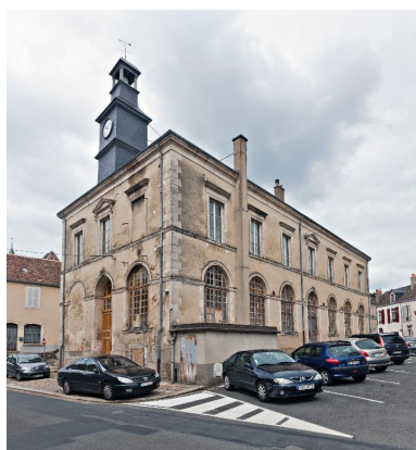
Vue depuis le sud. Phot. Yves Guillotin IVR52_20147201932NUCA
