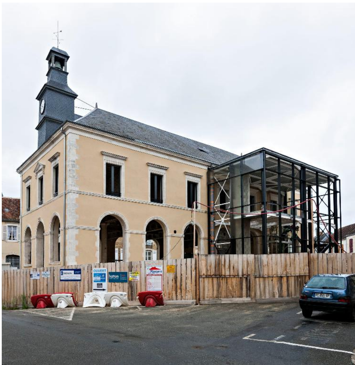
Etat en cours de travaux en août 2017.
