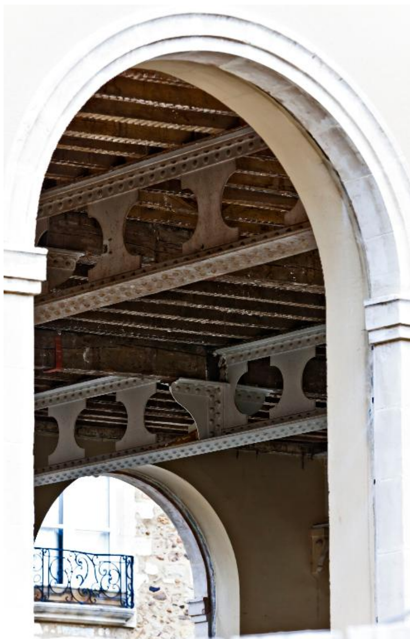
Poutrelles en fer mises en place lors des travaux de 1907-1909.
