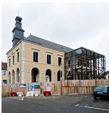
Etat en cours de travaux en août 2017. Phot. Yves Guillotin IVR52_20177200746NUCA
