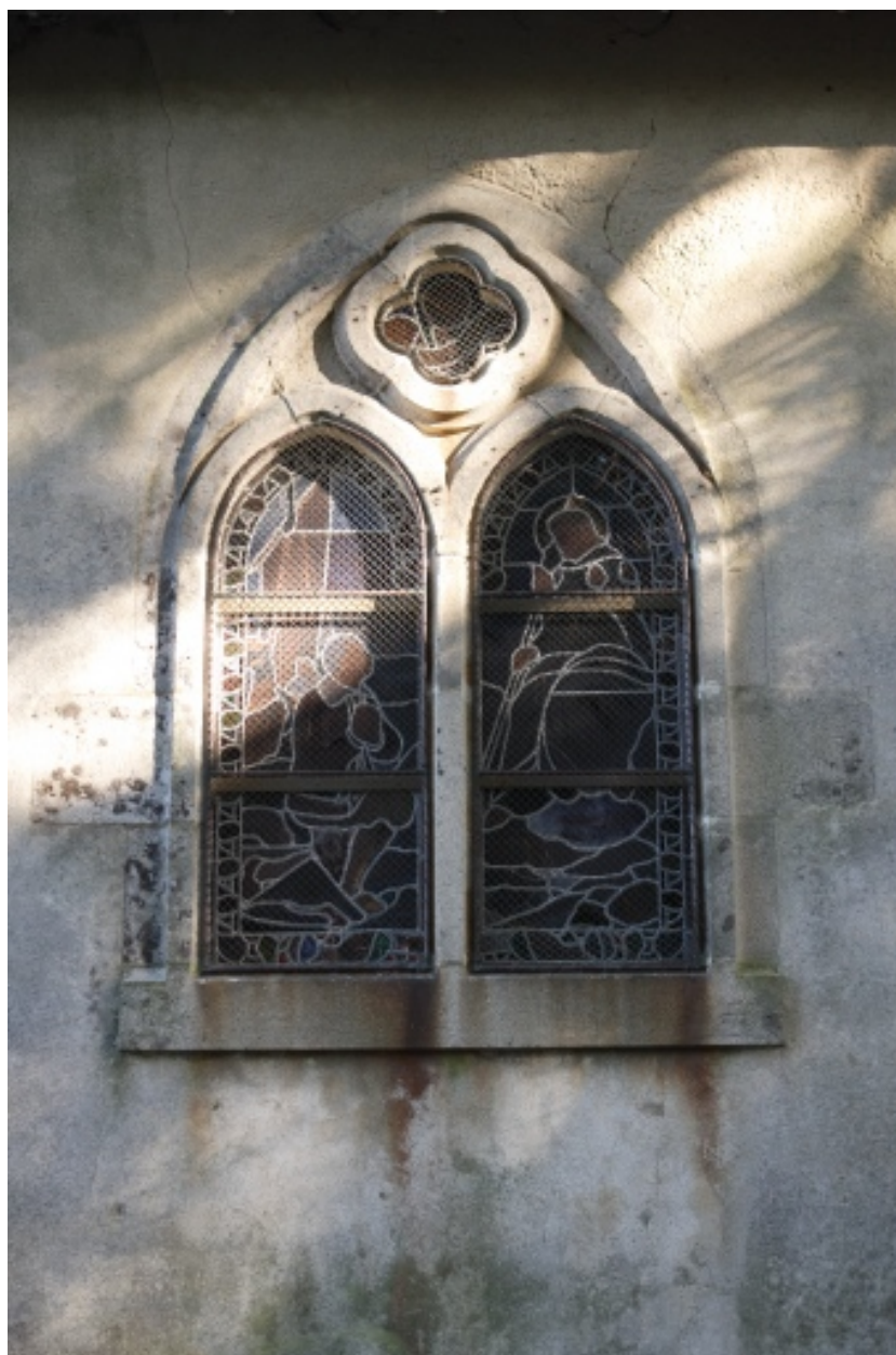
Détail de la baie géminée sud.
