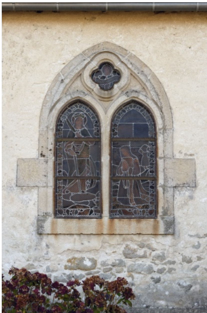
Détail de la baie géminée nord.
