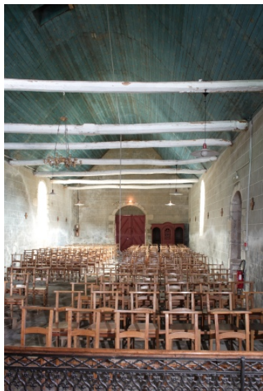
Vue de l'intérieure de la chapelle depuis le chœur. Phot. Denis Pillet IVR52_20074401208NUCA
