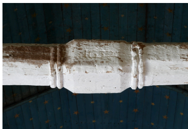
Détail de la date 1632 gravée sur un entrain de la charpente. Phot. Denis Pillet IVR52_20074401210NUCA
