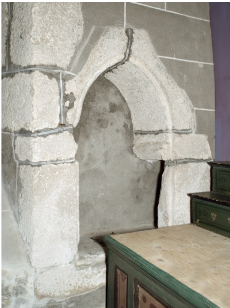
Détail d'une niche sur le mur gouttreau nord.
