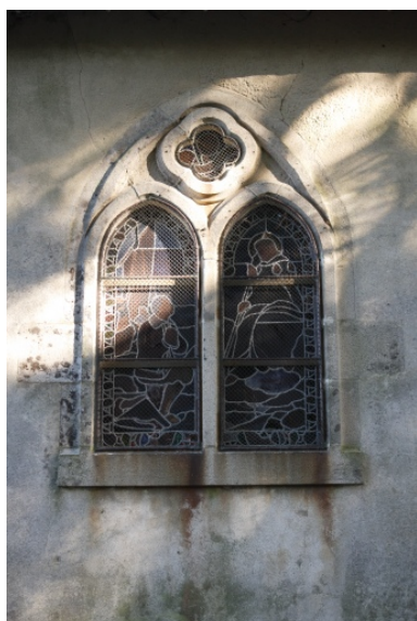
Détail de la baie géminée sud. Phot. Denis Pillet IVR52_20074401273NUCA
