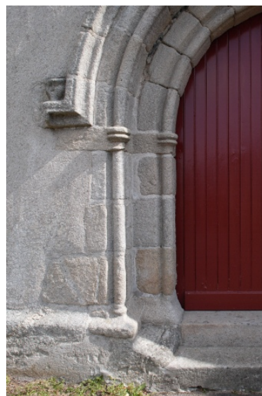
Détail du piédroit gauche du portail occidental. Phot. Denis Pillet IVR52_20074401218NUCA
