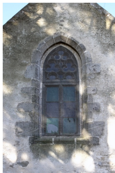
Détail de la baie du chevet. Phot. Denis Pillet IVR52_20074401274NUCA
