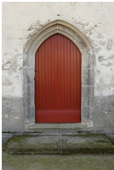
Détail de la porte nord. Phot. Denis Pillet IVR52_20074401279NUCA
