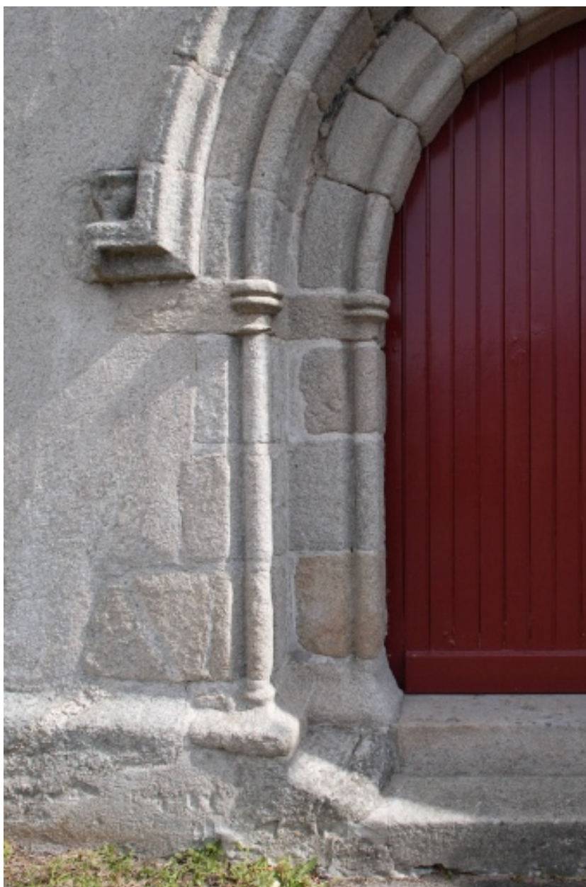
Détail du piédroit gauche du portail occidental.
