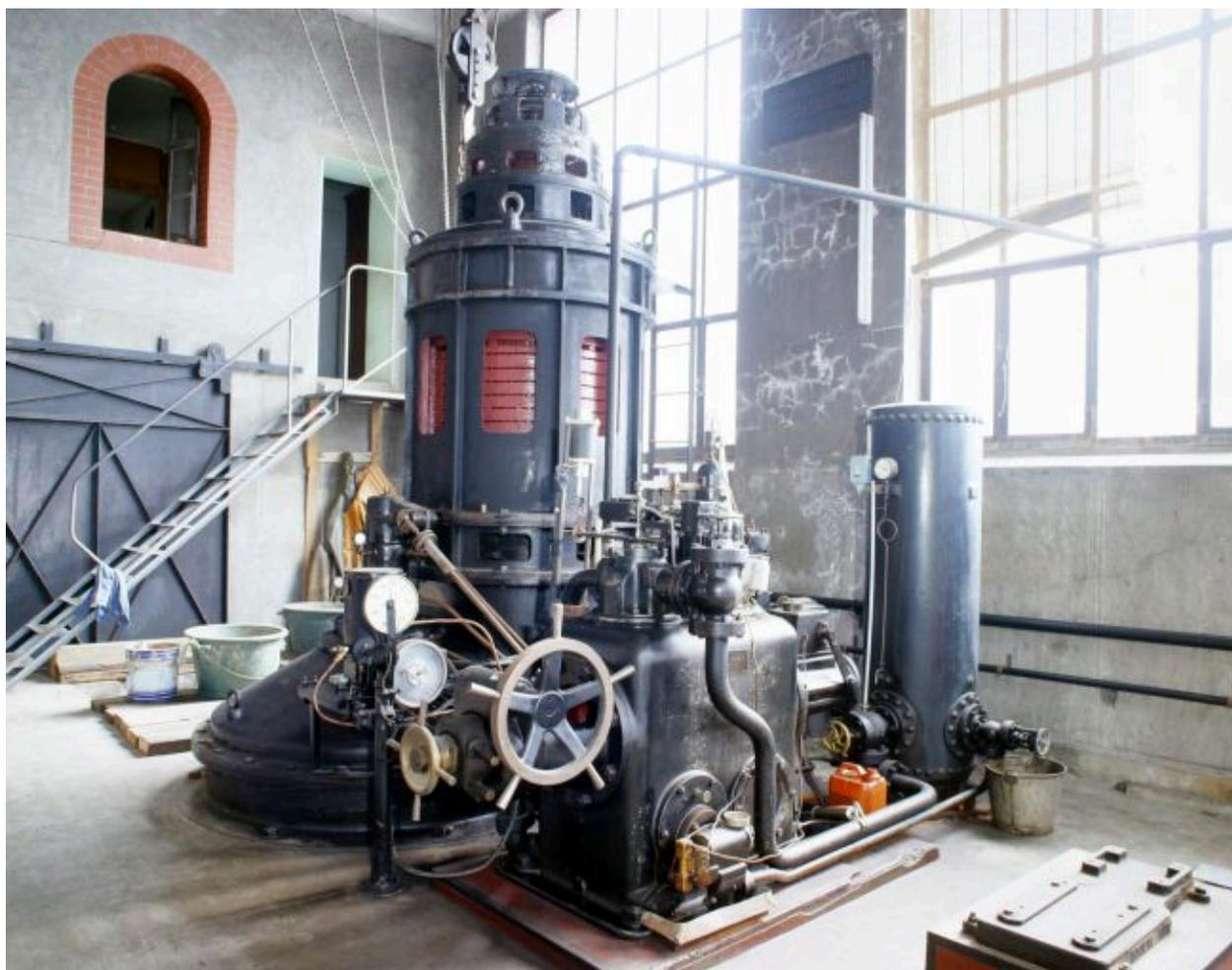
Machine énergétique, comprenant le régulateur de la turbine, l'amplificateur et le générateur électrique alternatif.
