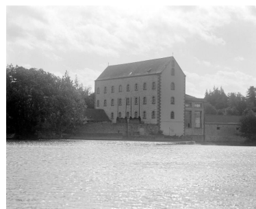
Façades nord et ouest de l'ancien moulin vus depuis la rive droite, en amont. Phot. François Lasa IVR52_20015300491X
