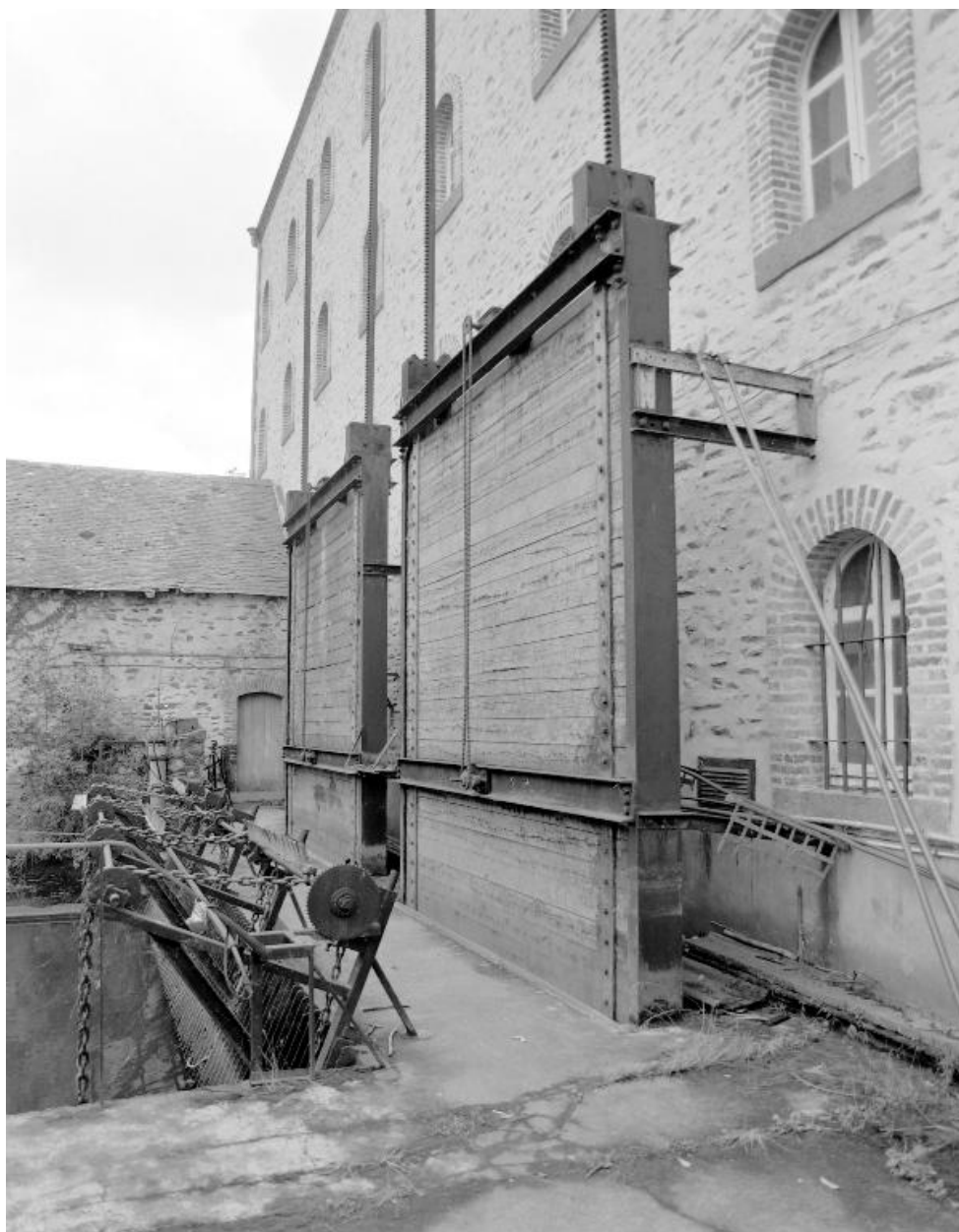
Vue de l'ouest des vannes motrices situées sur le flanc nord de l'ancien moulin.
