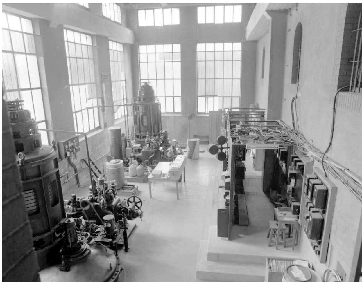
La salle des machines. Vue d'ensemble depuis la galerie est.
