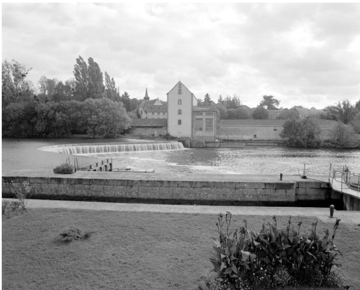
Façade ouest de l'ancien moulin et barrage vus depuis l'écluse, rive droite. A l'arrière plan, l'abbaye du Port du Salut.
