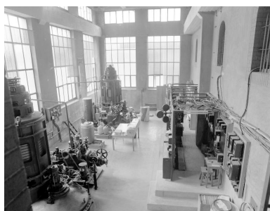
La salle des machines. Vue d'ensemble depuis la galerie est. Phot. François Lasa IVR52_20015300512X
