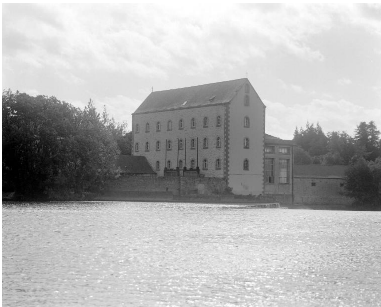
Façades nord et ouest de l'ancien moulin vus depuis la rive droite, en amont.
