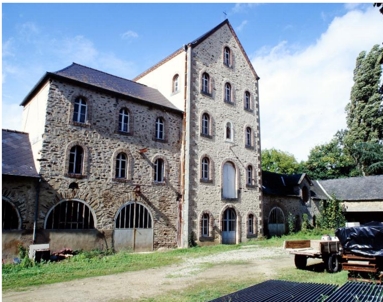
Façade est de l'ancien moulin depuis la cour située à l'intérieur de l'enceinte de l'abbaye du port du Salut.
