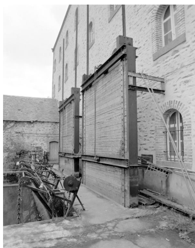
Vue de l'ouest des vannes motrices situées sur le flanc nord de l'ancien moulin. Phot. François Lasa IVR52_20015300519X
