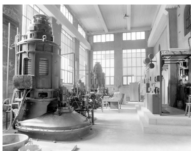
La salle des machines. Vue d'ensemble depuis l'entrée est : à gauche, les deux machines énergétiques ; à droite, le tableau de commande. Phot. François Lasa IVR52_20015300514X
