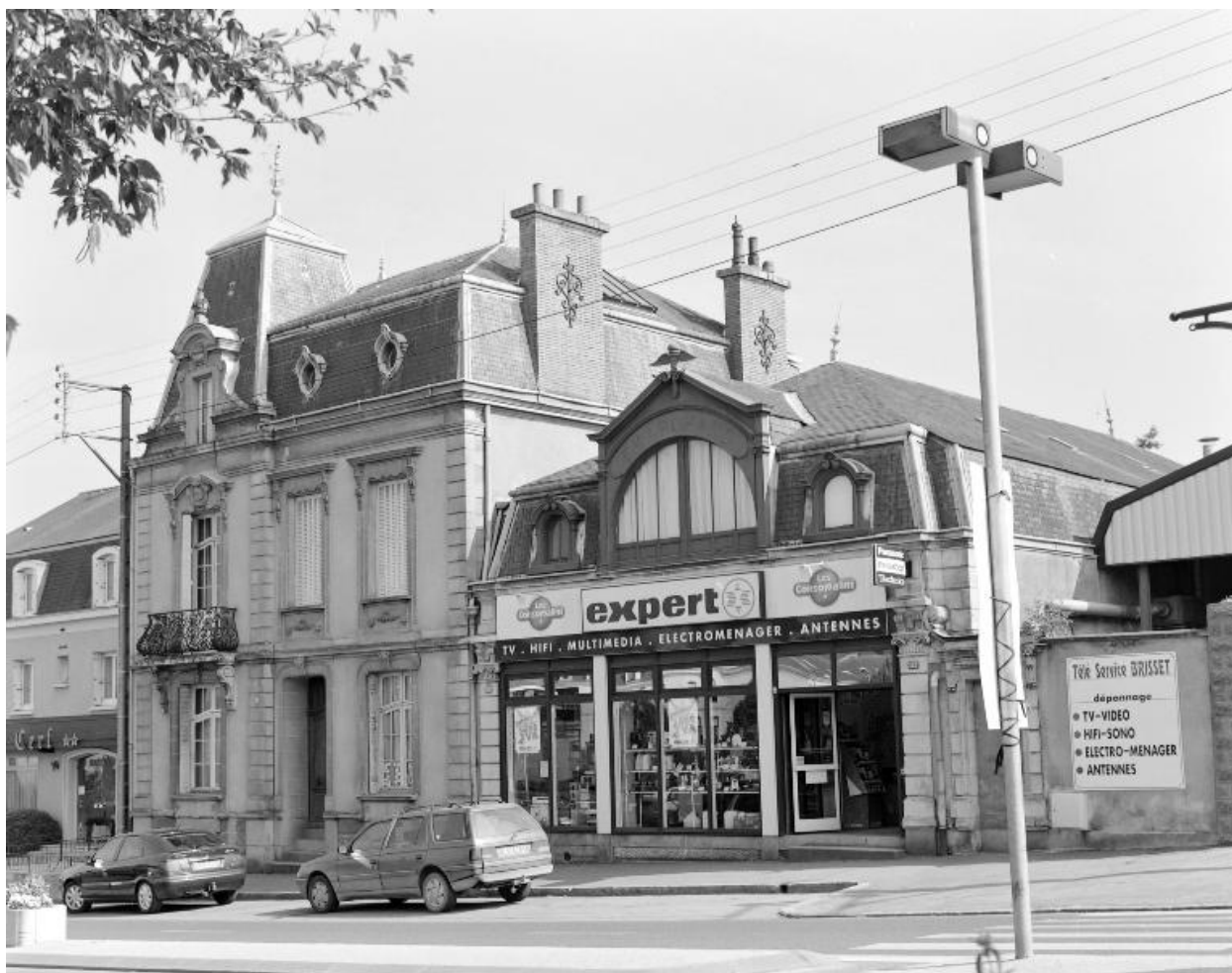
La façade sur rue après transformation.
