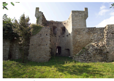
Élévation interne. Phot. Denis Pillet IVR52_20064402108NUCA
